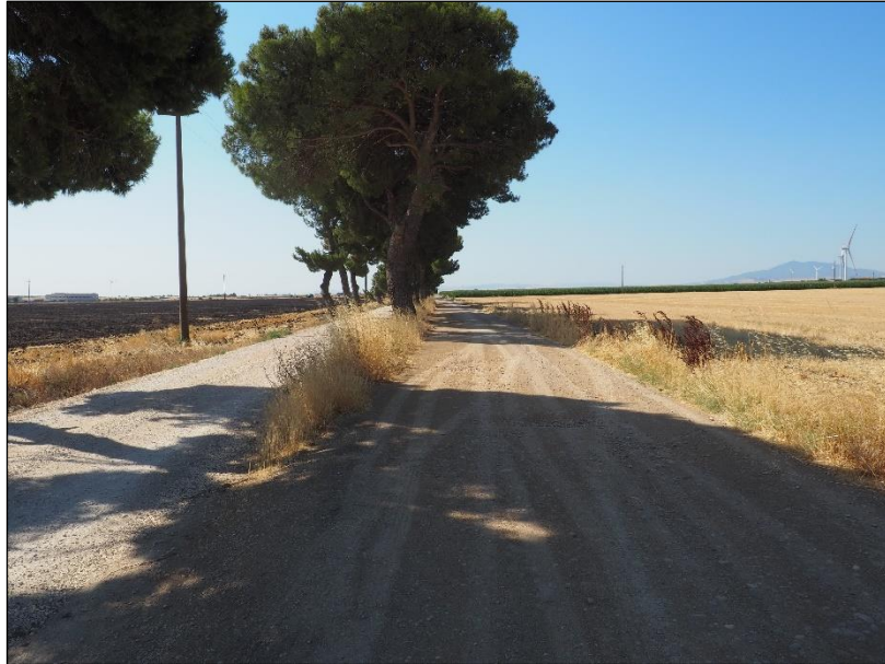
Foto.16.3 – Visuale sud sud est
