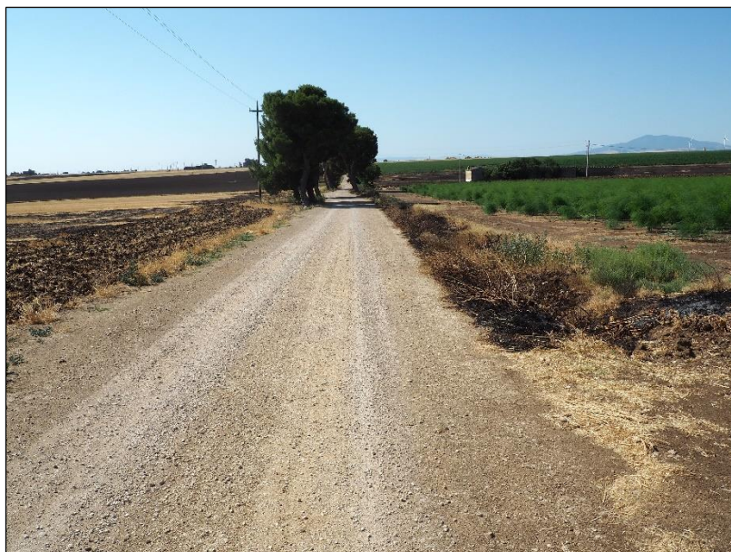
Foto.17.2 – Visuale sud sud est
