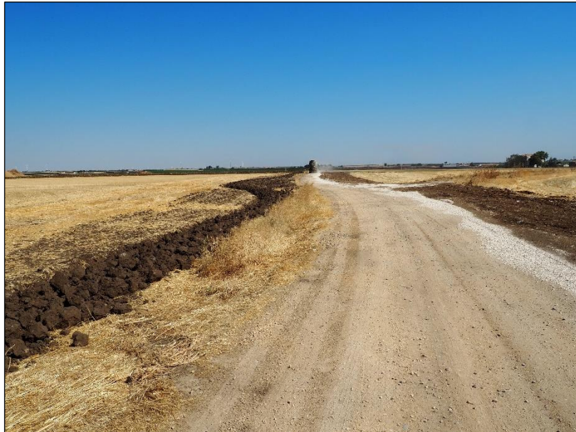
Foto.18.3 – Visuale nord nord ovest
