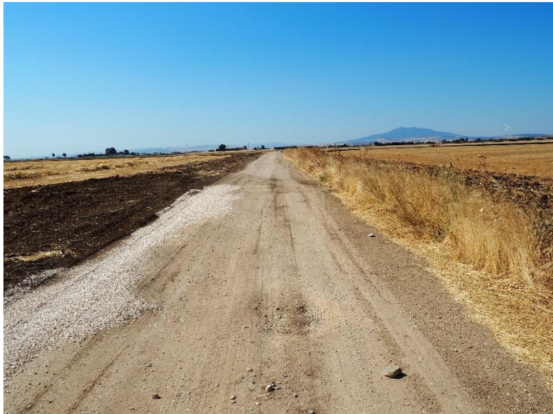
Foto.18.2 – Visuale sud sud est
