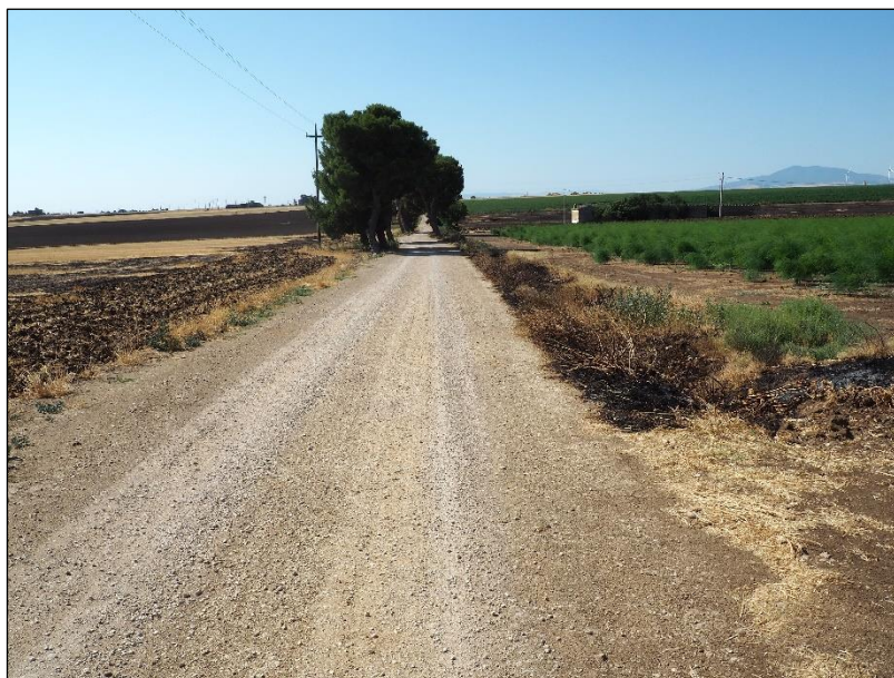
Foto.17.2 – Visuale sud sud est
