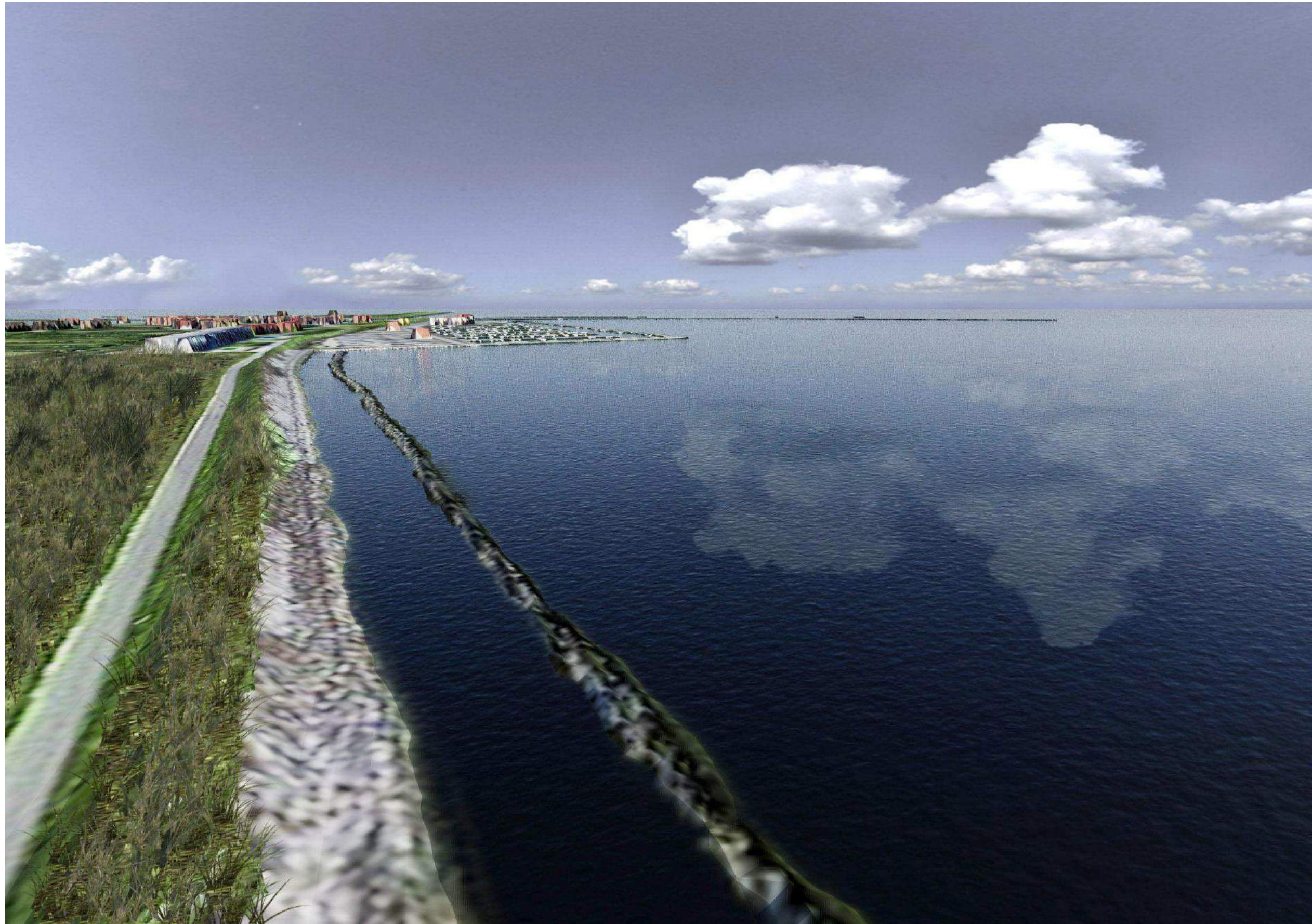
Vista 3: Stato di fatto - vista da sud-est dell'area d'intervento
