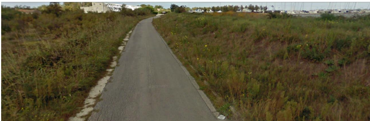
Figura 11: Stato di fatto via delle Valli Sud nell'area di intervento
