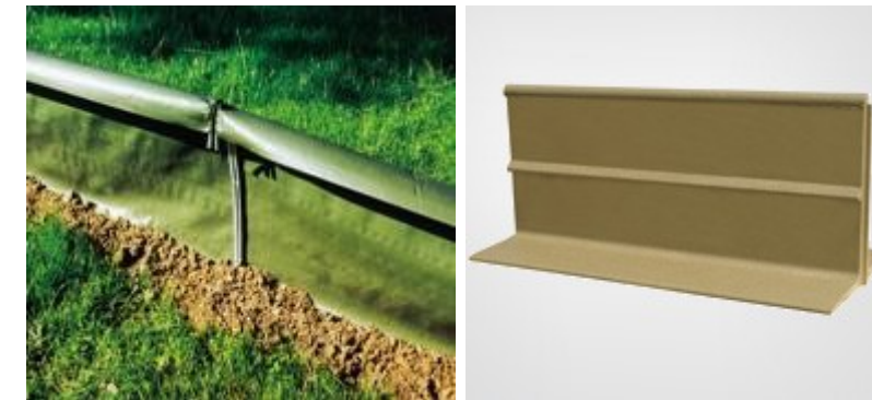
Figura 2-25: Tipologia delle barriere per la piccola fauna poste sulla viabilità
