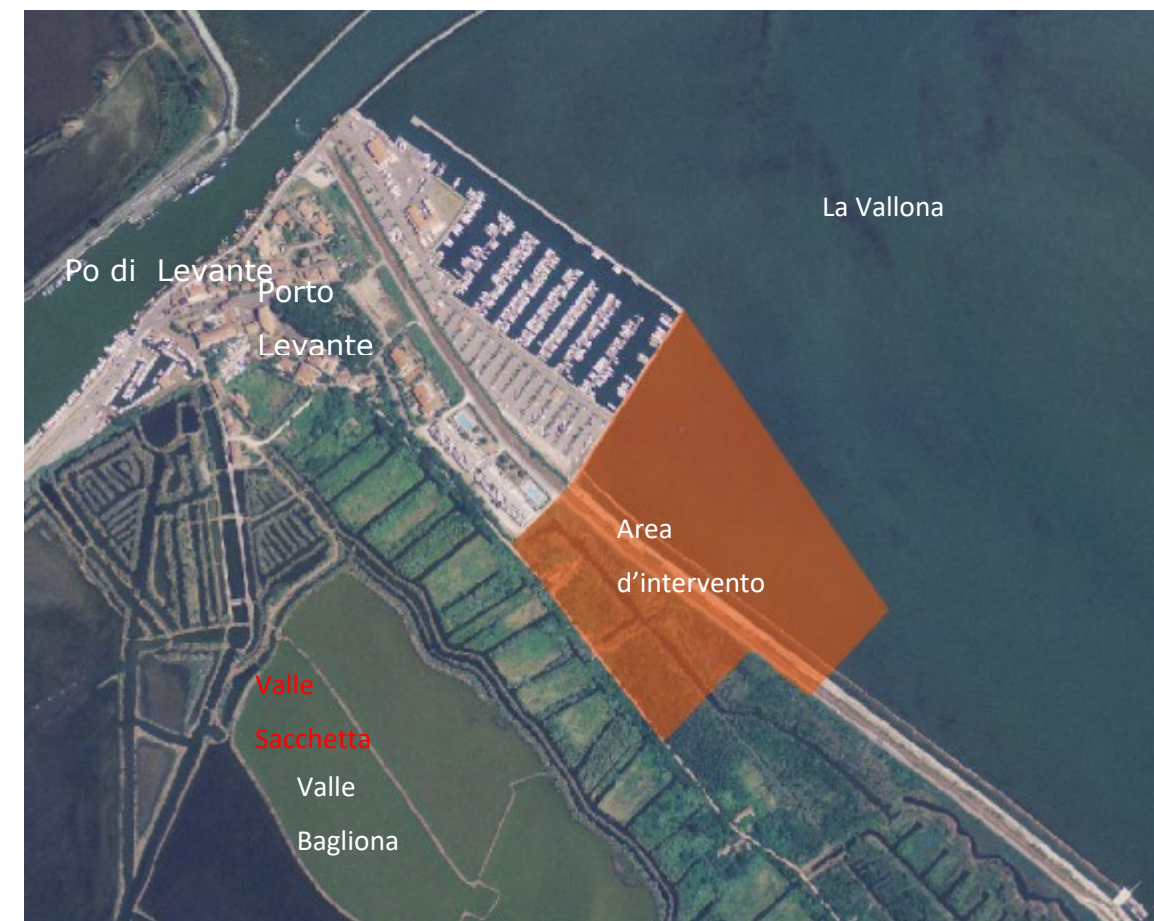
Figura 2-14: Panoramica con messa in evidenza dell' area di intervento
