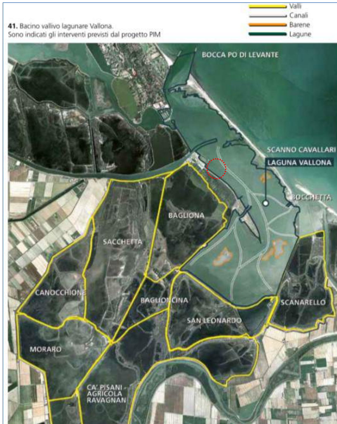
Figure 4-7: Foto aerea della laguna di la Vallona con indicazione degli interventi del Progetto di vivificazione e dell'area in cui è prevista la nuova darsena
