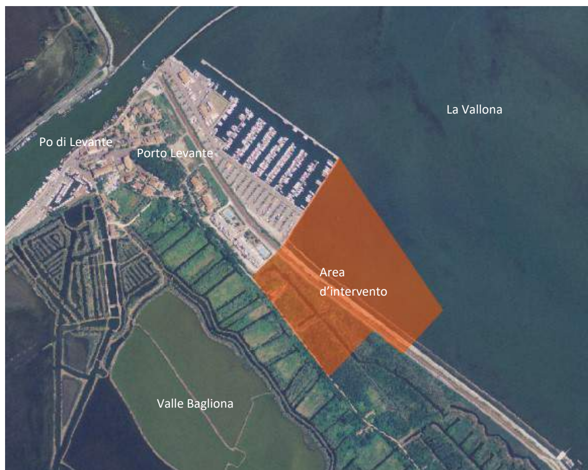
Figura 4-20: Panoramica con messa in evidenza dell' area di intervento
