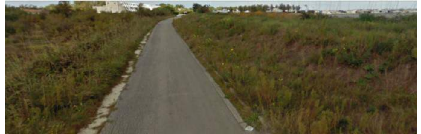
Figura 3-15: Stato di fatto via delle Valli Sud nell'area di intervento
