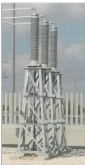
*Fig. 11. Terminale cavo AT tipo.*
