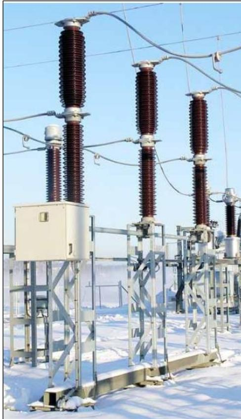
*Fig. 15. Particolare Interruttore con TA incorporato.*
