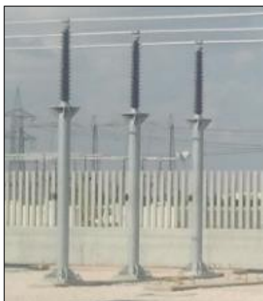
Fig. 17. Particolare in foto di tali supporti
