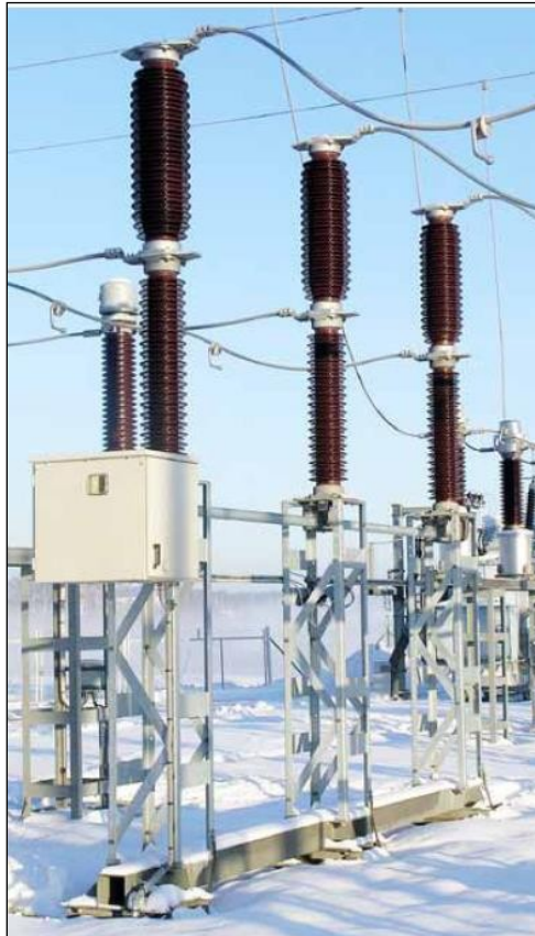
Fig. 15. Particolare Interruttore con TA incorporato.
