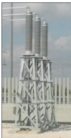
Fig. 11. Terminale cavo AT tipo.
