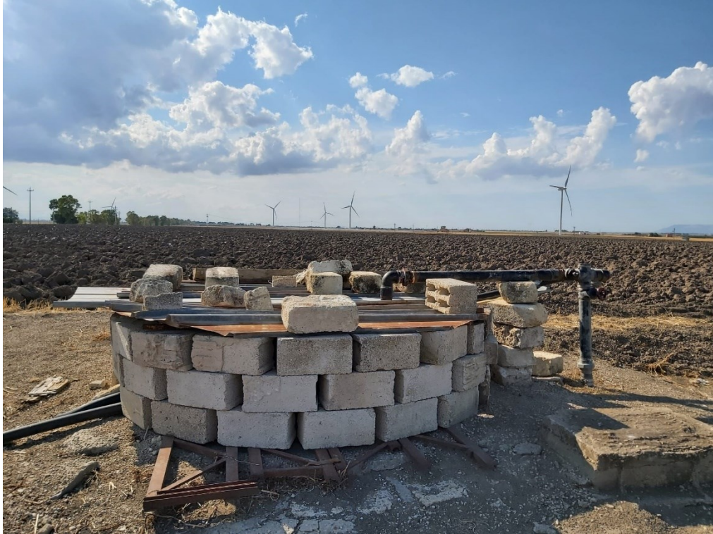
Impianto irriguo: presa aziendale pozzo artesiano
