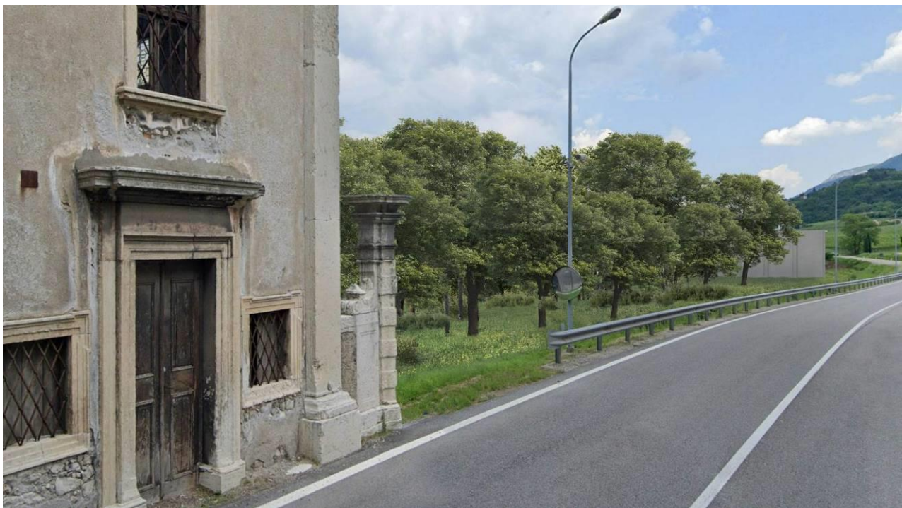
Figura 17 - Foto del punto di vista dell'osservatore, in prossimità dell'ingresso della Villa Bortolazzi, sulla Via Nazionale in corso d'opera.
