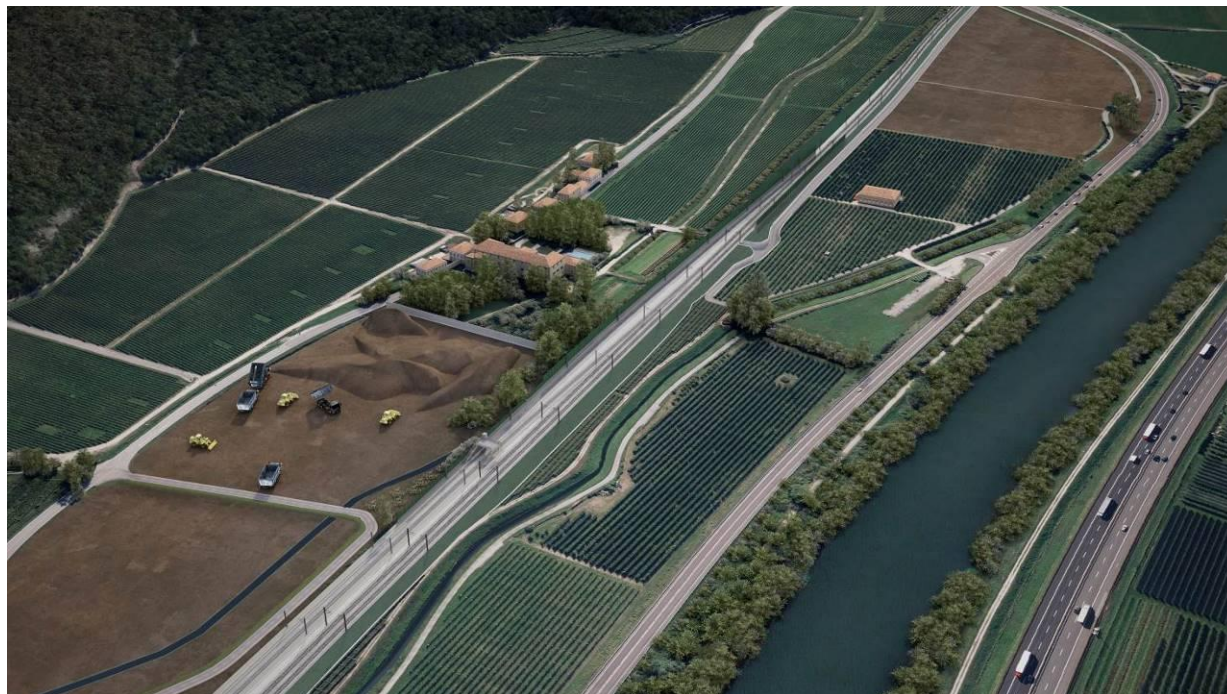
Figura 14 - Fotosimulazione aerea durante la fase di realizzazione dell'opera.
