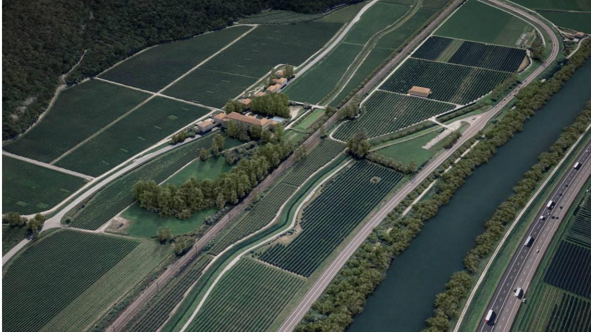
Figura 19 - Ripresa aerea scelta per rappresentare l'inserimento della fase di realizzazione dell'opera, in relazione al contesto attraversato.
