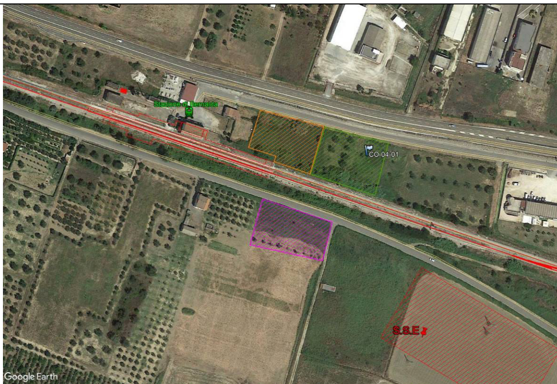
Vista aerea dell'area di cantiere
