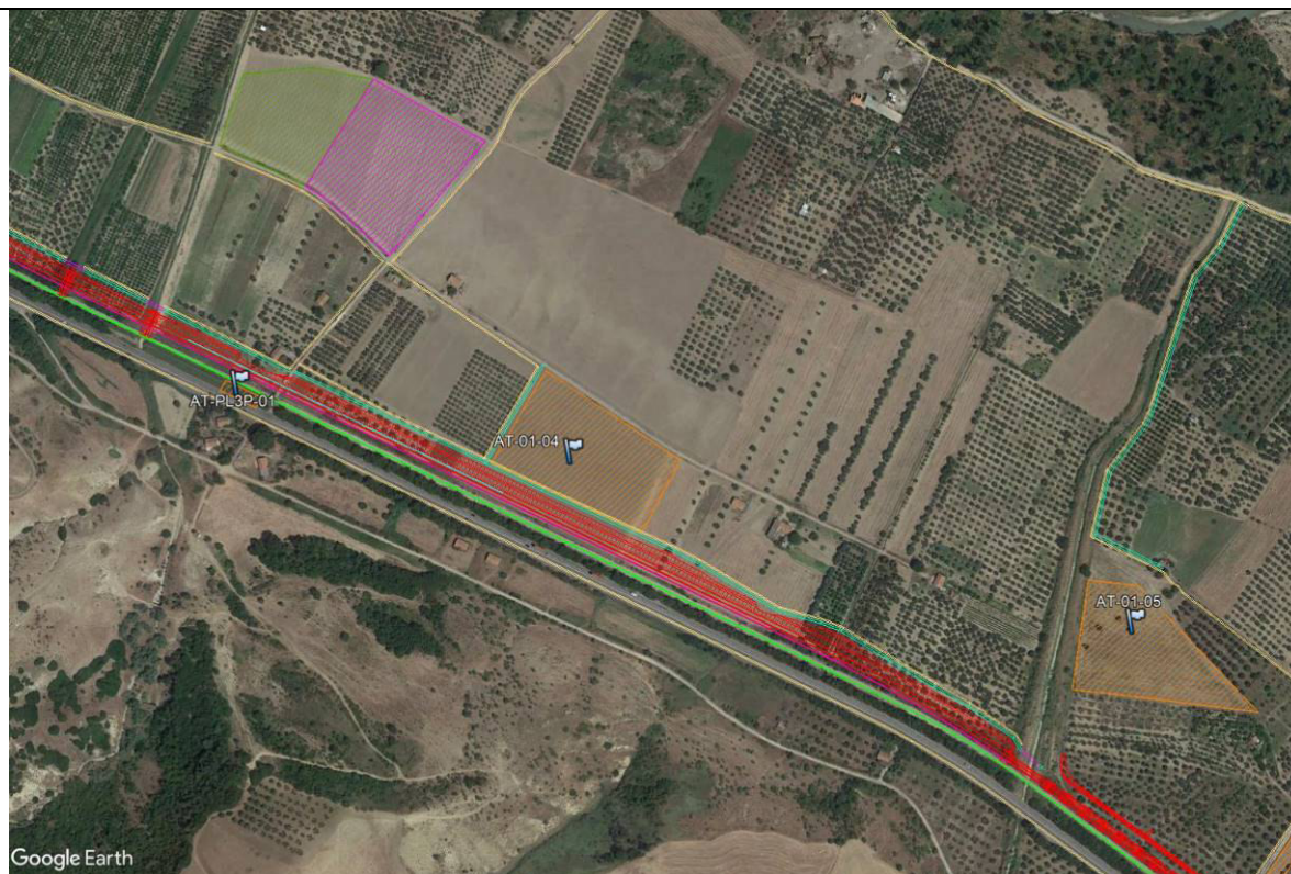
Vista aerea delle aree tecniche
