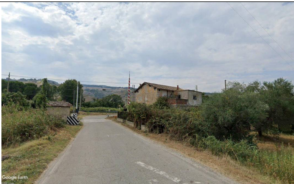
Vista accesso alle aree di cantiere in corrispondenza PL2
