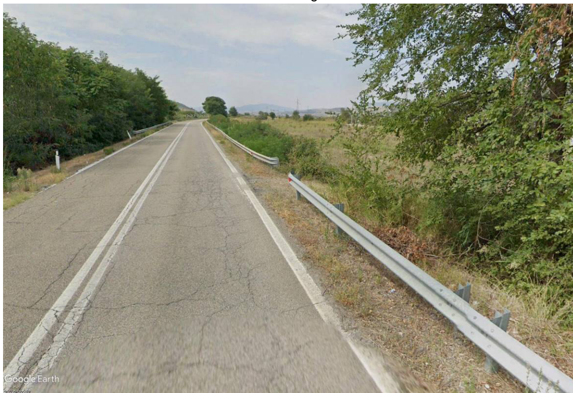
Foto 1 - Vista dell'accesso al cantiere
