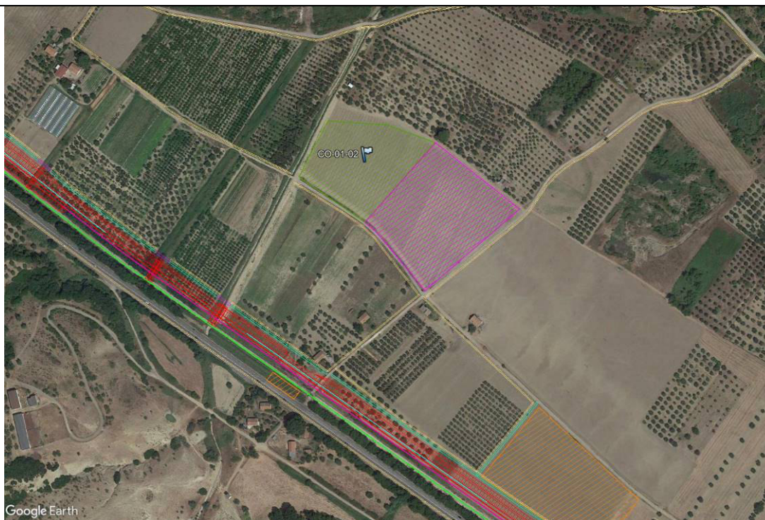
Vista aerea dell'area di cantiere
