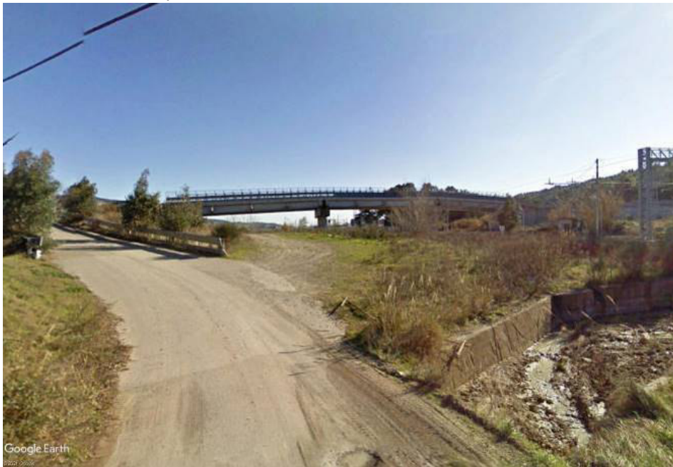
Foto innesto pista per CA-01-02 (NORD)
