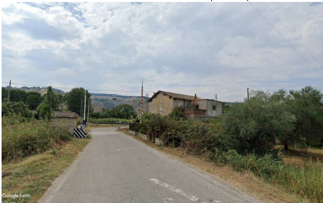
Vista viabilità in corrispondenza del PL che sarà soppresso e sostituito da scatolare
