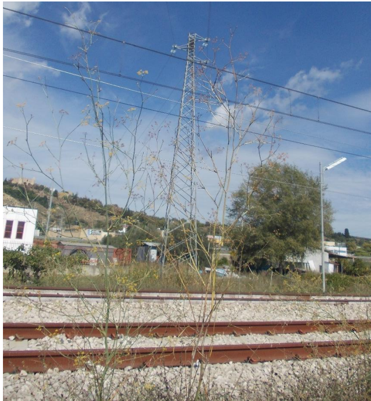
Linea aerea (foto al km 259+076)
