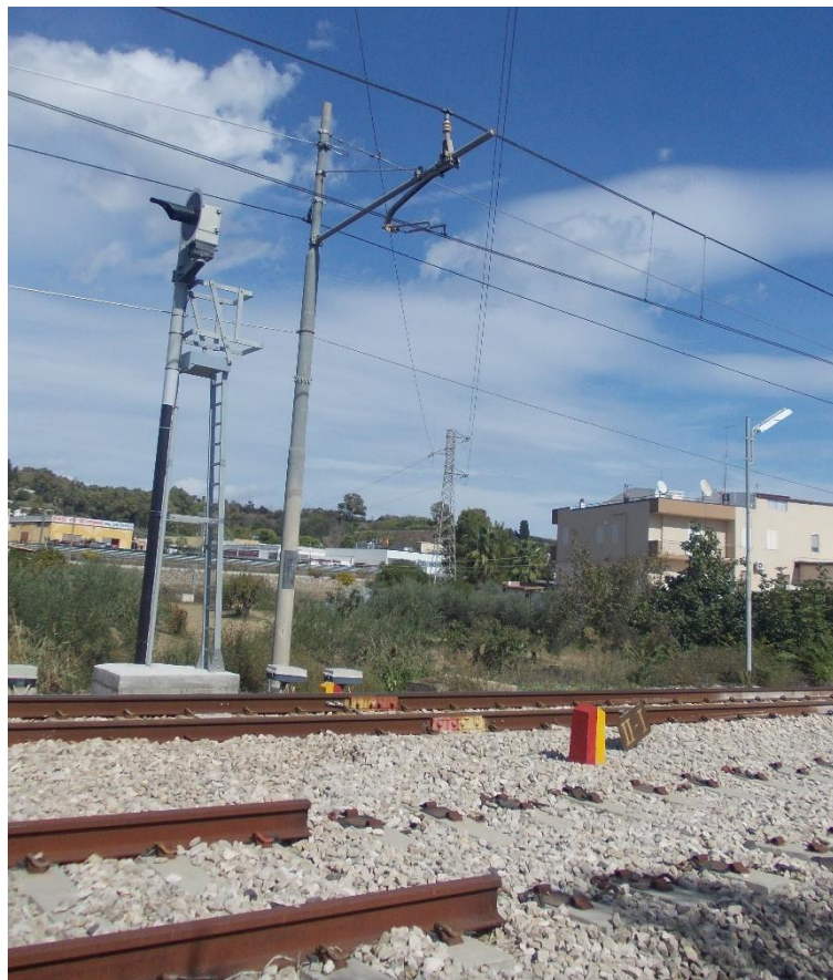
Linea aerea (foto al km 259+122)
