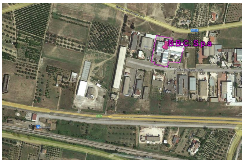
Figura -14: Agglomerato di attività commerciali e artigianali nei pressi delle opere di interesse
