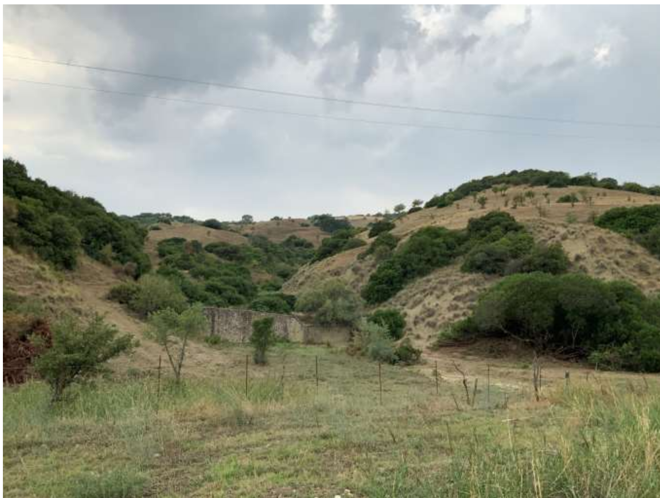
Figura 30 – Corso d'acqua secondario caratterizzato da un alveo con tendenza all'approfondimento e solchi di erosione concentrata e per tali motivi regimato con un sistema di briglie.
