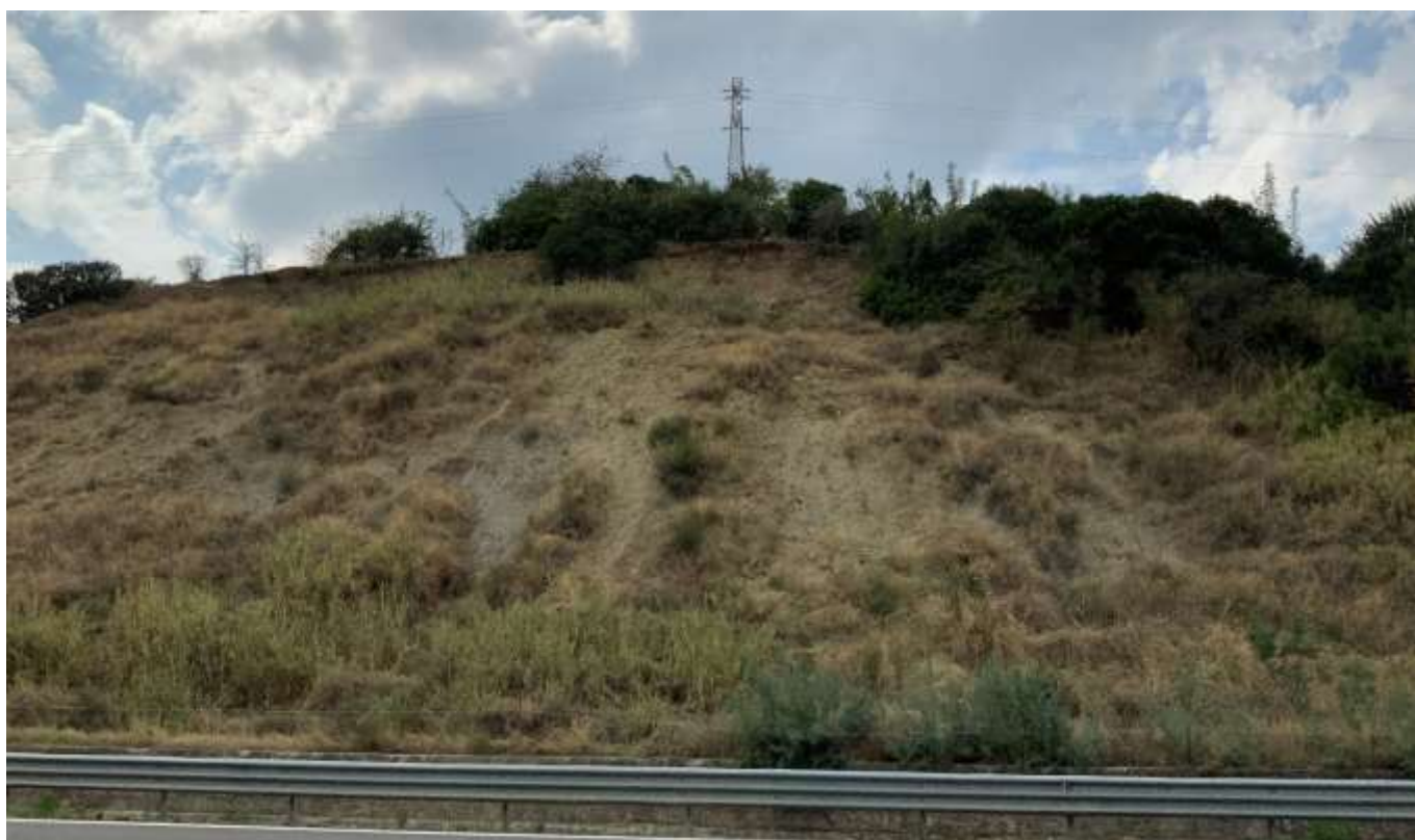
Figura 29 – Area a franosità diffusa attiva nel settore centrale dell'area di studio, in corrispondenza della S.S. 407 Basentana. Tale fenomeno coinvolge la porzione più superficiale ed alterata del substrato e, limitatamente alla parte alta della scarpata, i depositi alluvionali terrazzati che ricoprono i termini pelitici del substrato.
