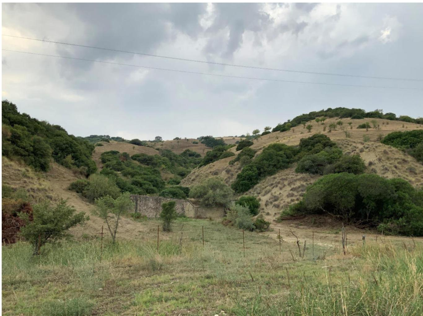
*Figura 32 – Corso d'acqua secondario caratterizzato da un alveo con tendenza all'approfondimento e solchi di erosione concentrata e per tali motivi regimato con un sistema di briglie.*
