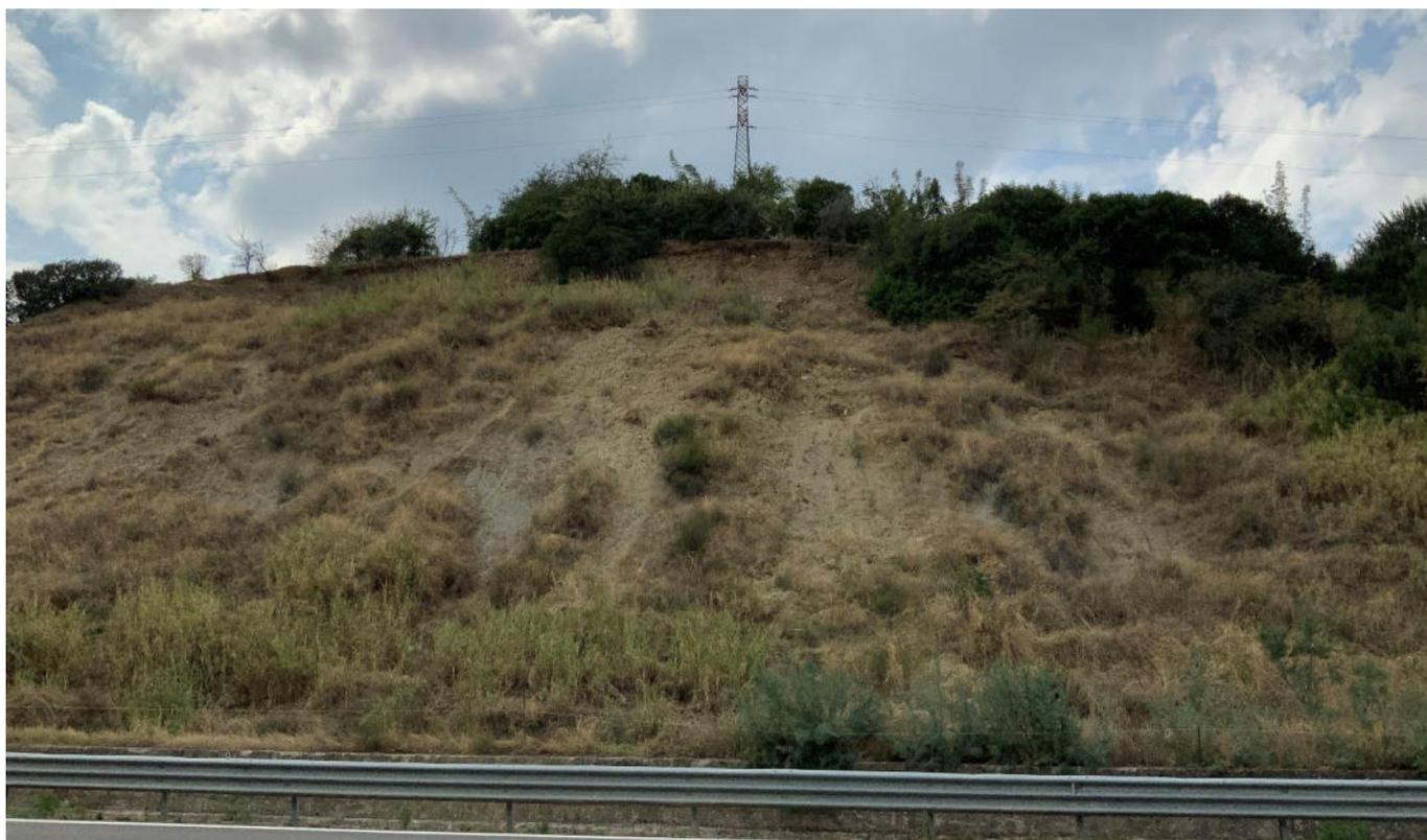
*Figura 31 – Area a franosità diffusa attiva nel settore centrale dell’area di studio, in corrispondenza della S.S. 407 Basentana. Tale fenomeno coinvolge la porzione più superficiale ed alterata del substrato e, limitatamente alla parte alta della scarpata, i depositi alluvionali terrazzati che ricoprono i termini pelitici del substrato.*
