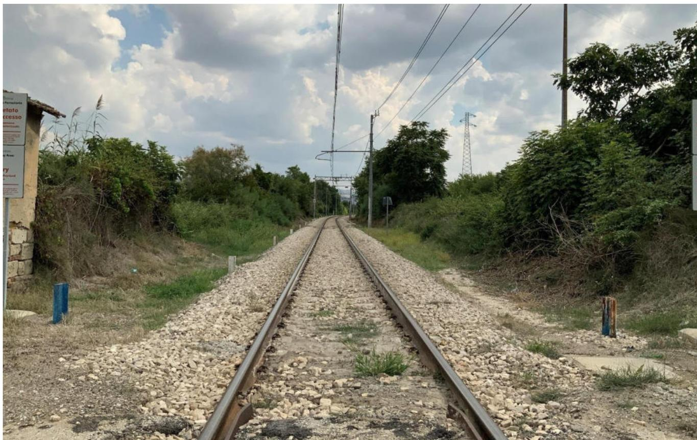
*Figura 28 – Riporti antropici (h) in corrispondenza della linea ferroviaria Potenza-Metaponto, nel settore centrale dell’area di studio.*
