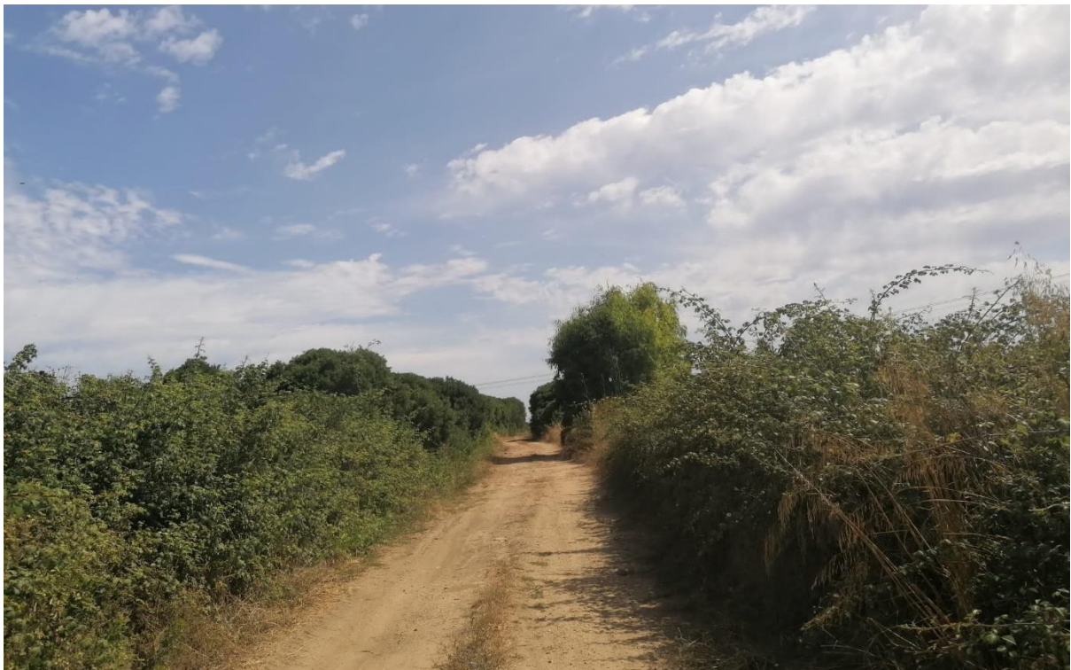
Veduta tratto Strada Vicinale Sacheddu .
