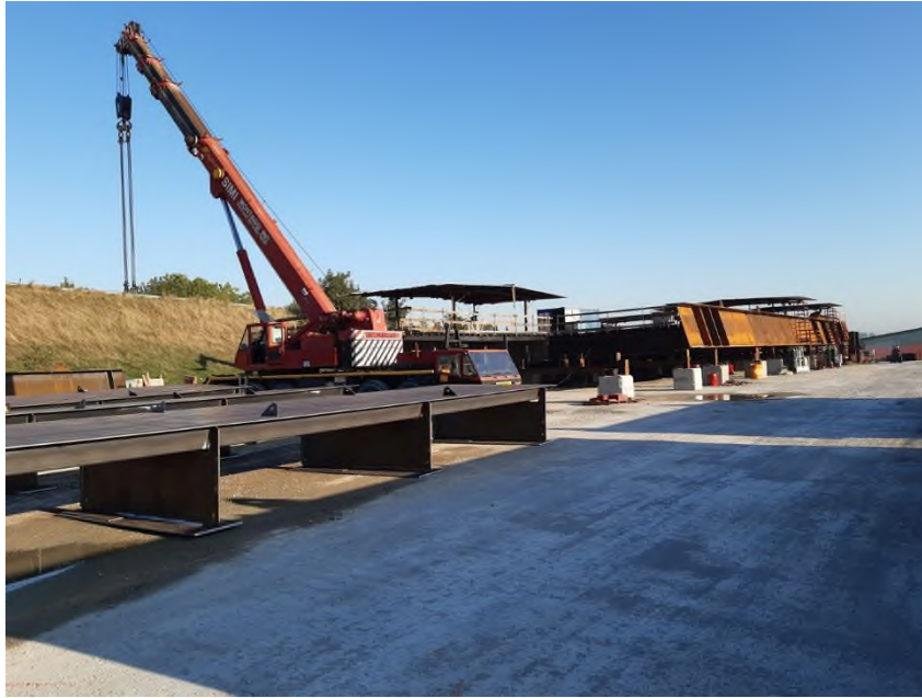
Figura: esempio di campo travi
