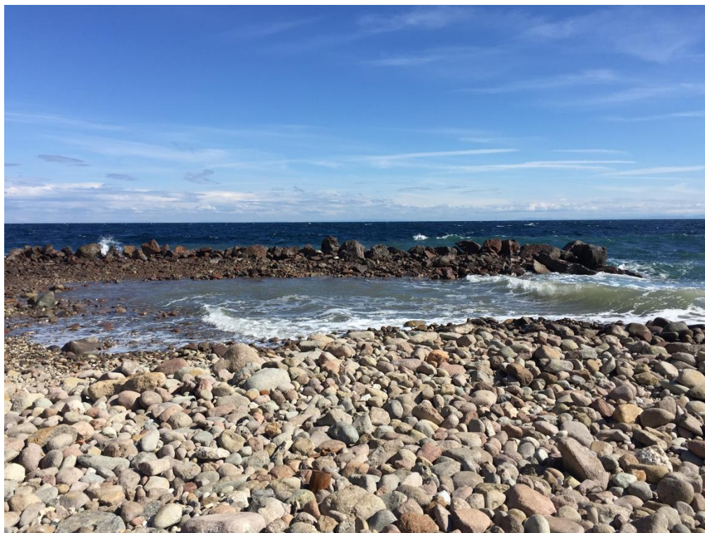
Figura 9. Porto di Capraia Isola, spiaggia “del Frate”, situazione post-operam. Vista da SE.
