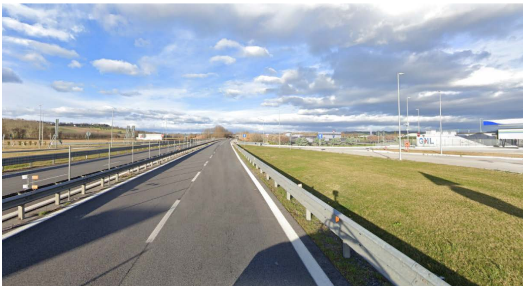
Figura 8.5-3 - Fotoinserimento effettuato su panoramica Google lungo raccordo autostradale SS 77 direzione Tolentino (stato di progetto)
