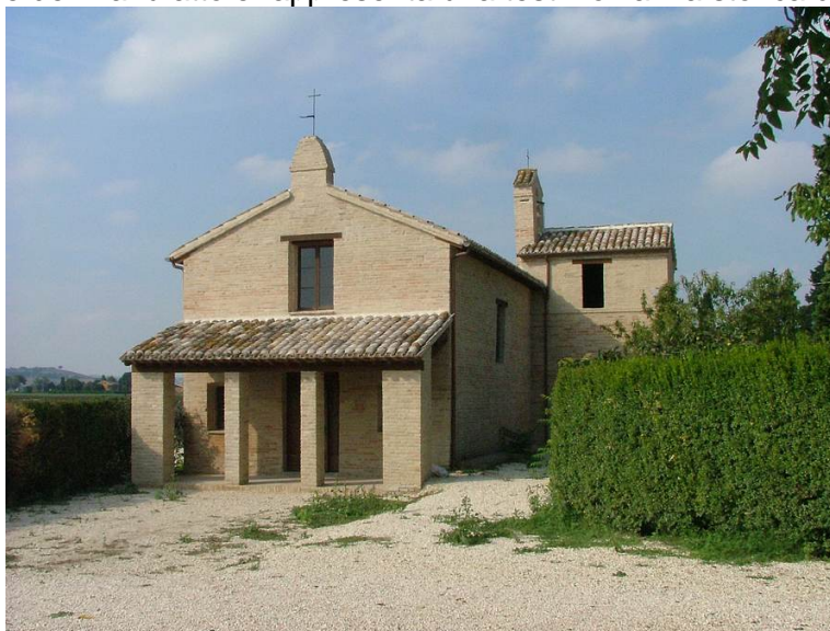
Figura 8.2-2 – La Grancia di Sarrocciano con il suo portico dopo il restauro del 2004
