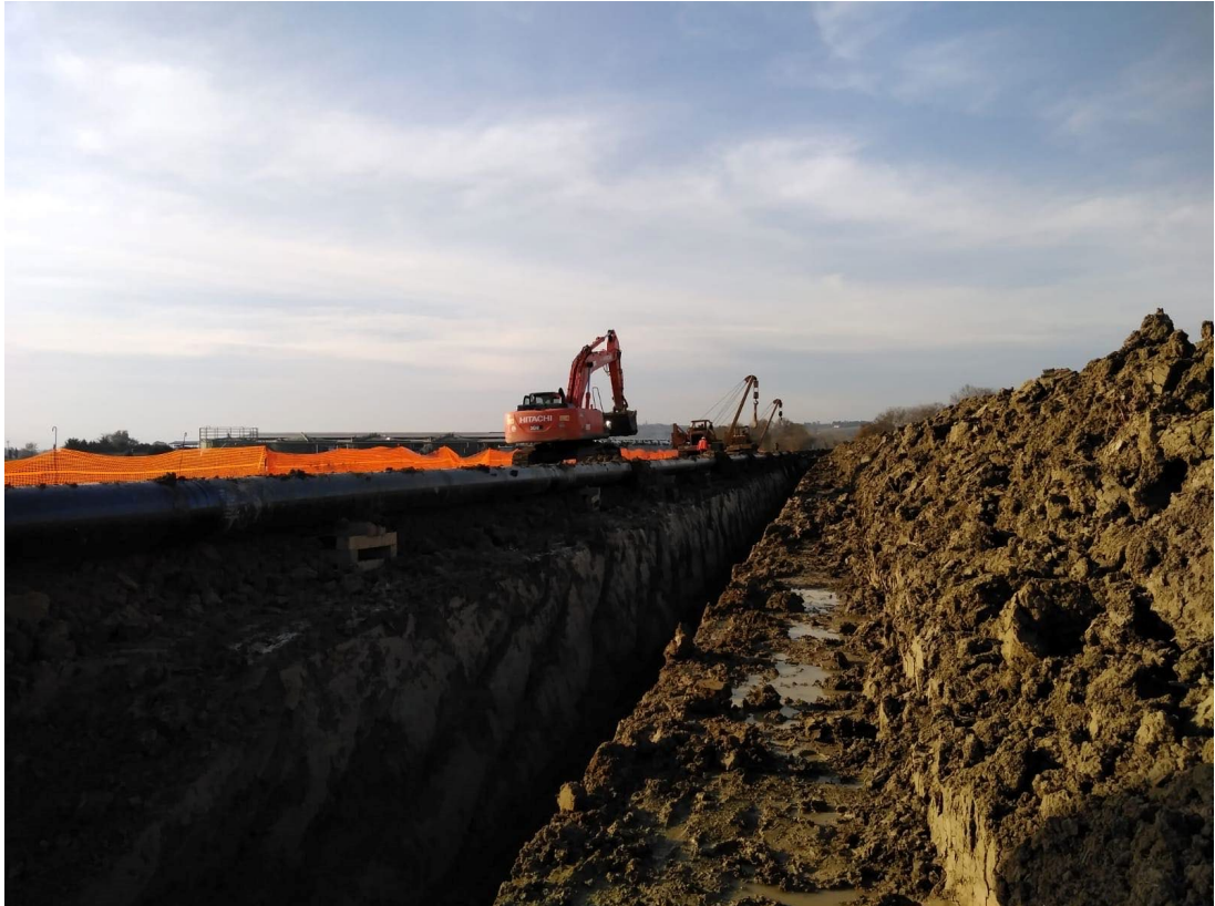
4.14 – Asse scavo, foto d’insieme - vista SW in direzione Fiume Chienti del vertice di cantiere 107 – 106 / tronco II.
