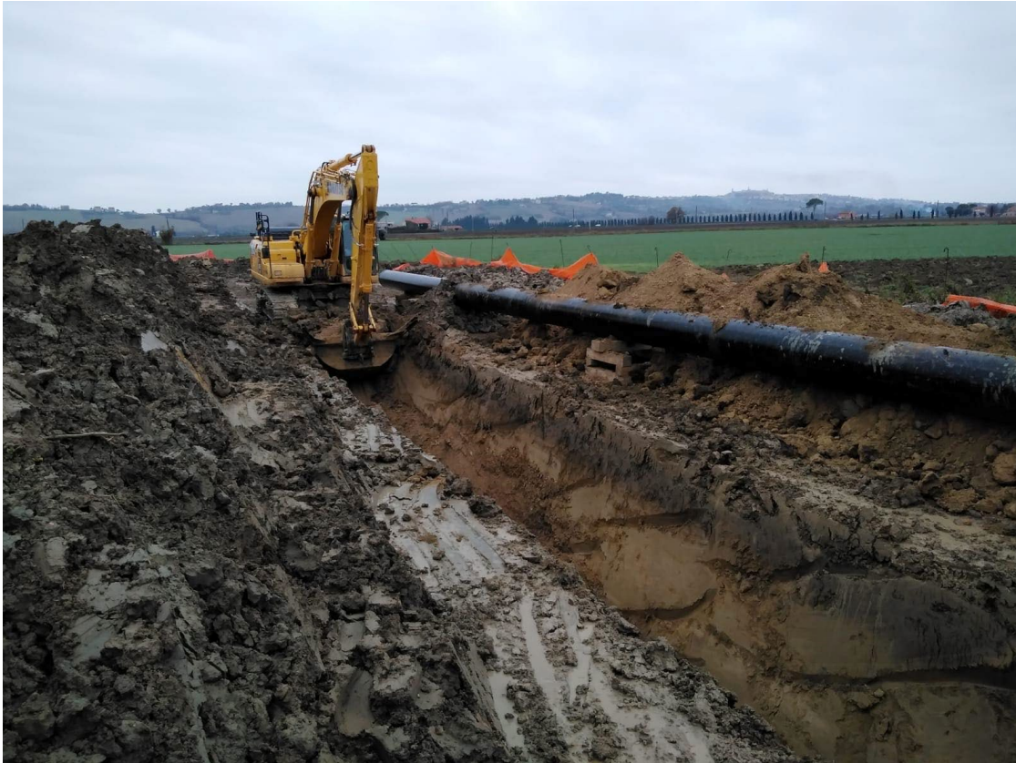
4.9 – Particolare dell'asse scavo. Sezione e vista SE del vertice di cantiere 104 / tronco II.
