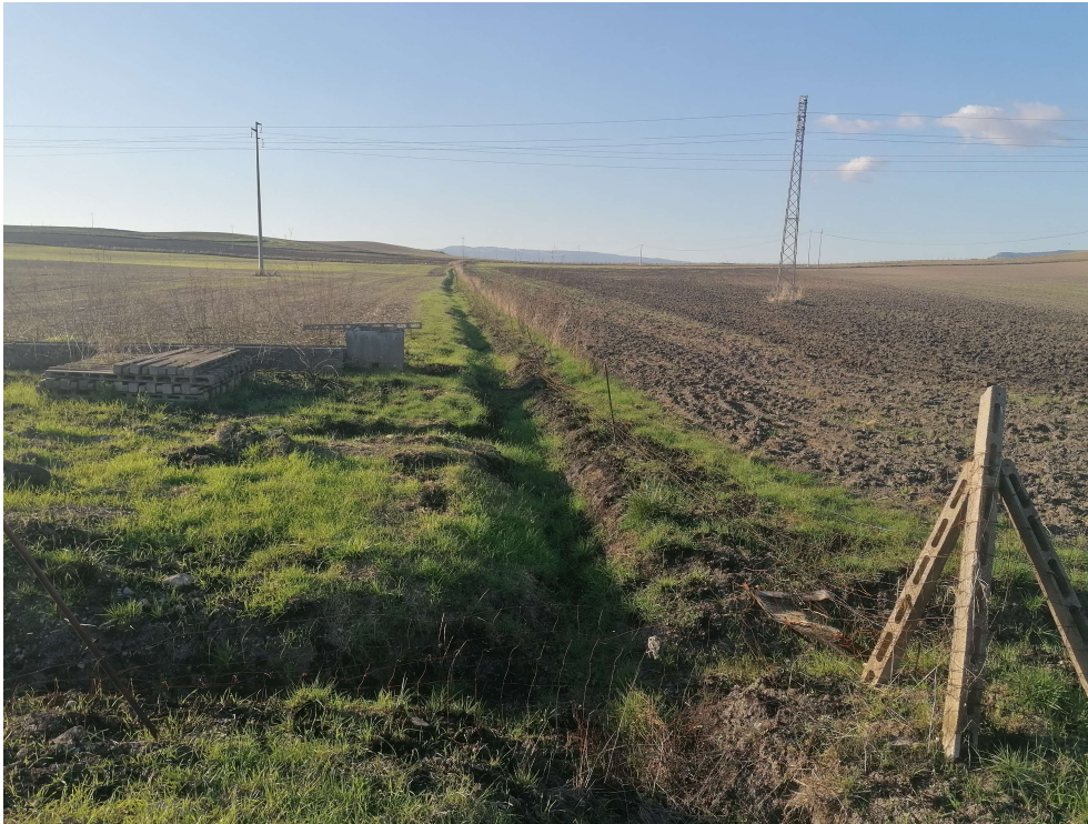
Figura 3 Canale in terra esistente
