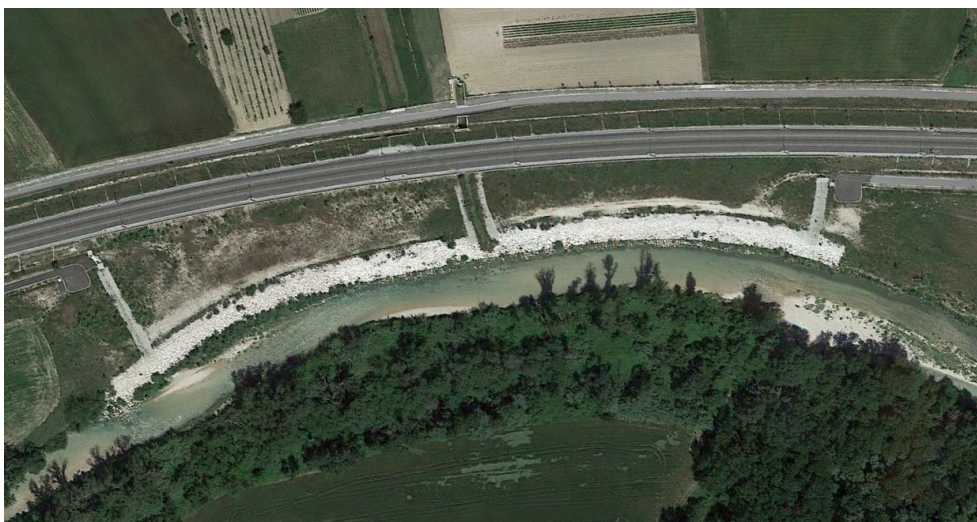
Fig. 39 – Tratta Castelplanio-Montecarotto: opere di sistemazione spondale realizzate sul Fiume Esino.
