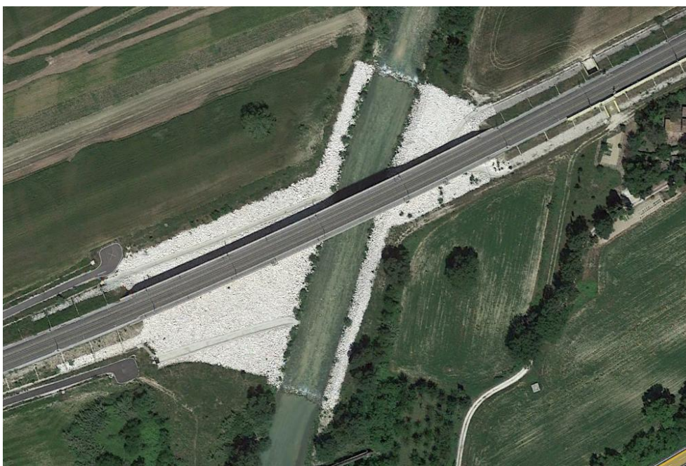
Fig. 38 – Tratta Castelplanio-Montecarotto: opere di protezione realizzate in corrispondenza dell’attraversamento del F. Esino.
