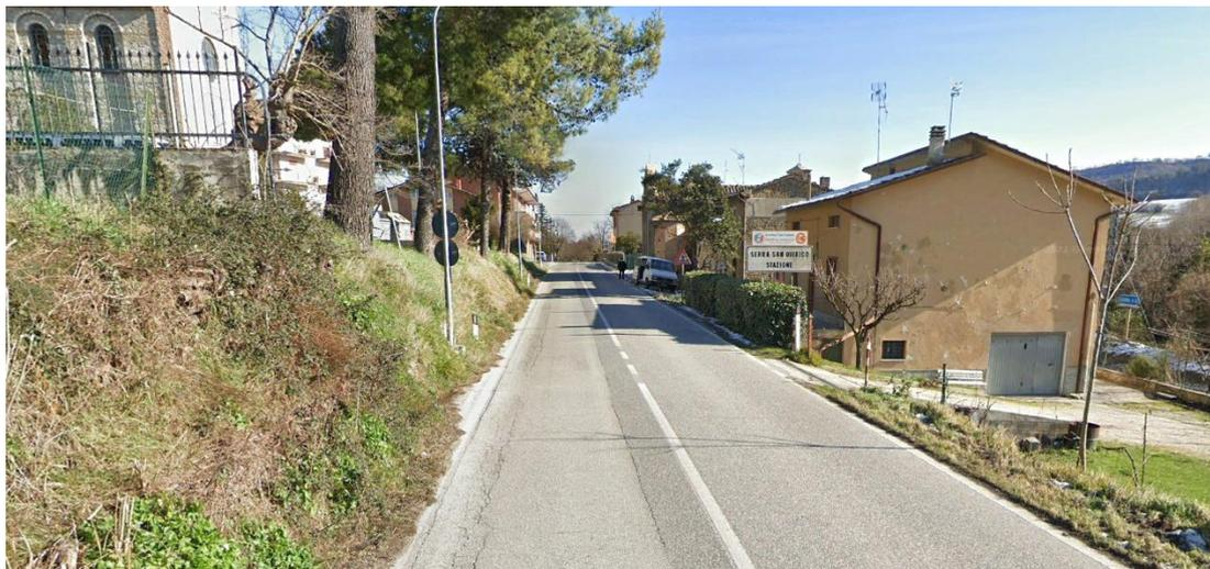
Il tratto di viabilità esistente interferito ha due corsie con larghezza approssimabile mediamente a ca. 2,75 – 3,00 m, e banchine di ca. 0,25 m. per una larghezza complessiva di ca. 6,00 – 6,50 m.
