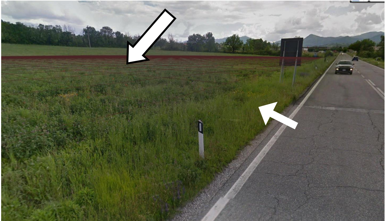
Foto accesso all'area di cantiere
