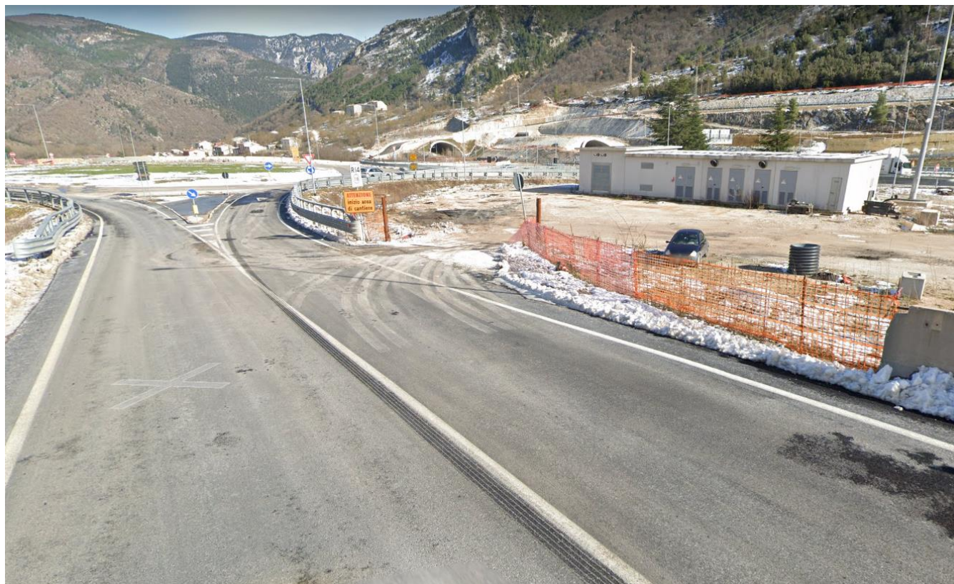
Foto dell'accesso e del fabbricato tecnologico esistente
