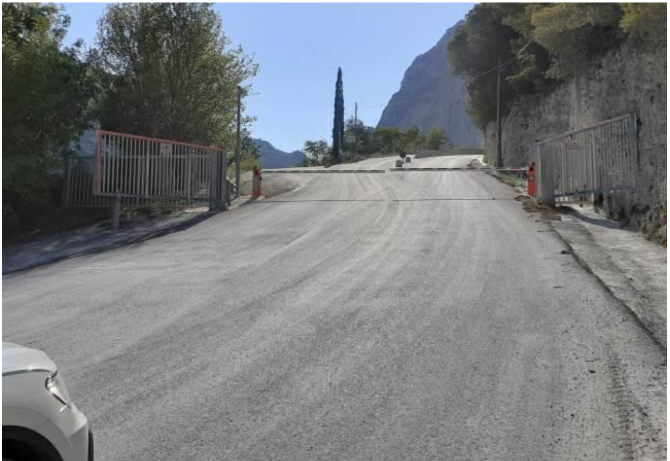
Foto accesso all'area di cantiere
