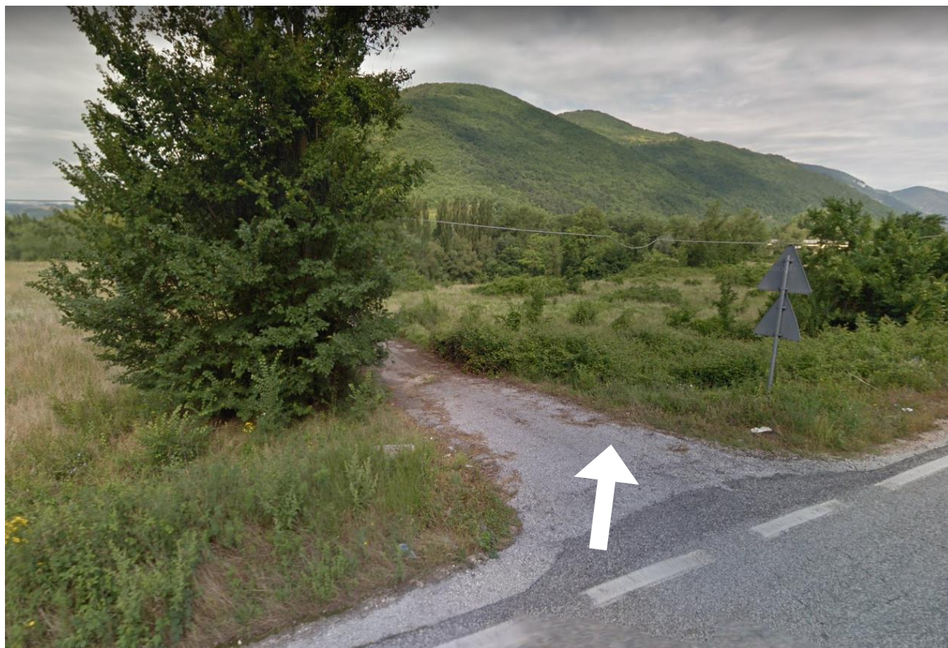
Foto accesso all'area di cantiere
