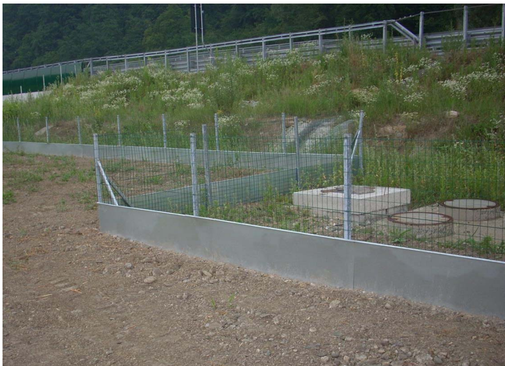
Figura 13.4 – Esempio di installazione del lamierino su recinzione.
