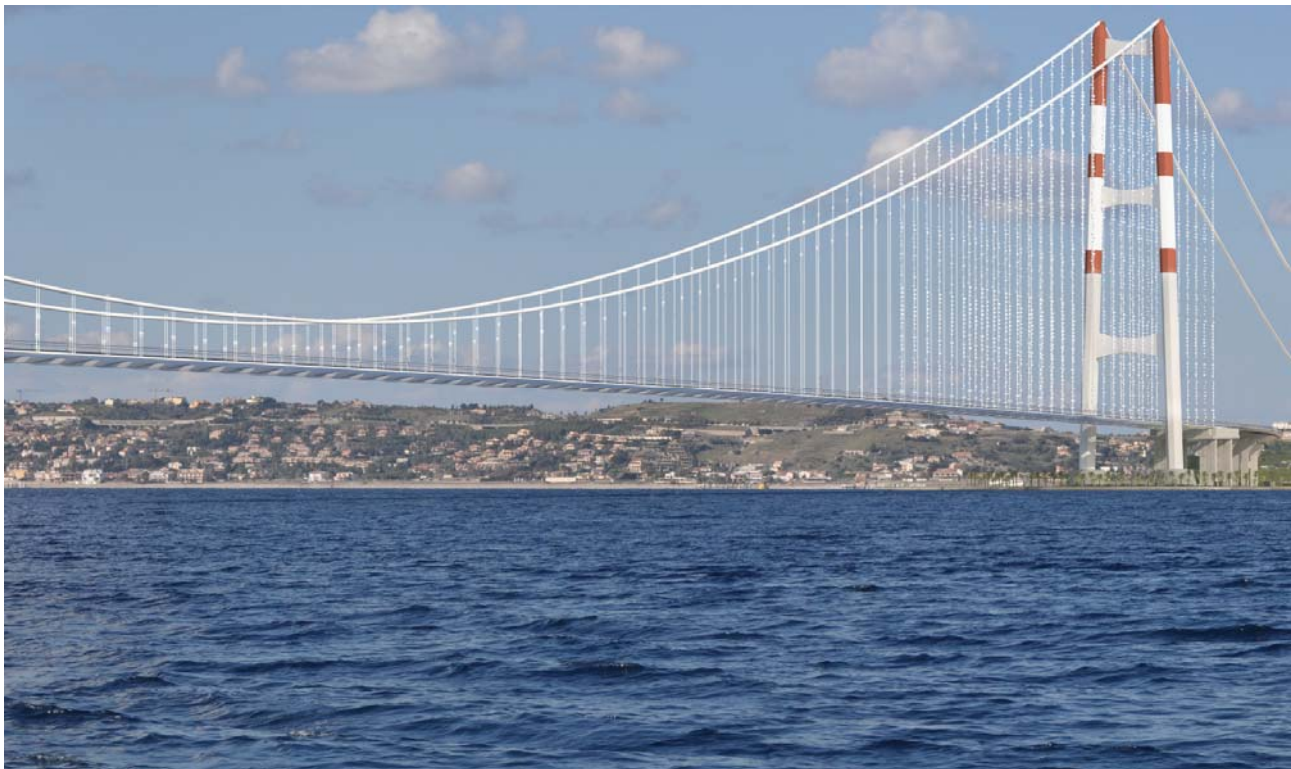
Figura 22.7 – Ipotesi di sistemazione di elementi di avvertimento sui pendini – colorazione torri bianca/rossa
