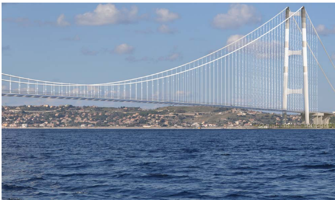
Figura 13.7 – Ipotesi di sistemazione di elementi di avvertimento sui pendini – colorazione torri bianca/grigia
