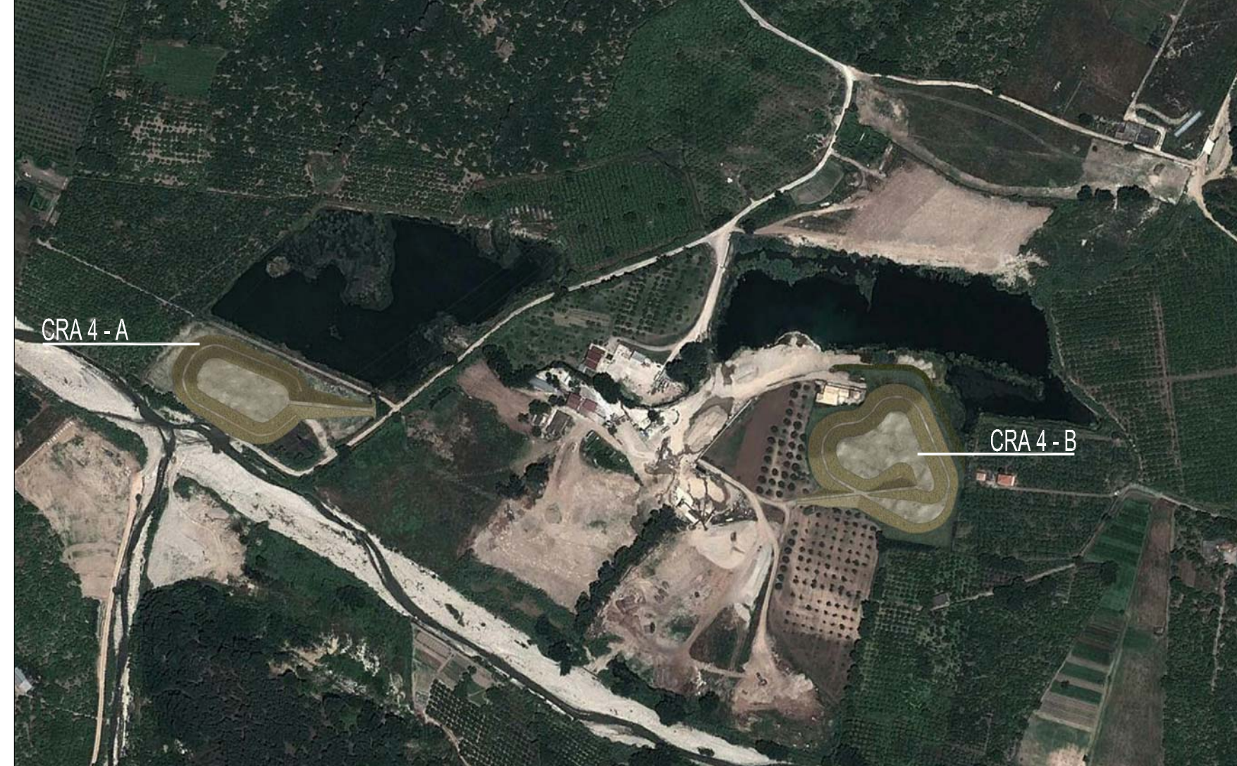
ORTOFOTO: SITUAZIONE POST OPERAM DEPOSITO TEMPORANEO
