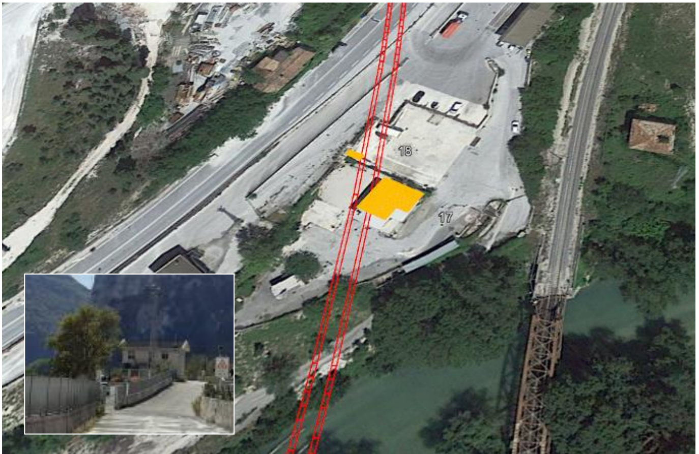
Vista del fabbricato 18
