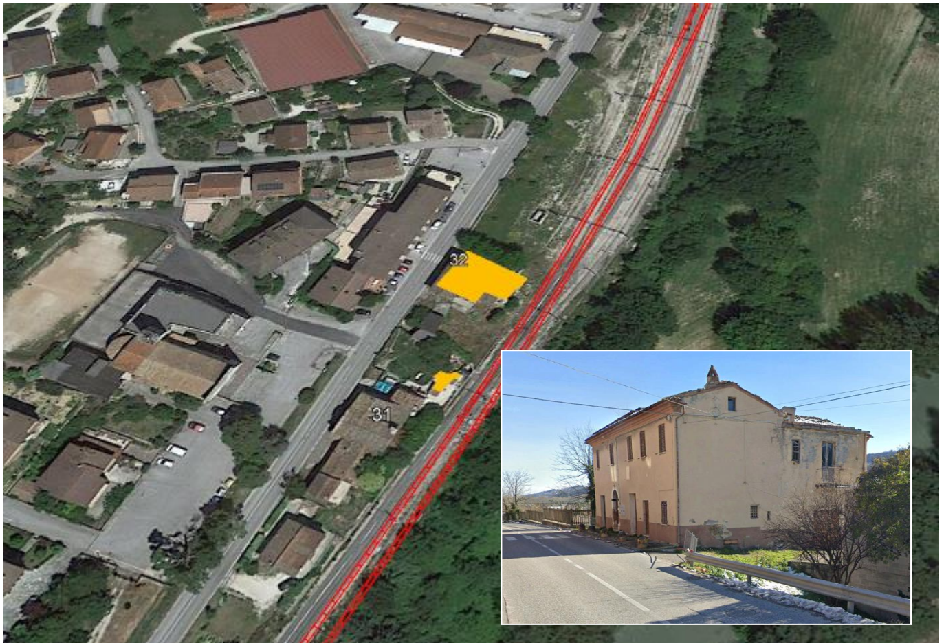
Vista del fabbricato 32
