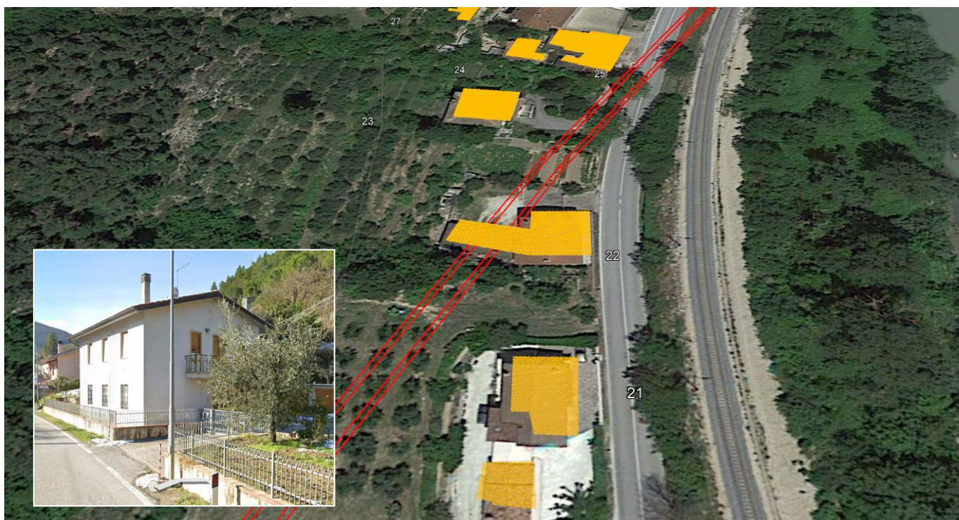
Vista del fabbricato 22
