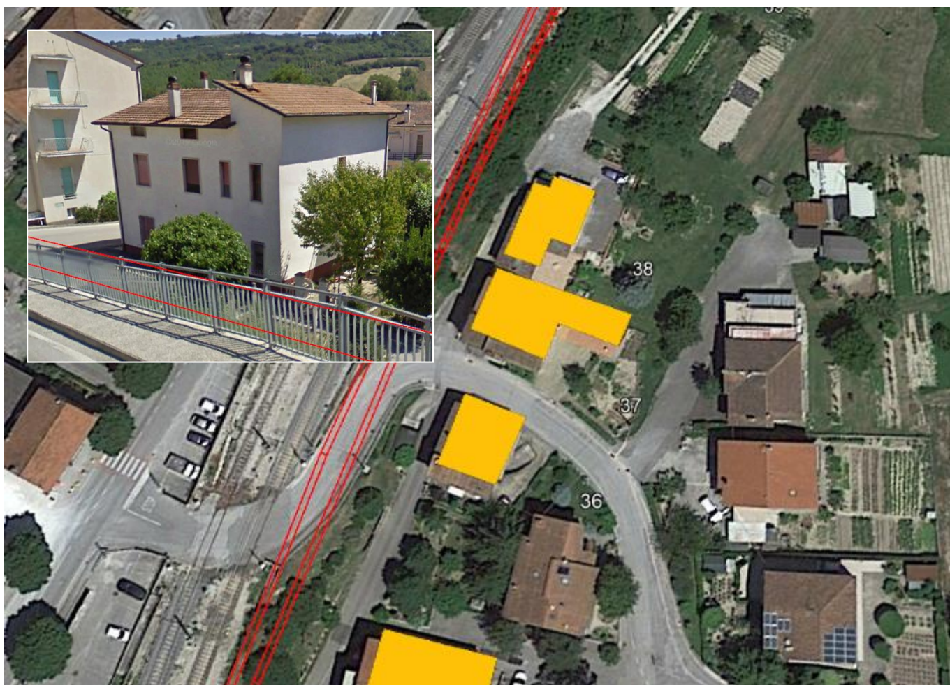
Vista del fabbricato 36
