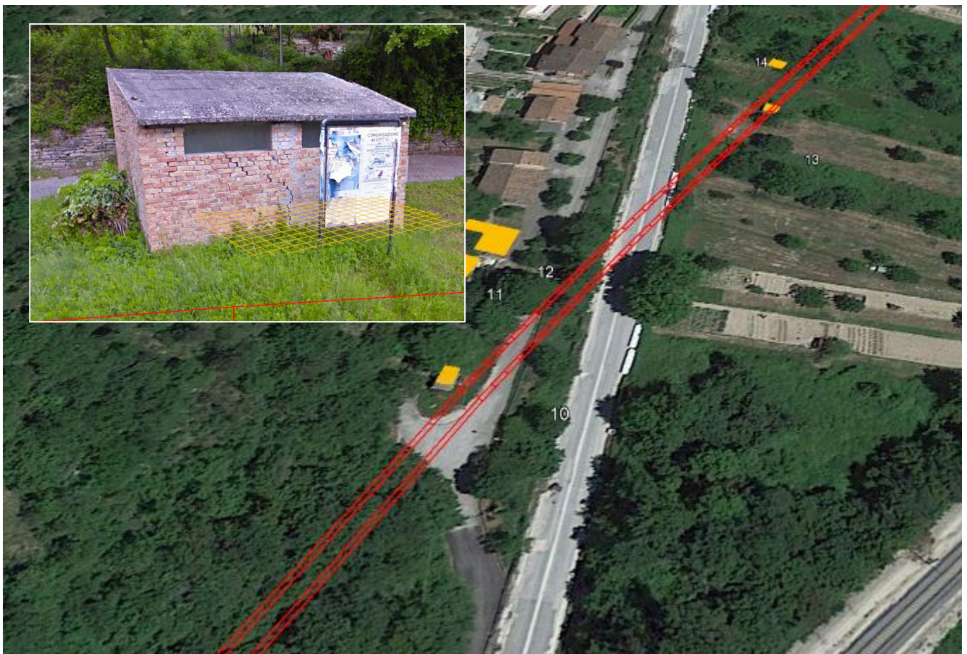
Vista del fabbricato 10
