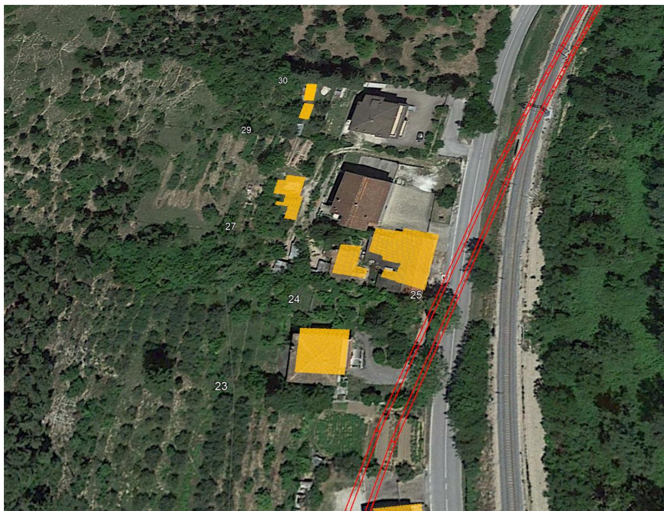
Vista del fabbricato 30
