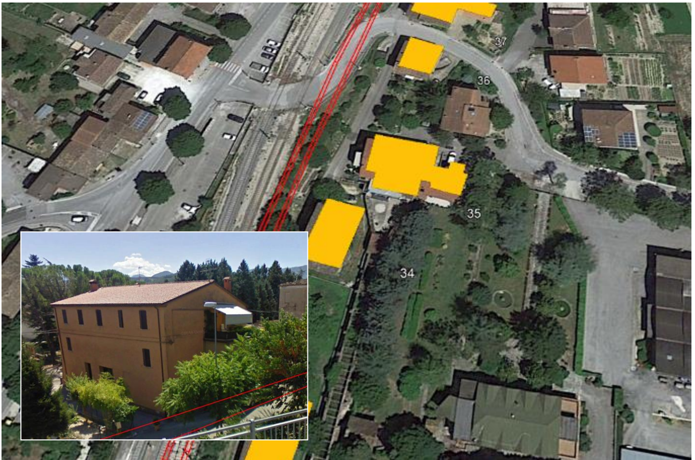
Vista del fabbricato 35
