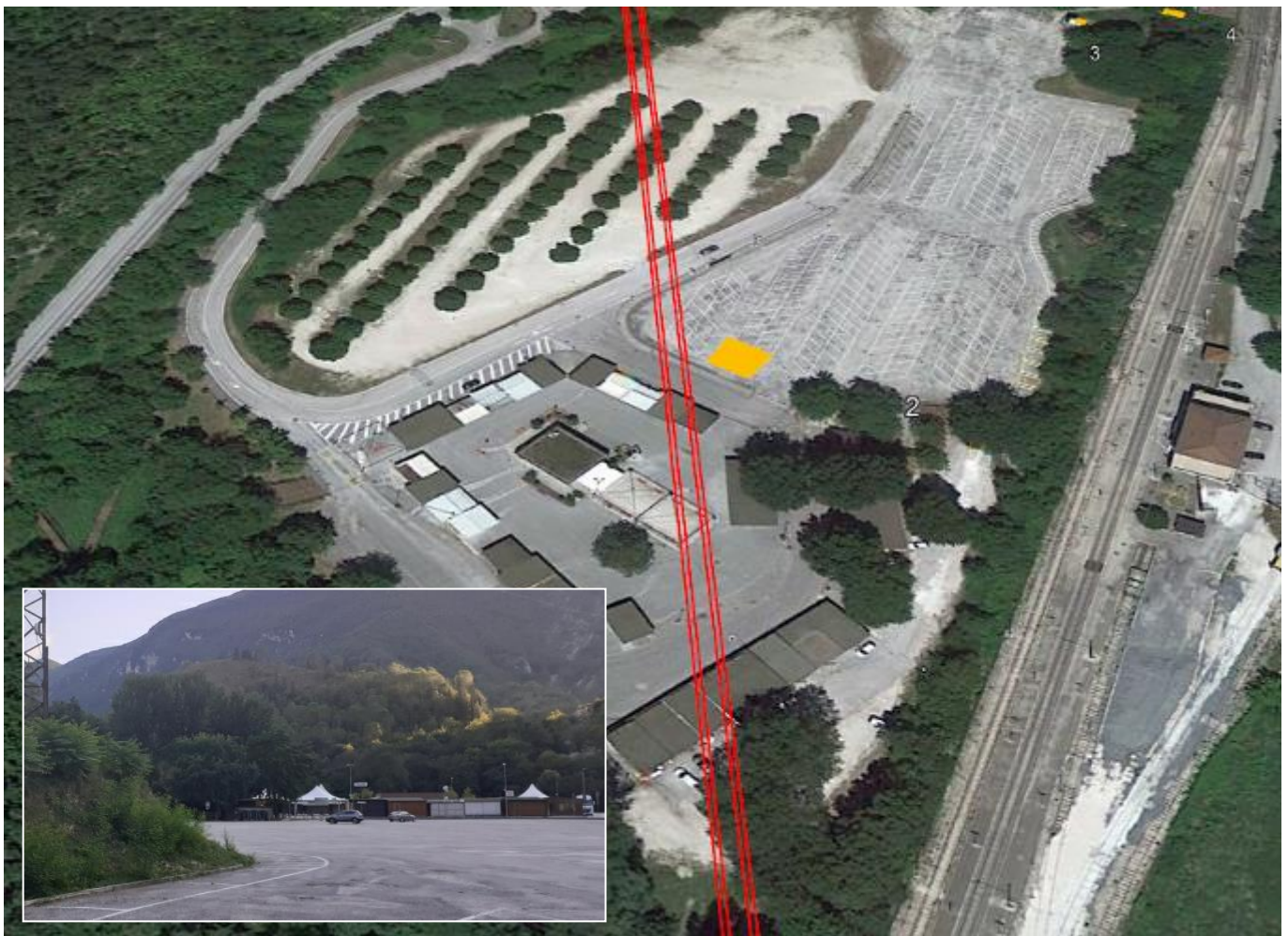
Vista del fabbricato 2
