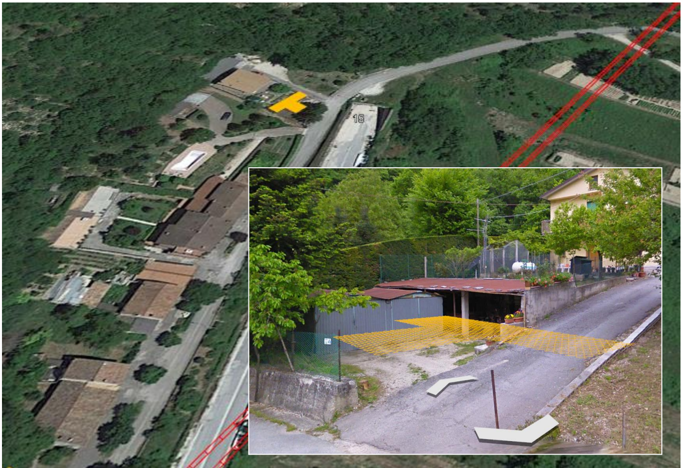
Vista del fabbricato 15
