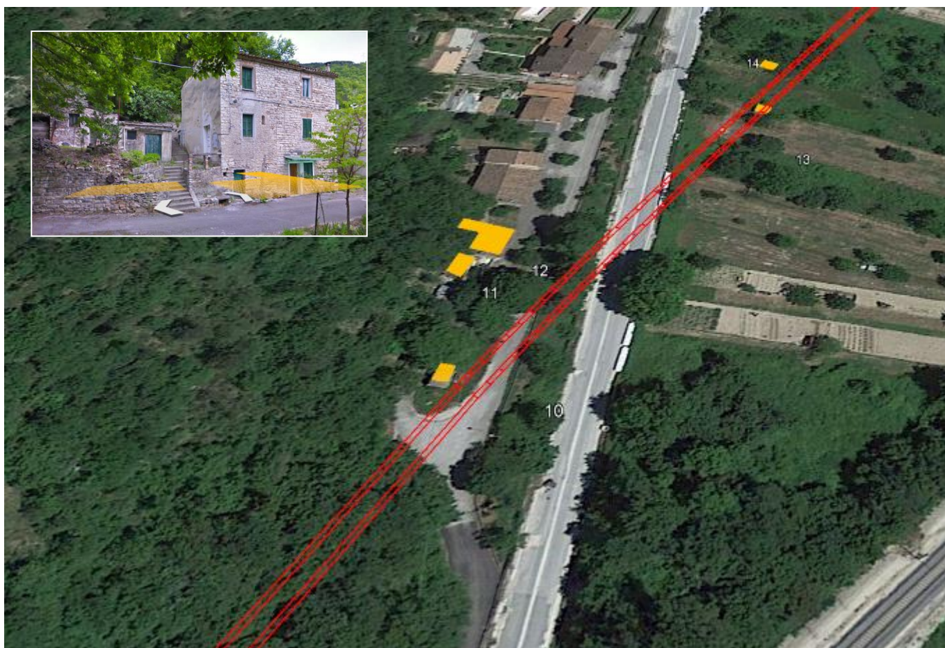
Vista del fabbricato 12
