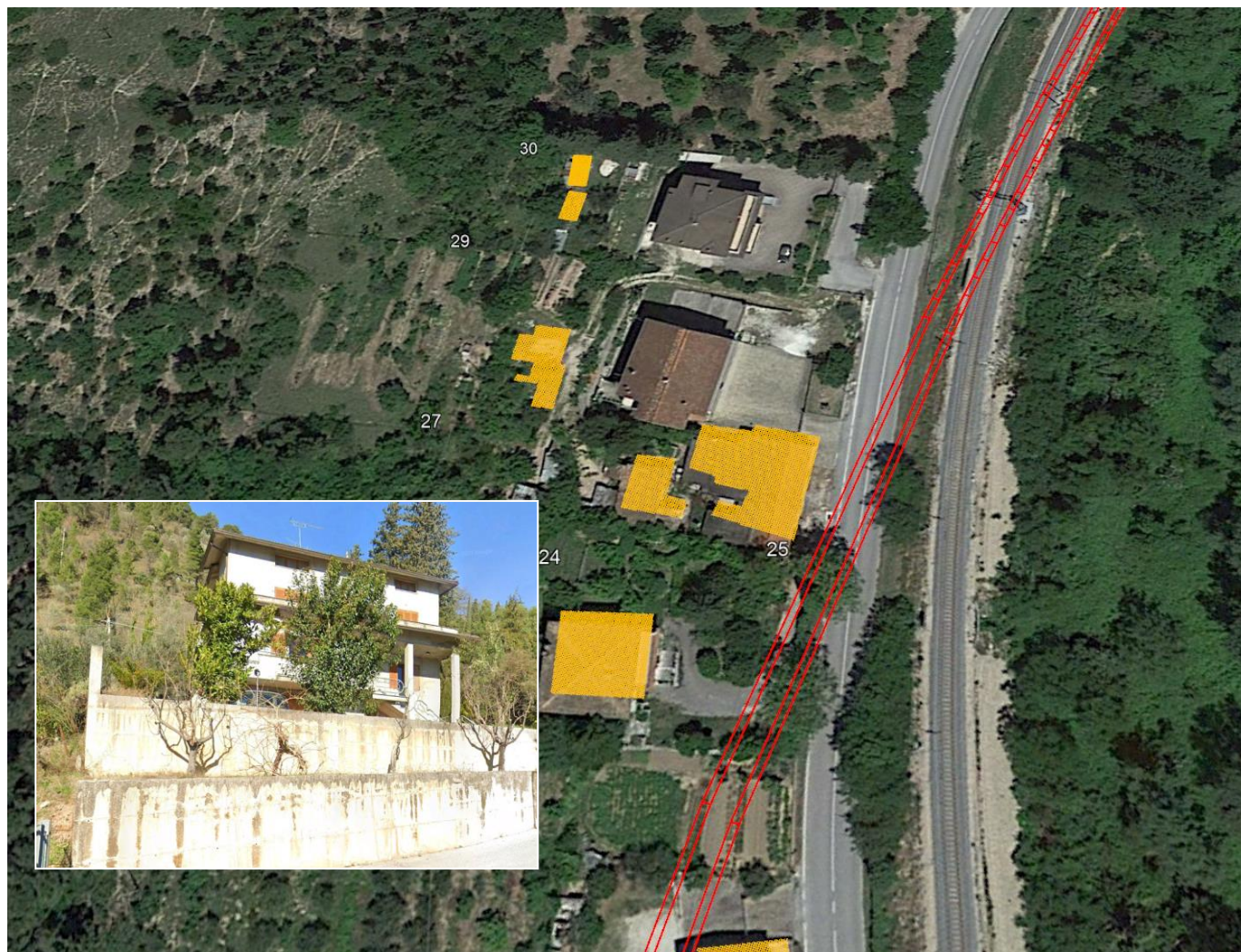
Vista del fabbricato 29
