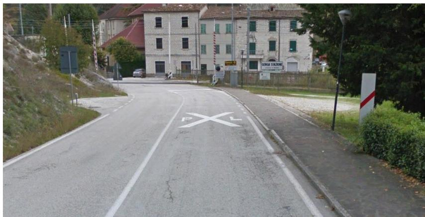
Il tratto di viabilità esistente interferito ha due corsie con larghezza approssimabile mediamente a ca. 3,50 m, e banchine di ca. 0,50 m. per una larghezza complessiva di ca. 8,00 m, e un marciapiede lato valle.
