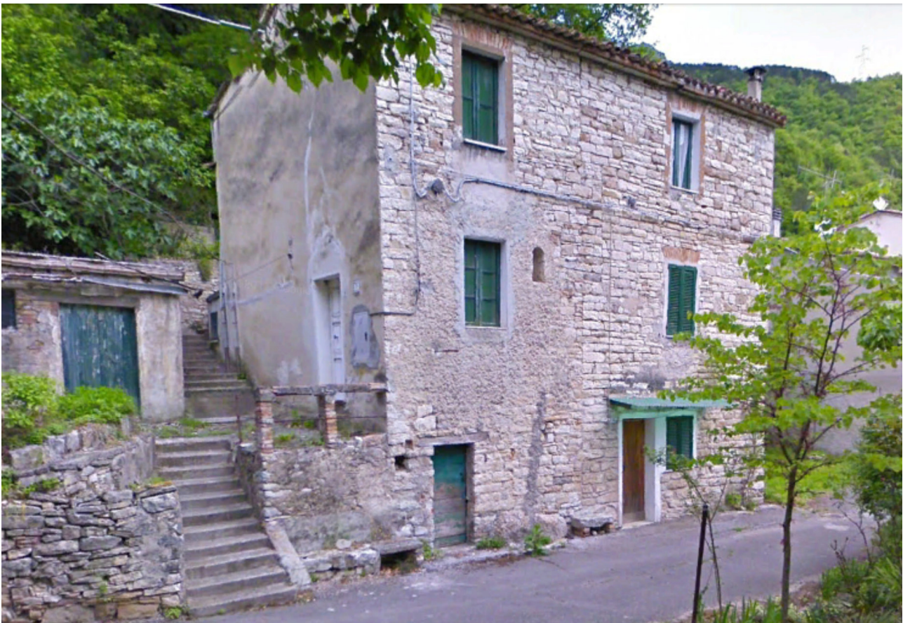
B.1.3 FABBRICATO N°34 AL KM 8+300
