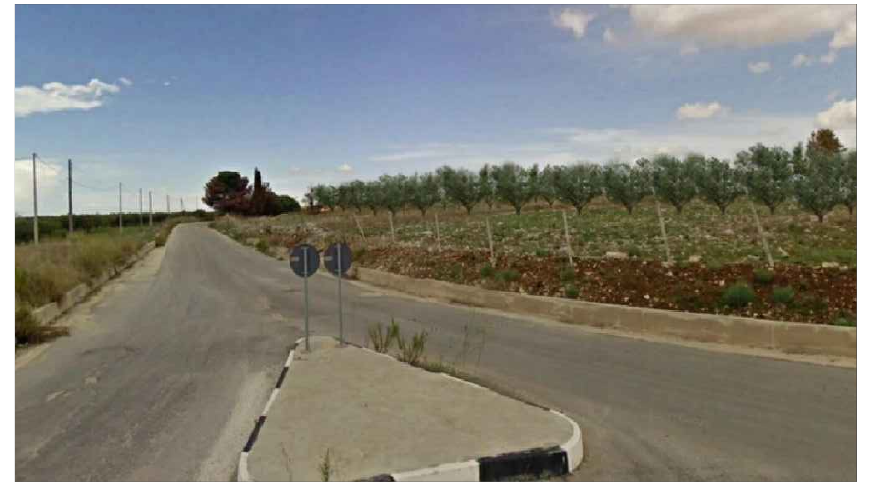
FOTO N.1 - VISTA ESTERNA - INSERIMENTO IMPIANTO NEL CONTESTO CON MITIGAZIONE
