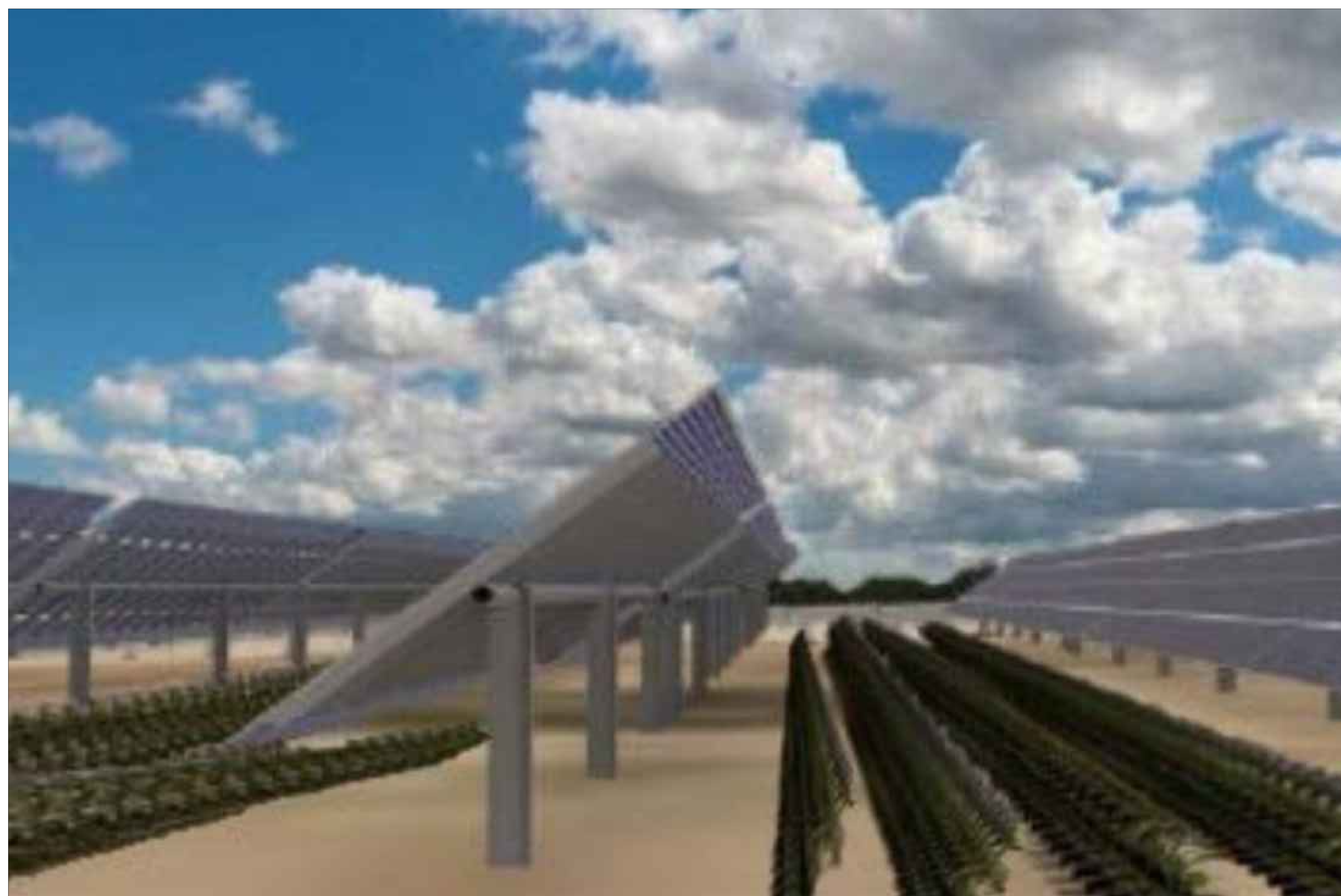
FOTO N.2 - VISTA INTERNA - IMPIANTO CON COLTIVAZIONE SOTTO I PANNELLI
