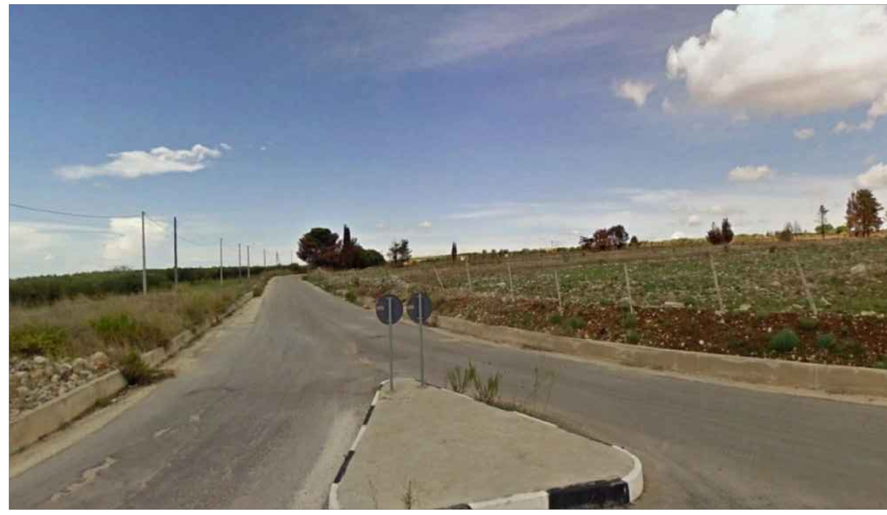
FOTO N.1 - AREA DOVE VERRA' REALIZZATO L'IMPIANTO
