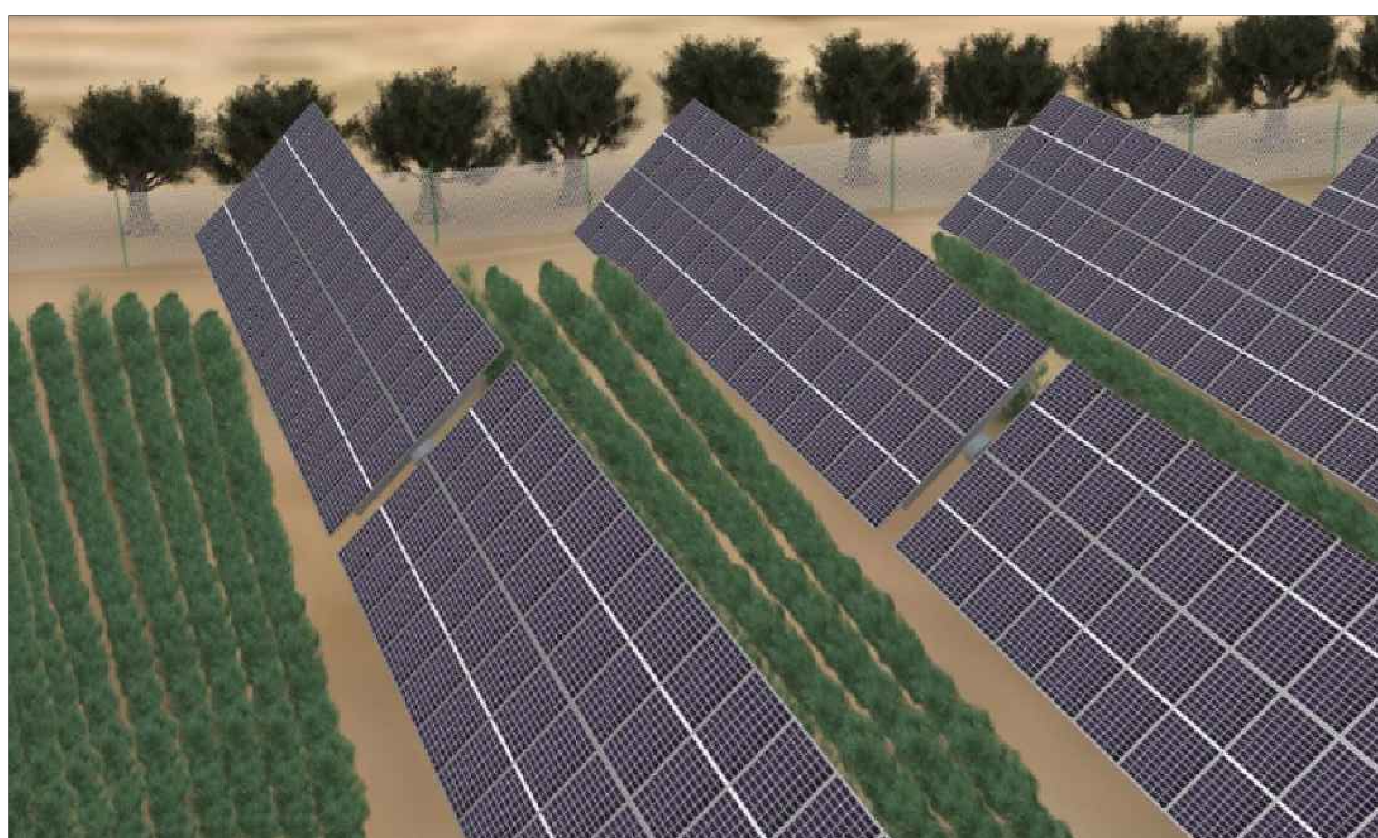
FOTO N.2 - VISTA INTERNA IMPIANTO CON COLTIVAZIONE SOTTO I PANNELLI
