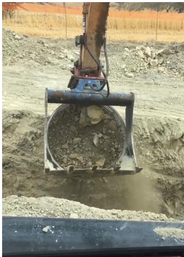
Fig. 1 Operazioni di printerro della condotta ed ispezione del materiale con benna vagliante
