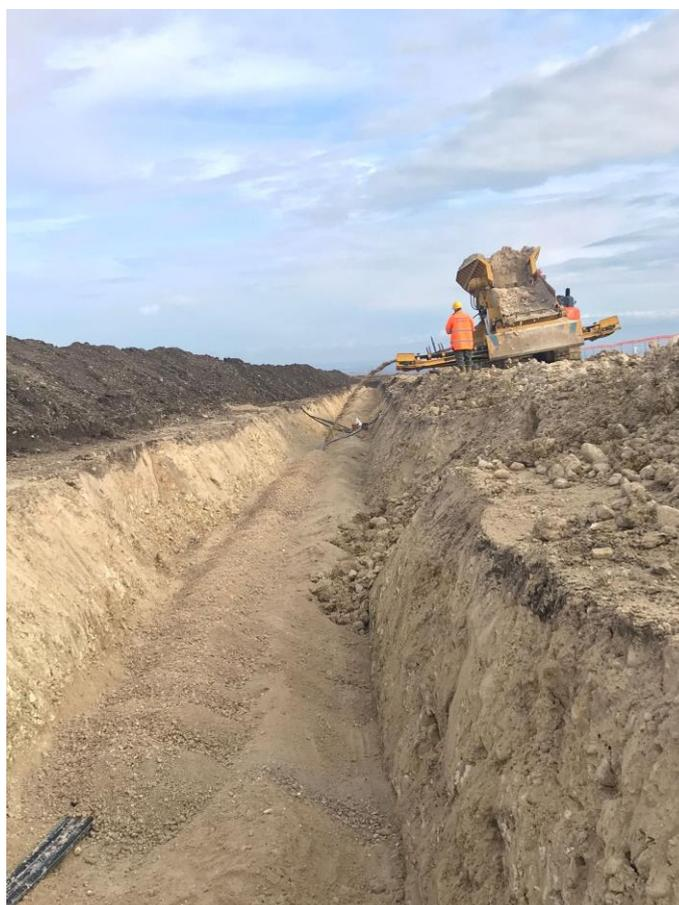
*Fig. 1 - Operazioni di rinterro della condotta ed ispezione del materiale con vibrovaglio*
