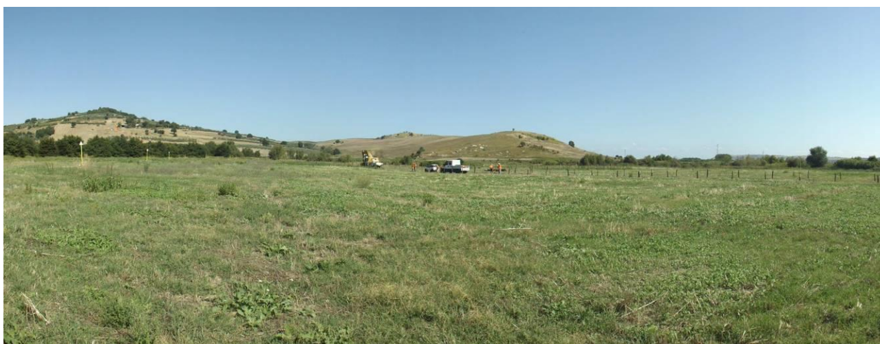
Fig. 1 – Fase di delimitazione delle aree di cantiere “Treste” e “La Coccetta”.
