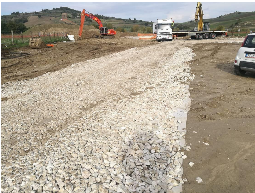
Fig. 2 – Fase di inghiainamento del piazzale ed allestimento area di cantiere “Treste” e “La Coccetta”.
