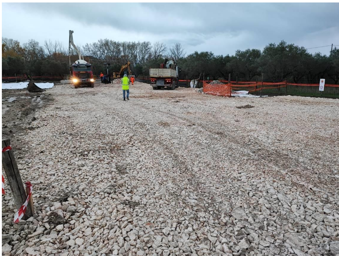
Fig. 4 – Fase di inghiaamento del piazzale ed allestimento area di cantiere “Trigno”.
