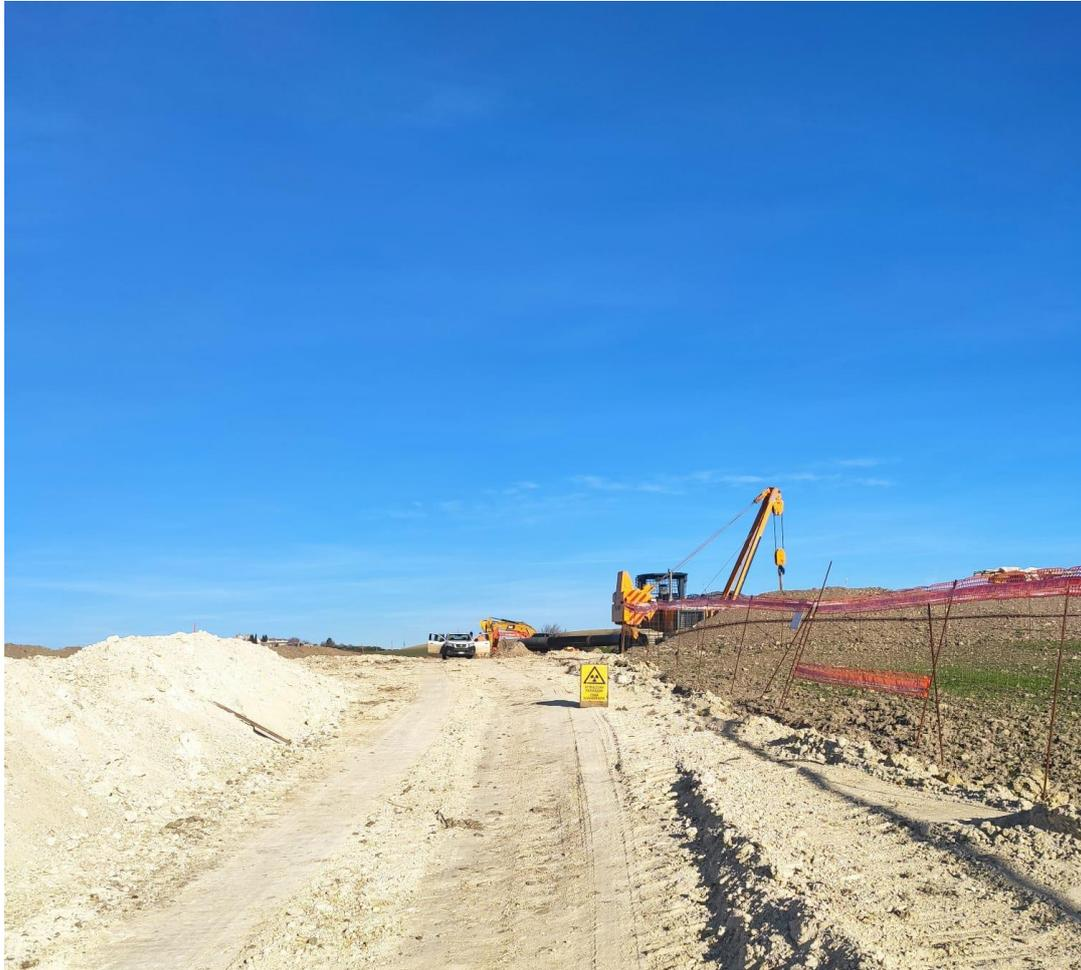
*Fig. 1 – Cartello di segnalazione del tipo di zona, apposto durante l'esecuzione dei controlli con radiografie*
