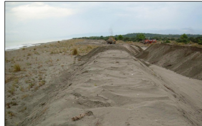
RICOSTRUZIONE DEL CORDONE DUNALE
