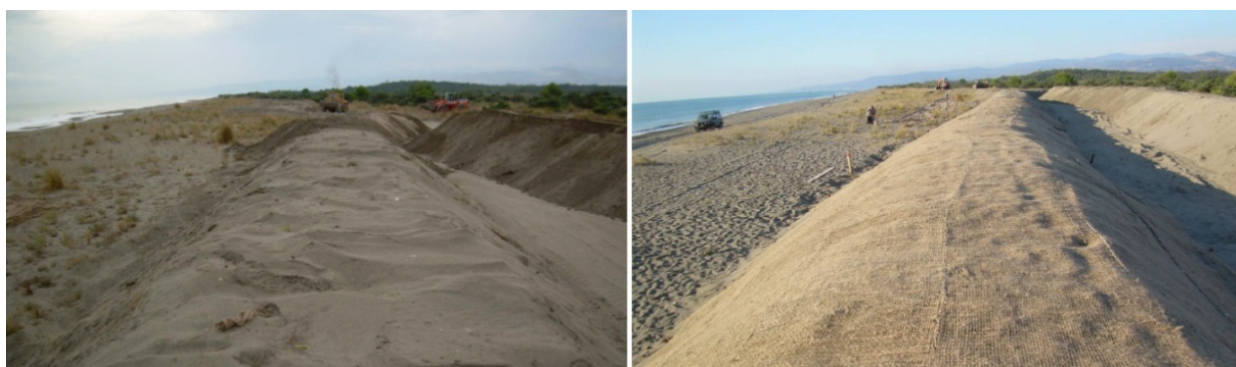
Fig. 13 - Costruzione duna
