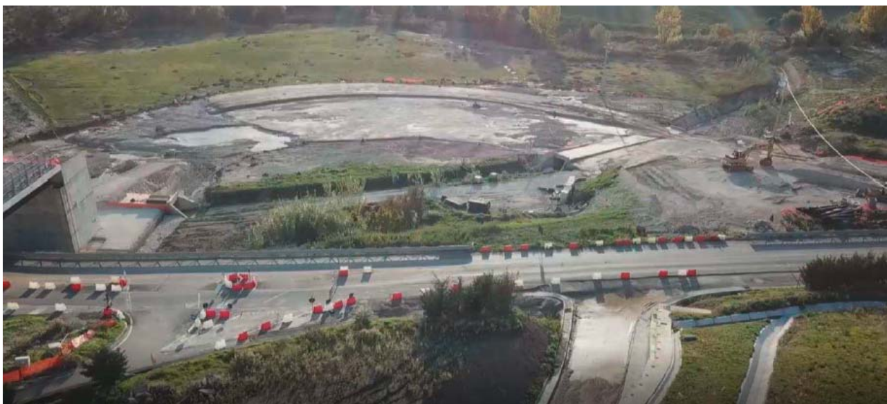
Figura 5 - Foto da drone dell'area in esame a seguito dell'evento alluvionale di Novembre 2018
