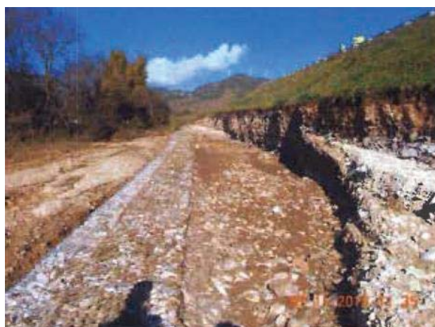
Figura 20 - Danni alle gabbionate ed al piede del rilevato
