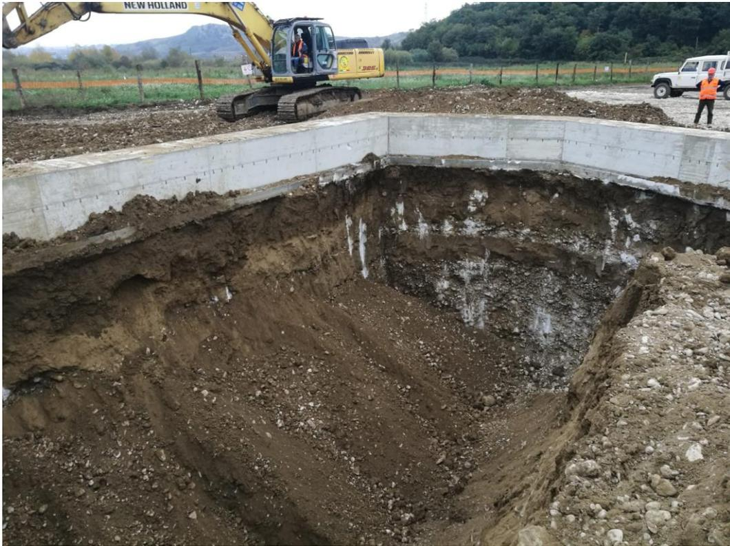
*Fig. 1 – Scavo con utilizzo di mezzo meccanico (escavatore) della buca di spinta dell’opera trenchless “Treste e La Coccetta”*
