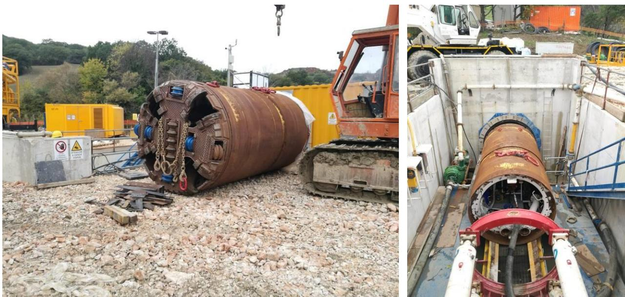
Fig. 1 – Fresa a scudo chiuso in uso per il microtunnel Masseria Graziano.
