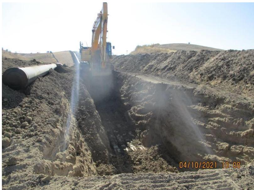
Fig. 4 – Scavo della trincea con utilizzo di mezzo meccanico (escavatore)
