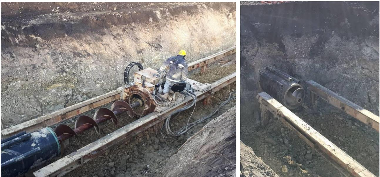
*Fig. 2 – Trivellazione spingitubo con aste elicoidali – senza uso di fluidi di perforazione*
