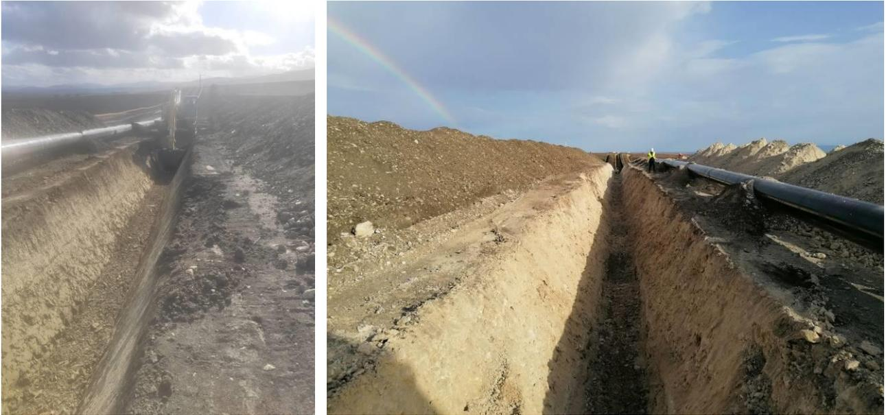
*Fig. 1 – Scavo della trincea eseguito con utilizzo di mezzo meccanico (escavatore)*
