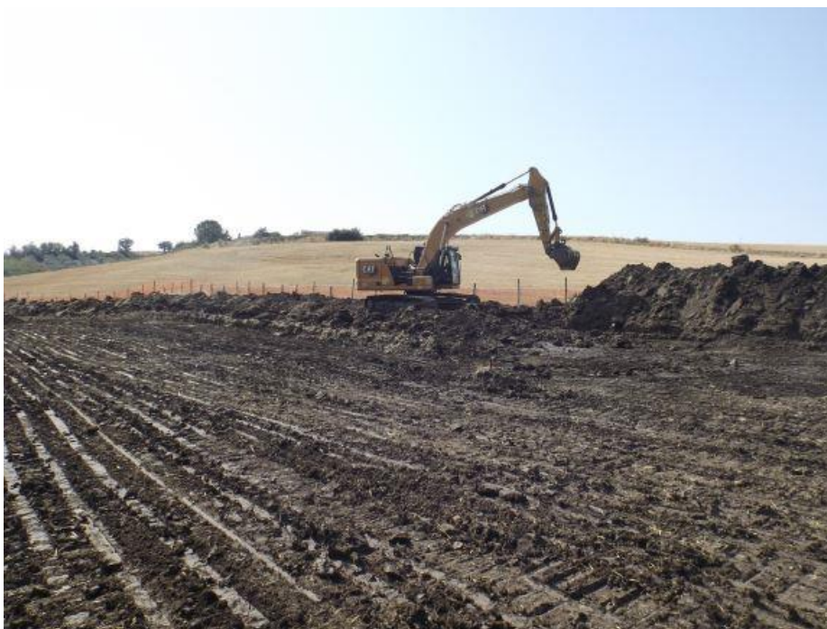
Fig. 2 – Fase di apertura pista con accantonamento dello strato superficiale di humus
