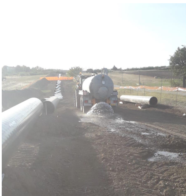
Fig. 2 – Bagnatura della pista di lavoro durante la fase di sfilamento delle tubazioni
