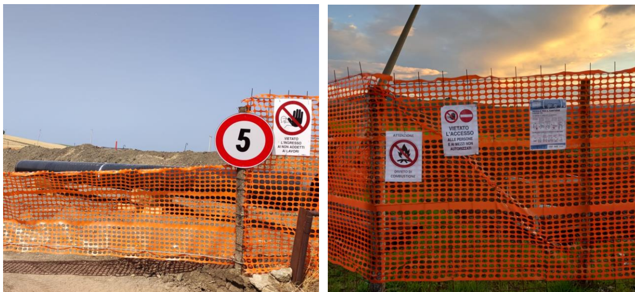
Fig. 1 – Cartellonistica di cantiere installata in corrispondenza degli accessi alle aree di lavoro
