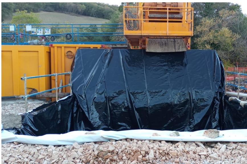
*Fig. 3 - area deposito smarino – posa in opera di telo impermeabile*
