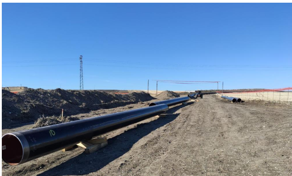
Fig. 1 – Tubazione sfilata in situ ed adagiata su stock in legno
