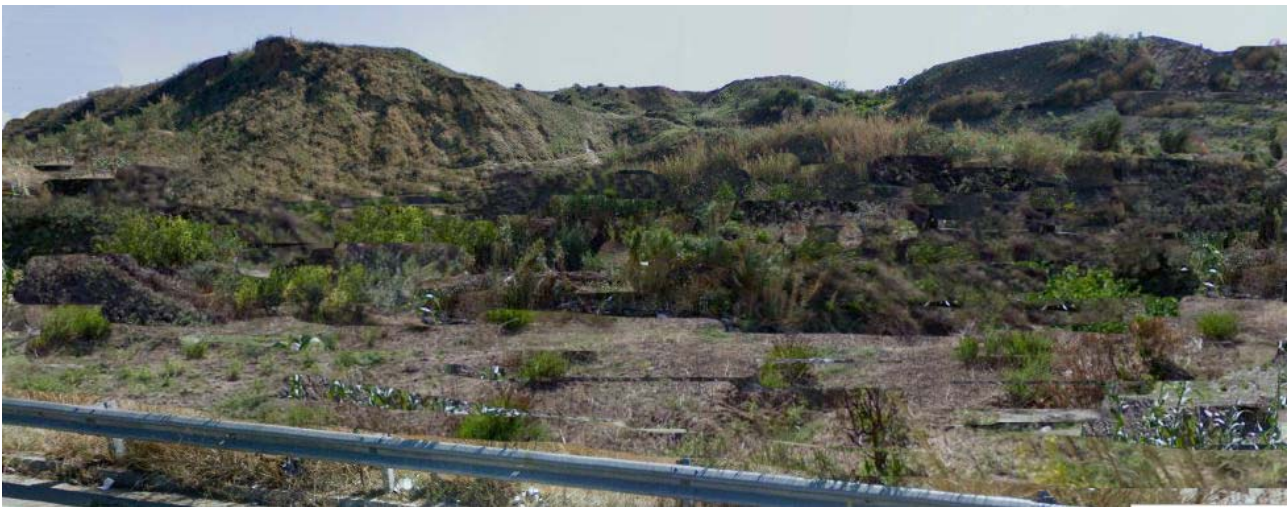
Figura 6.4: Vista area di intervento (post intervento)
