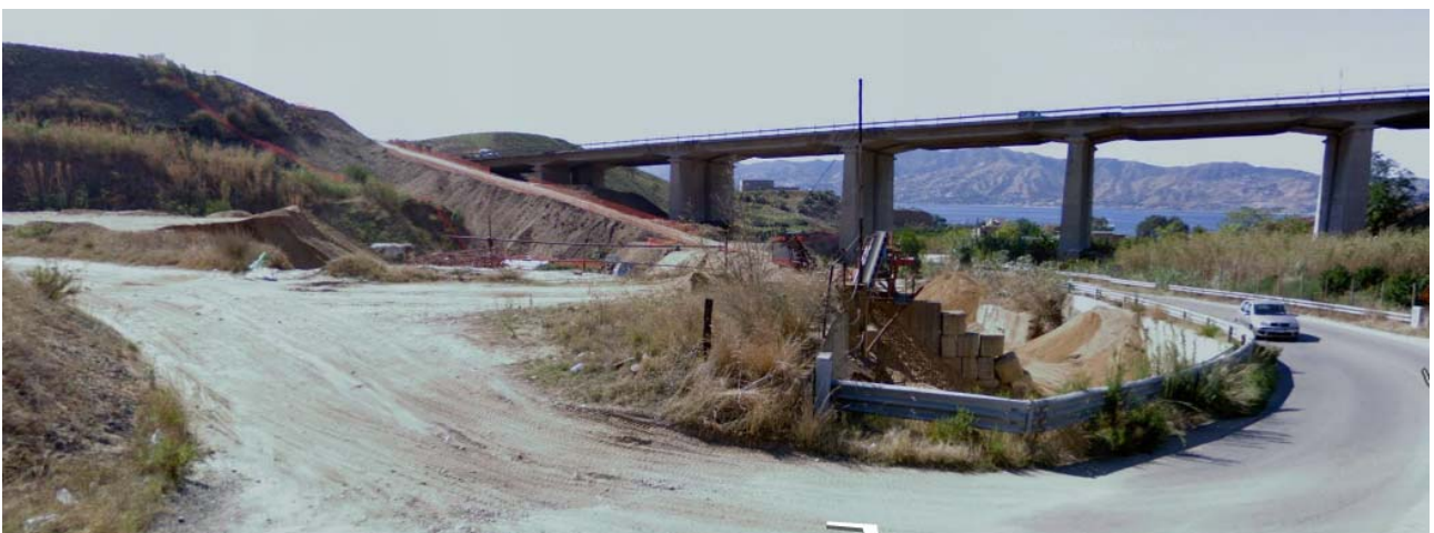
Figura 1.4: Area degradata (accesso cava)
