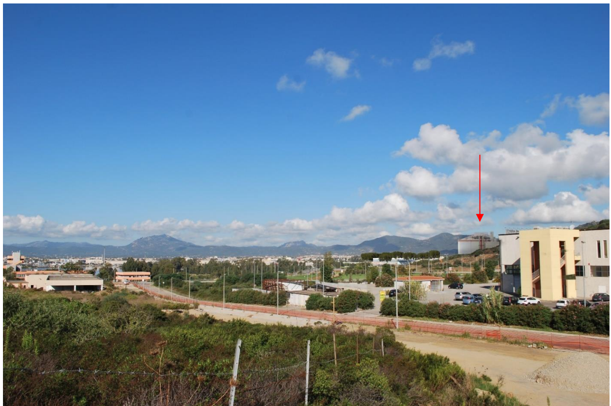
Figura IV.43 - Vista 4 ante e post operam
