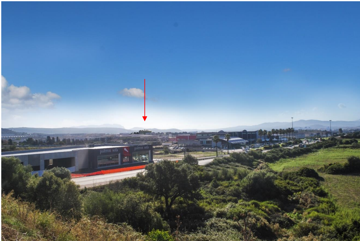
Figura IV.41 - Vista 1 ante e post operam
