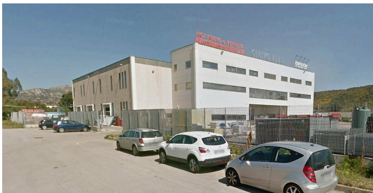
Figura 5 - Ricettore R2 fabbricato commerciale
