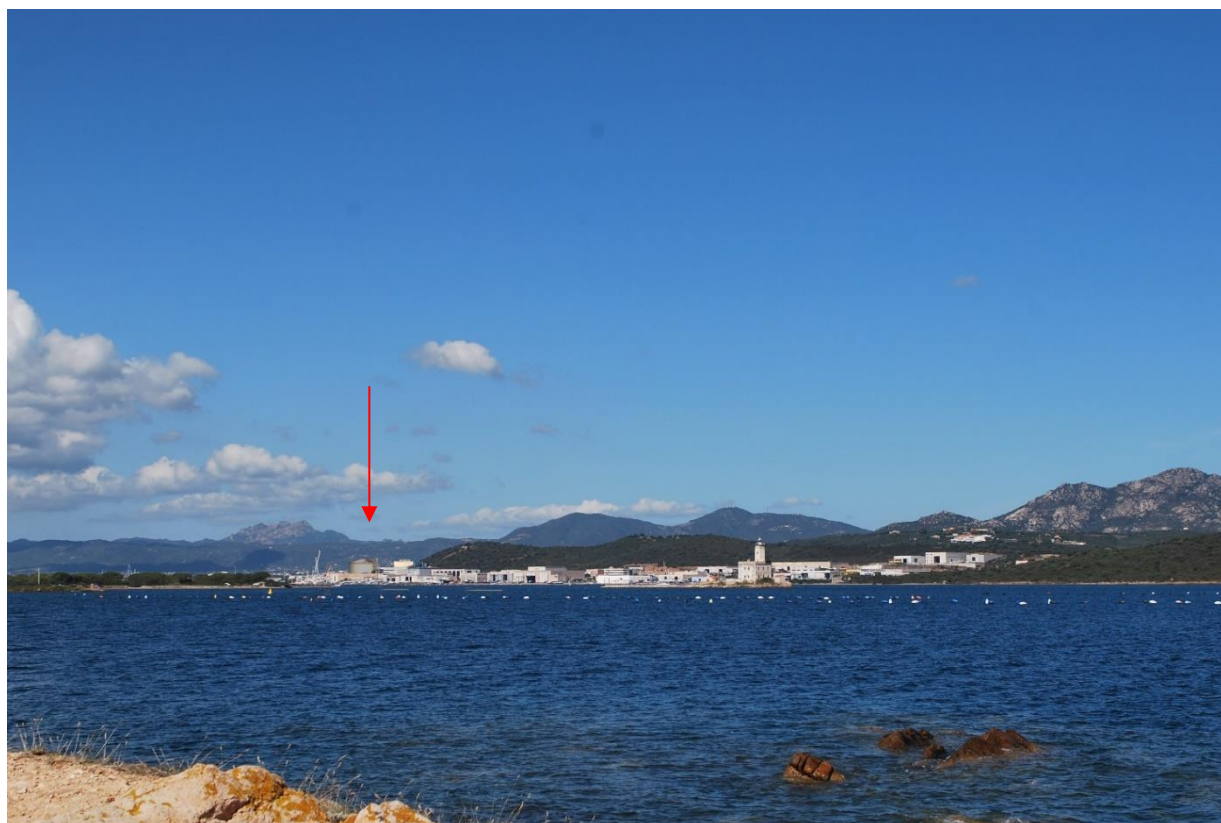
Figura 35 - Vista 8 ante e post operam
