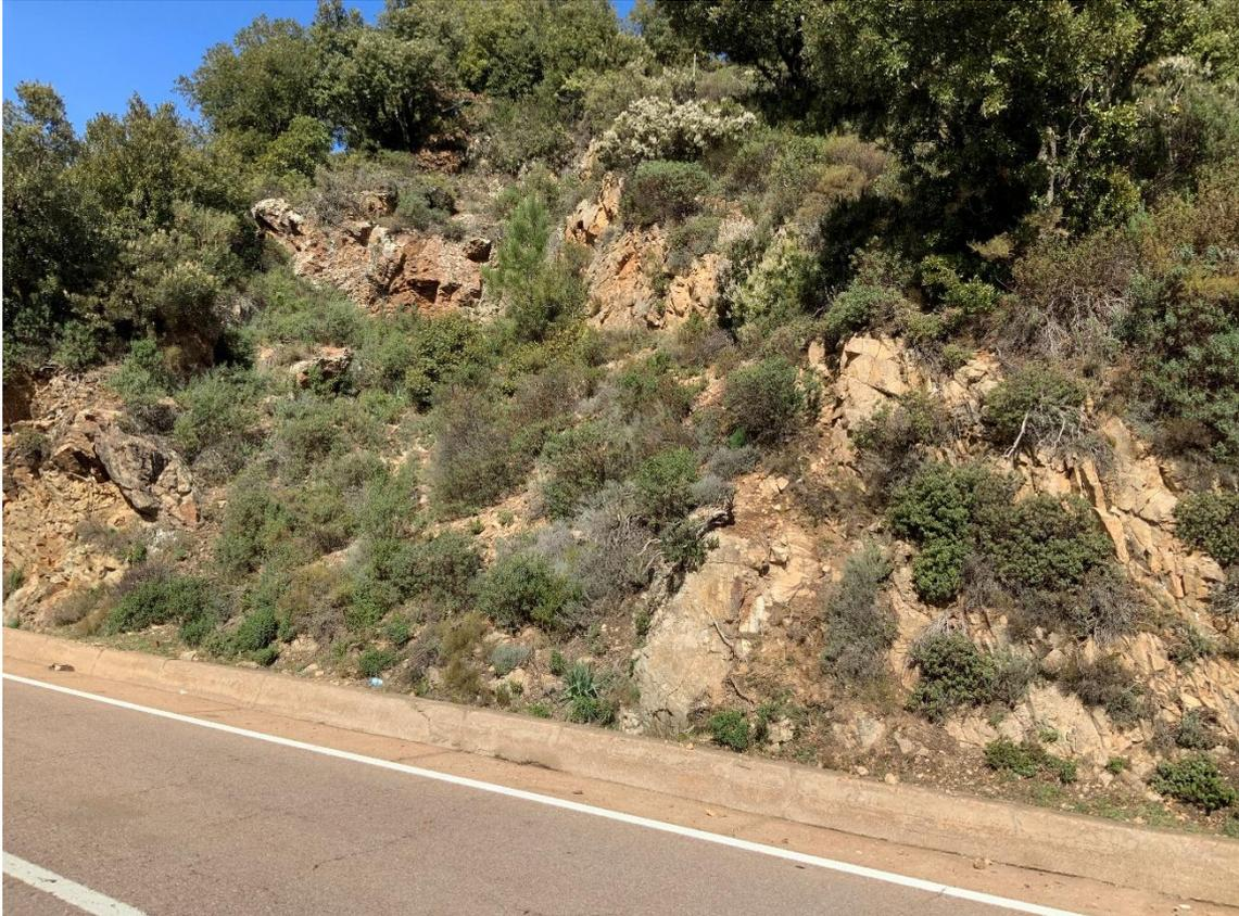
*Figura 17 – Scarpata antropica in rocce metamorfiche intensamente fratturate tra il km 4+100 e il km 4+350, interessata da distacco di blocchi e fenomeni di crollo in roccia s.l..*
