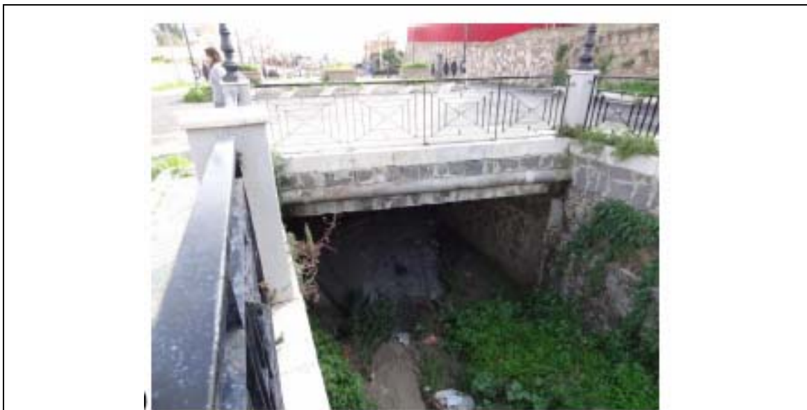
Foto n° 14: Torrente Ciaramita: Manufatto T2_A: sezione di imbocco a monte
