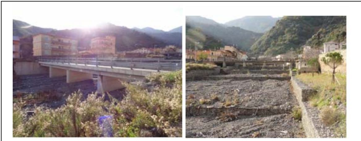
Foto n° 27: Torrente San Filippo: Manufatti P1c_SF e P1d_SF: vista da valle
