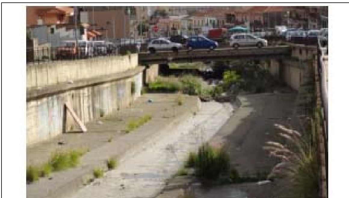
Foto n° 8: Torrente Annunziata: Manufatto M11b_A
