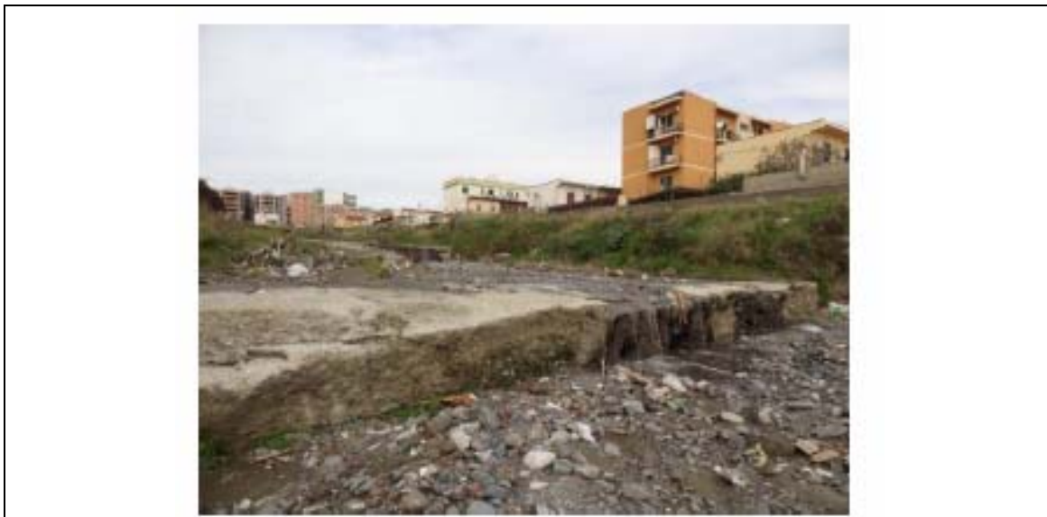
Foto n° 5: Torrente San Filippo: Tratto a monte manufatto P8_SF, vista da valle
