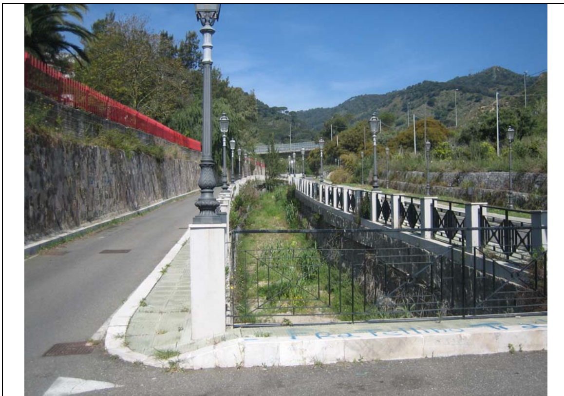
Foto n° 17: Torrente Ciaramita: tratto alveo a monte dal manufatto T2_A vista da valle
