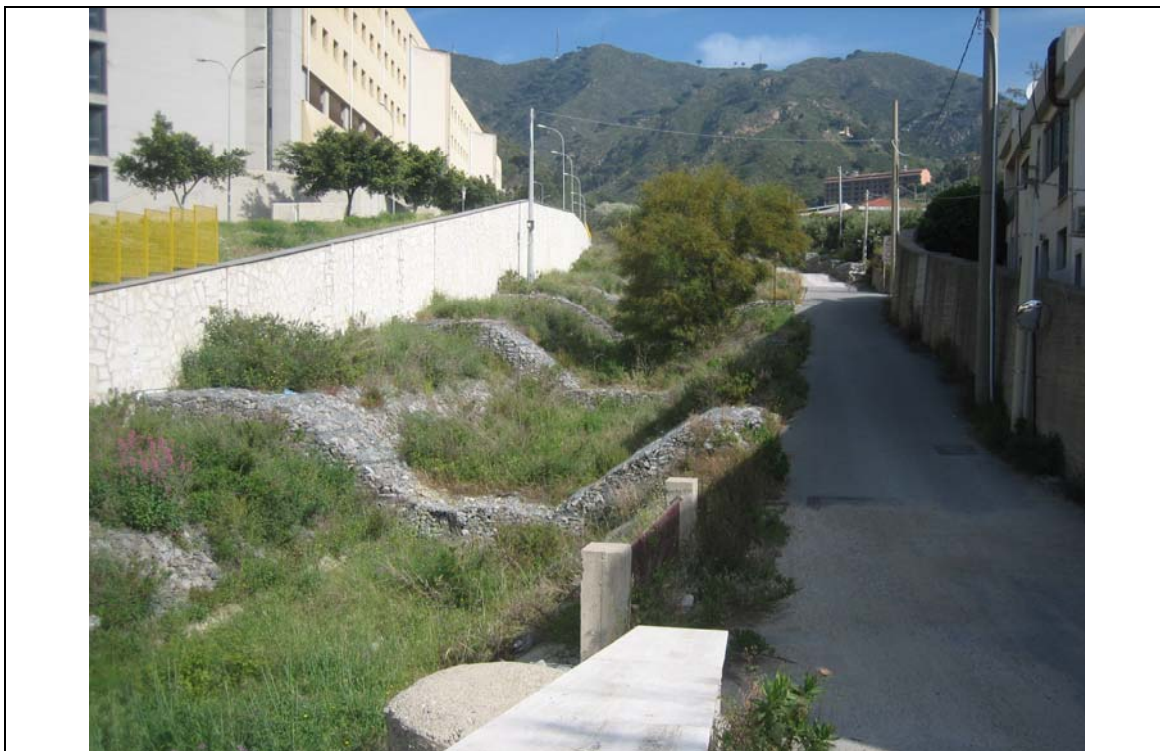
Foto n° 24: Torrente Ciccia: Inalveazione con briglie
