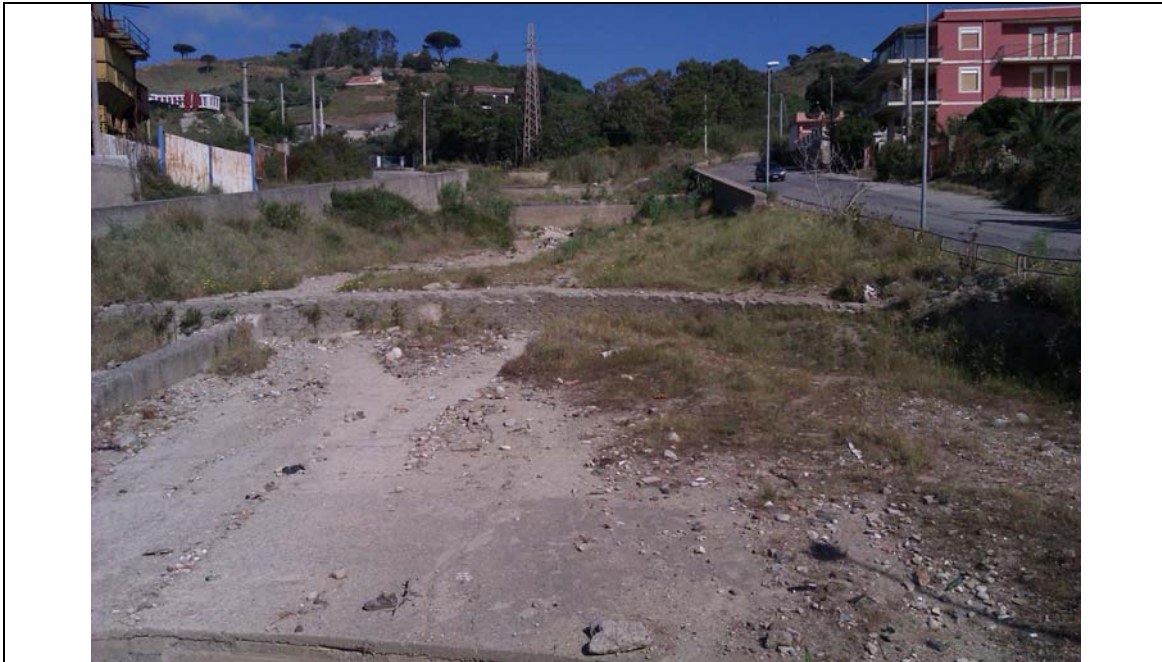
Foto n° 1: Torrente Guardia: vista da valle dei salti di fondo e delle briglie presenti poco a valle della confluenza tra il T. Guardia da destra ed il T. Curcuraci da sinistra
