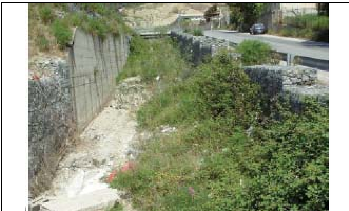
Foto n° 16: Torrente Pace: Tratto canalizzato tra pareti in gabbioni fra i manufatti M8_P e M9_P
