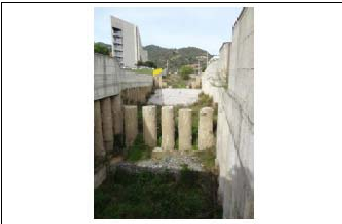
Foto n° 22: Torrente Ciccia: Vasca sghiaiatrice V1_A
