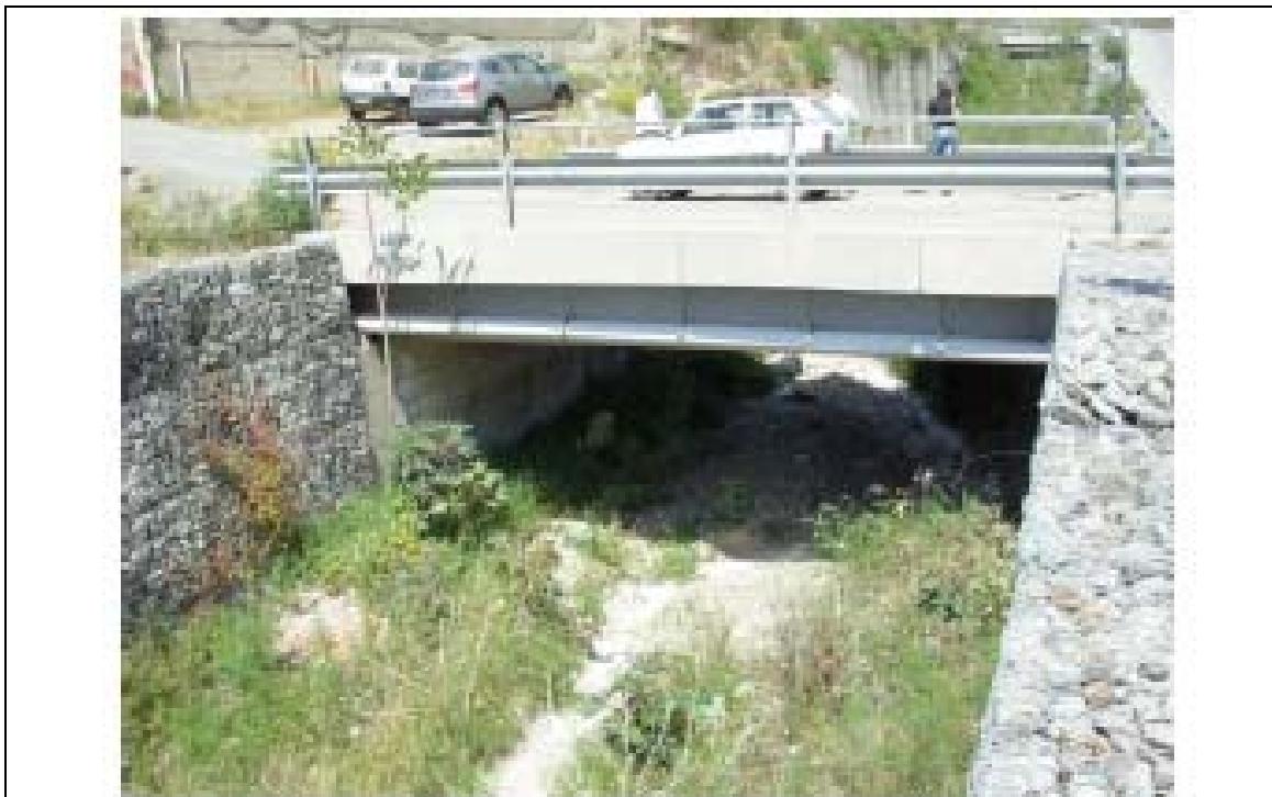
Foto n° 15: Torrente Pace: Manufatti M8_P
