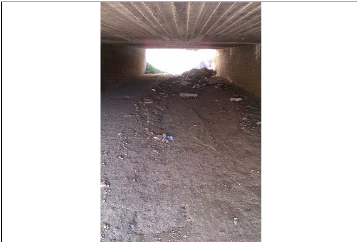
Foto n° 10: Particolare dell'interno del manufatto M1_G con vista verso valle.
