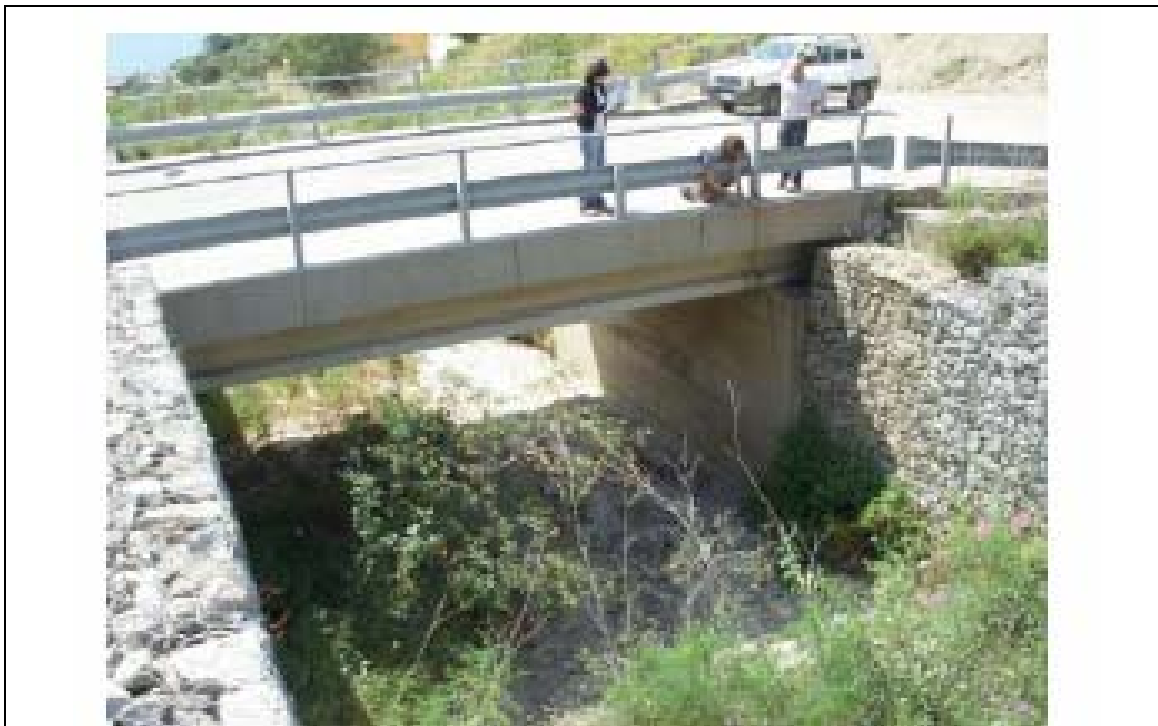
Foto n° 13: Torrente Pace: Manufatto M7_P
