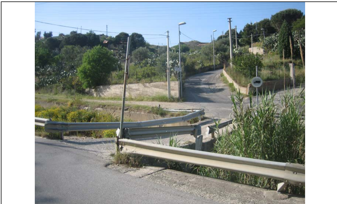
Foto n° 4: Torrente Curcuraci: attraversamento M3_Cu
