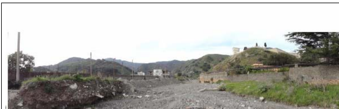
Foto n° 25: Torrente San Filippo: Tratto a monte dello svincolo autostradale
