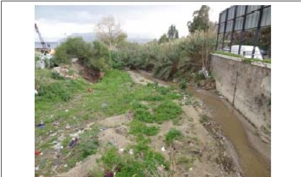
Foto n° 1: Torrente Annunziata: Vista da monte del tratto alla foce
