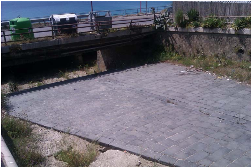
Foto n° 5: Torrente Pace: rivestimento del fondo alveo con basole di pietra lavica a monte del salto di fondo S1_P
