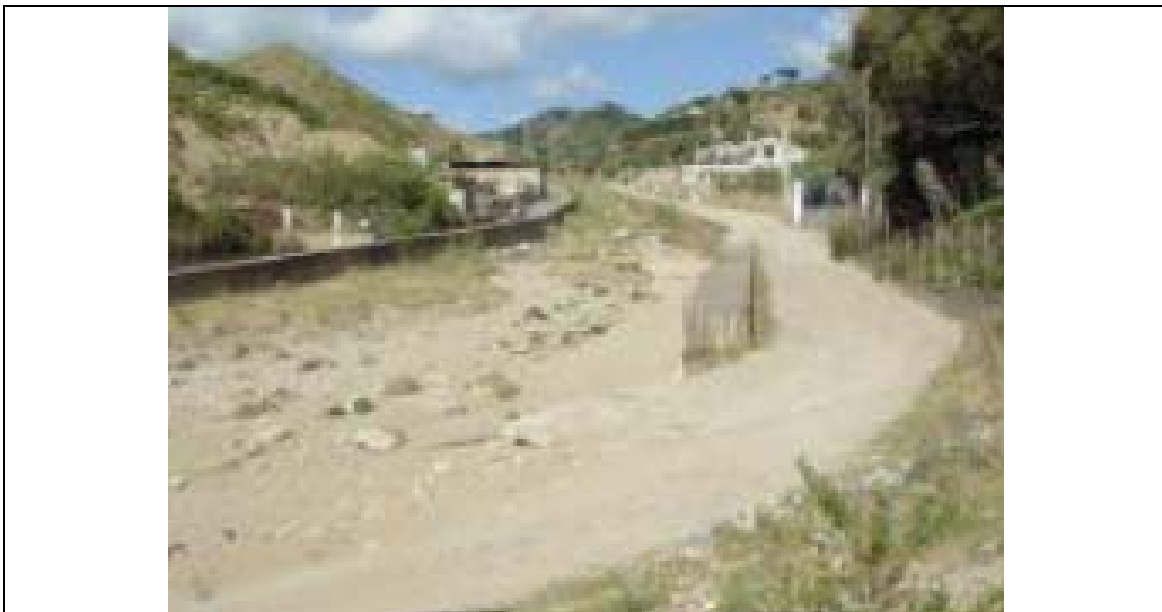
Foto n° 2: Torrente Curcuraci: attraversamento a raso in corrispondenza della confluenza con il T. Guardia senza arginatura, vista da valle
