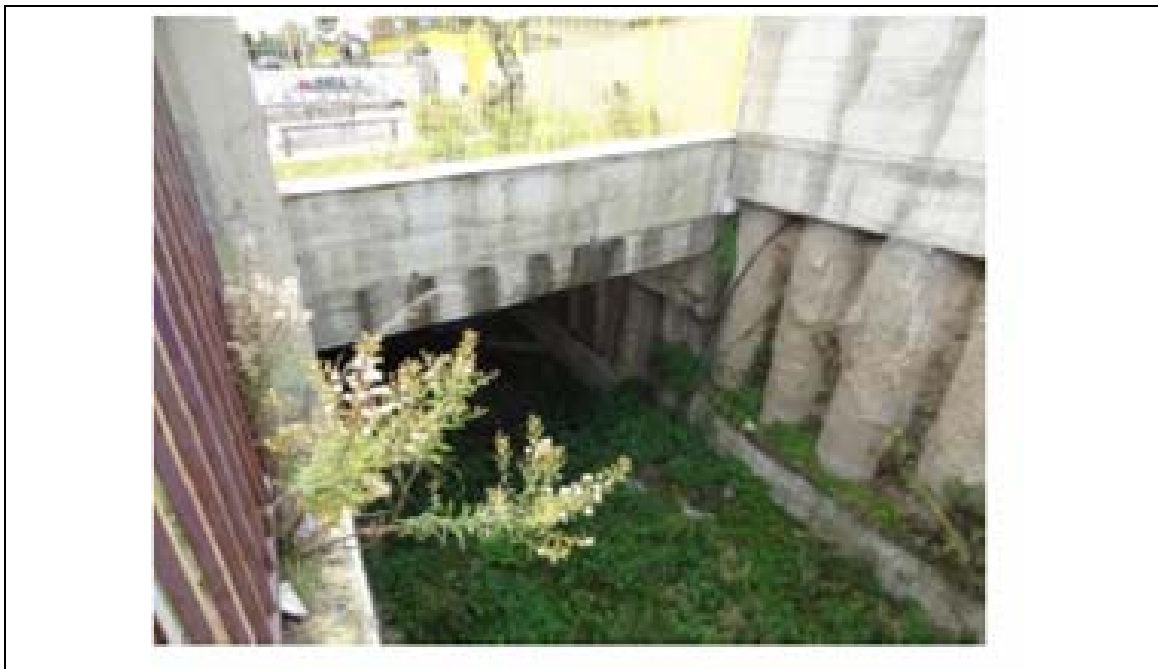
Foto n° 21: Torrente Ciccia: Sezione di imbocco de manufatto T2_A
