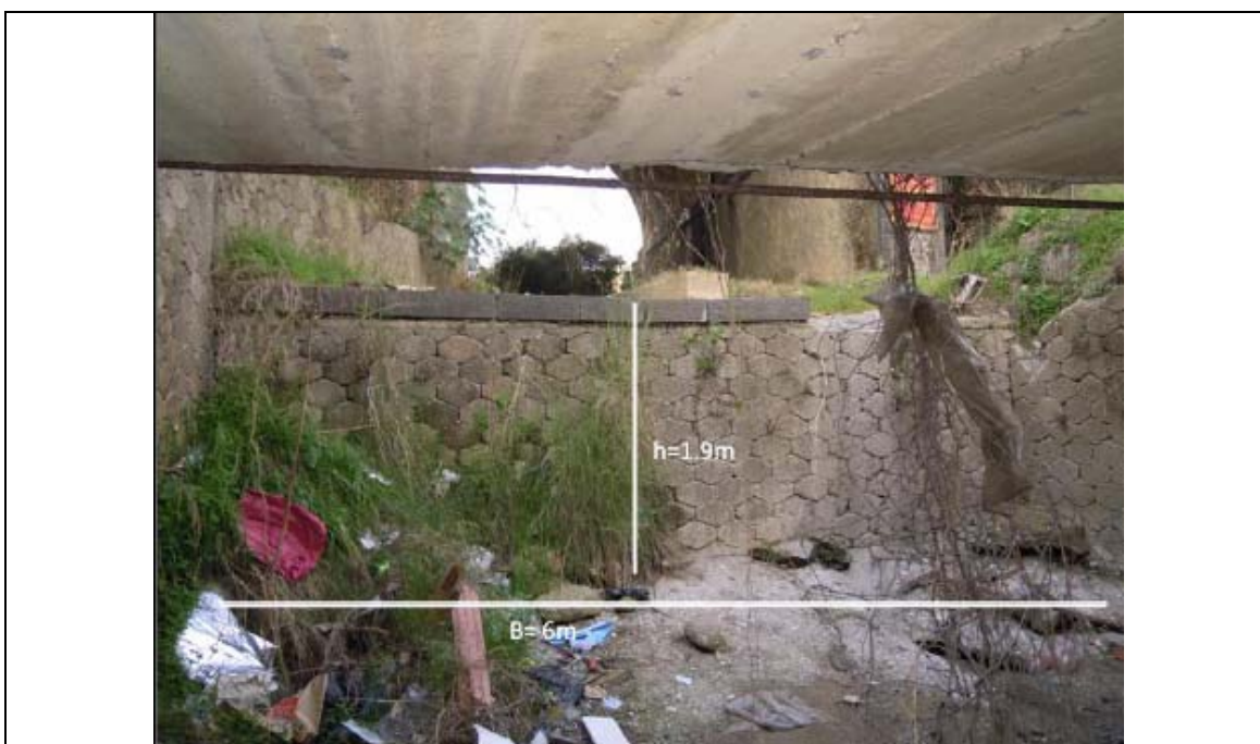
Foto n° 11: Vista da valle del salto di fondo (manufatto M1'_G) posto 2.00m a monte del manufatto M1_G
