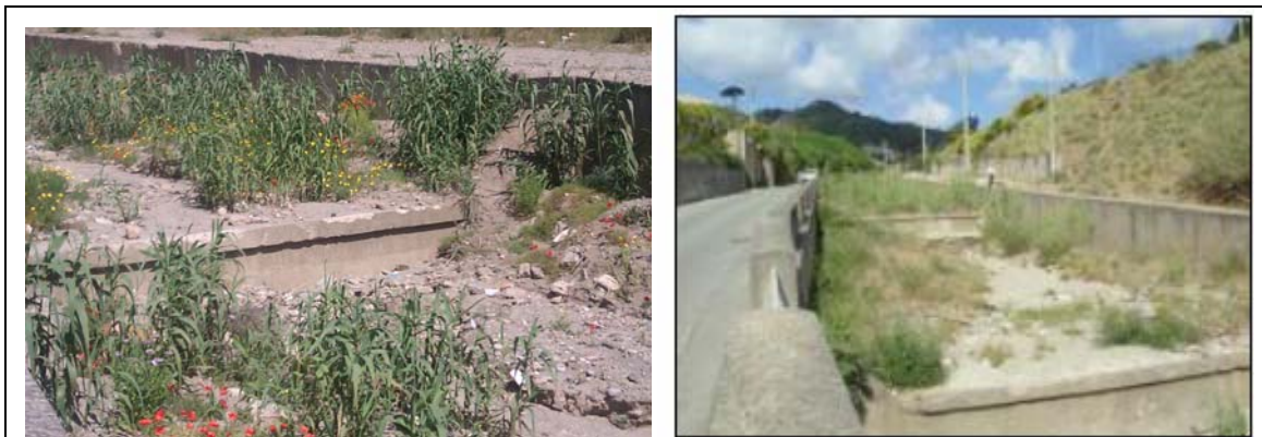
Foto n° 7: Torrente Curcuraci: alveo a monte dell'attraversamento M3_Cu: salti di fondo e muri arginali
