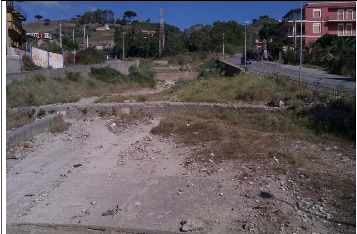
Foto n° 18: Vista da valle dei salti di fondo e delle briglie nel tratto a valle della confluenza tra il T. Guardia da destra ed il T. Curcuraci da sinistra.
