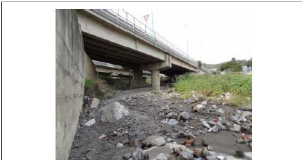
Foto n° 21: Torrente San Filippo: Svincolo autostradale: Manufatto P5_SF, vista da valle
