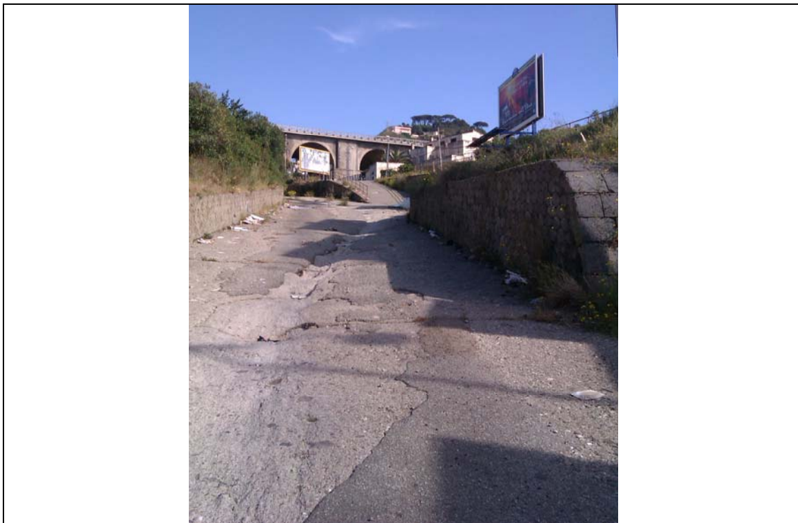
Foto n° 6: Vista da valle del restringimento della sezione del corso d'acqua a monte del manufatto M0-G.
