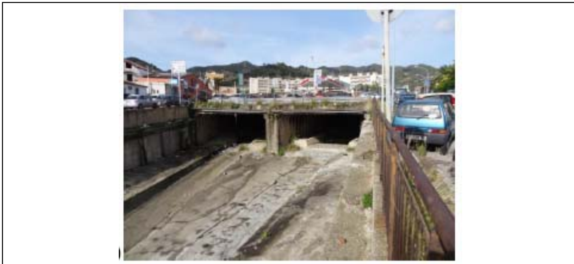
Foto n° 13: Torrente Annunziata: Manufatto T2_A: sezione di sbocco
