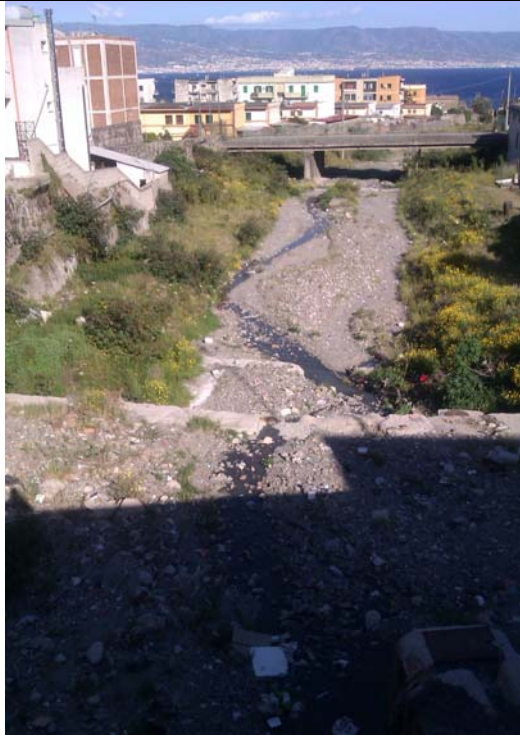
Foto n° 10: Torrente San Filippo: vista verso valle dal ponte P6_SF
