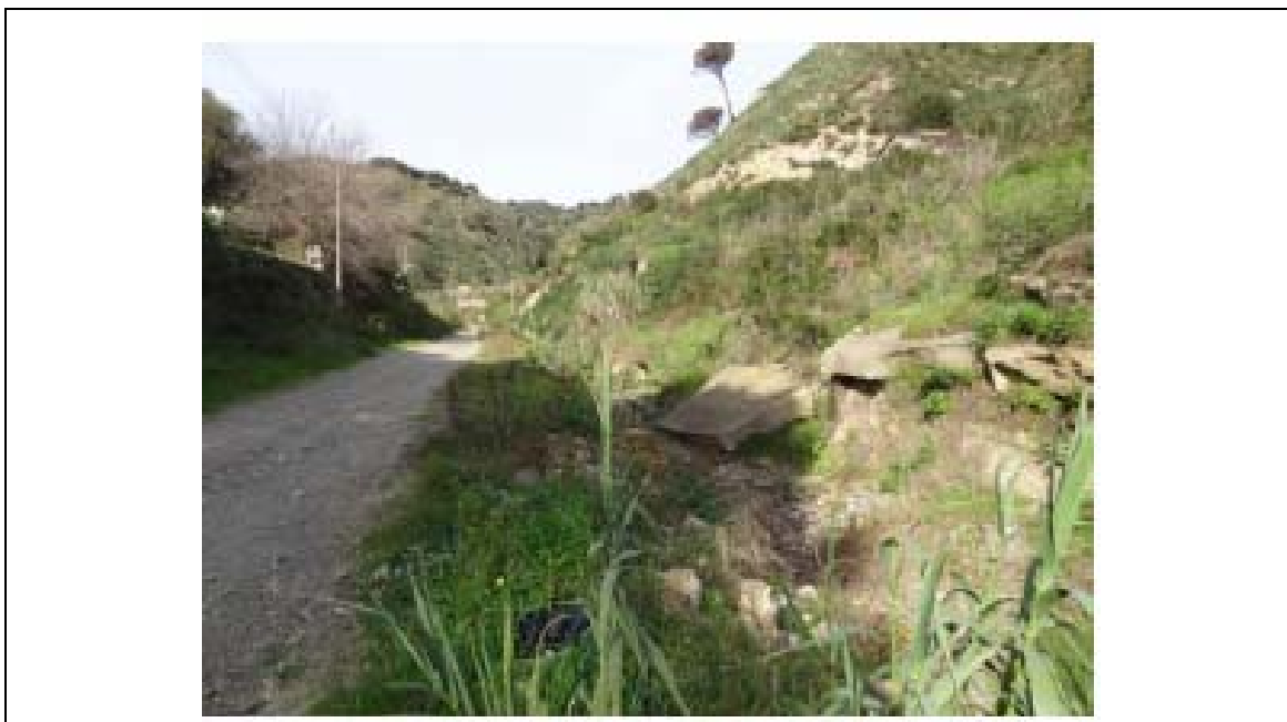
Foto n° 20: Torrente Ciaramita: tratto di monte con erosione e dissesti
