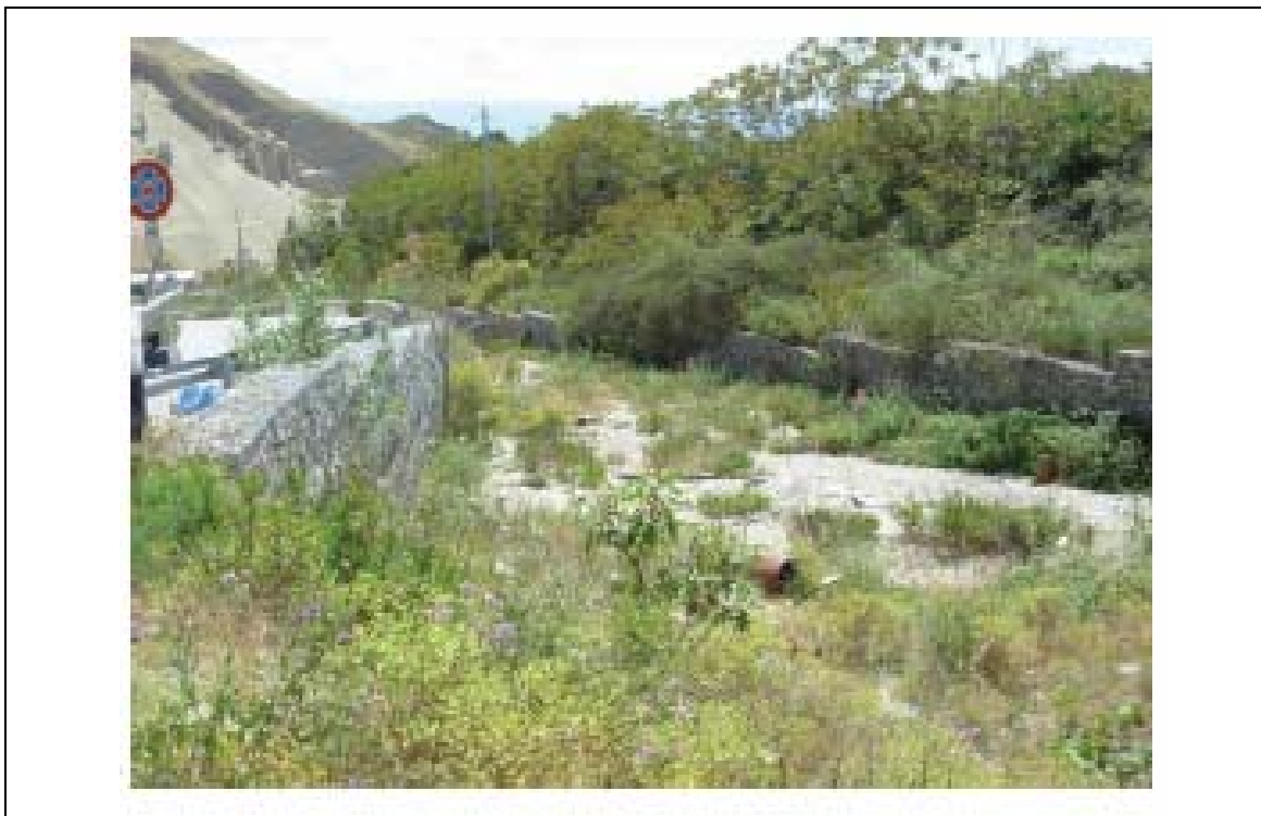
Foto n° 17: Torrente Pace: Tratto di testata della sistemazione idraulica
