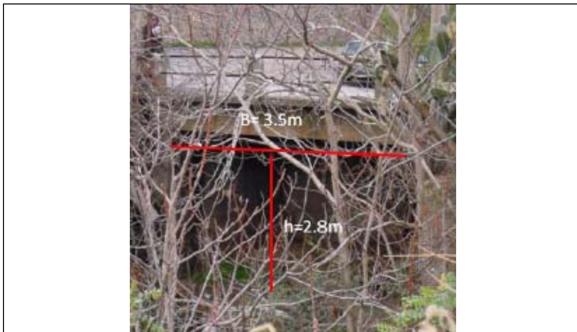
Foto n° 26: Ponte a soletta piana (manufatto M5_G) nel tratto a monte della confluenza.
