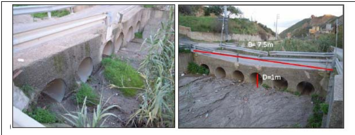
Foto n° 5: Torrente Curcuraci: attraversamento M3_Cu (vista da valle e vista da monte)
