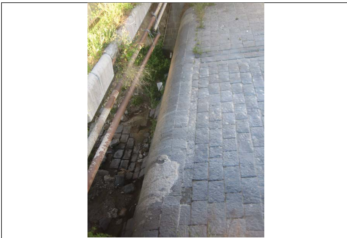
Foto n° 4: Torrente Pace: salto di fondo S1_P: profilo sfiorante
