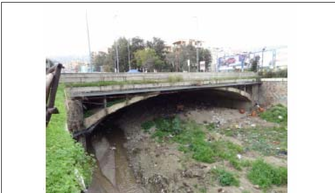
Foto n° 2: Torrente Annunziata: Vista da valle dello sbocco del manufatto M10_A
