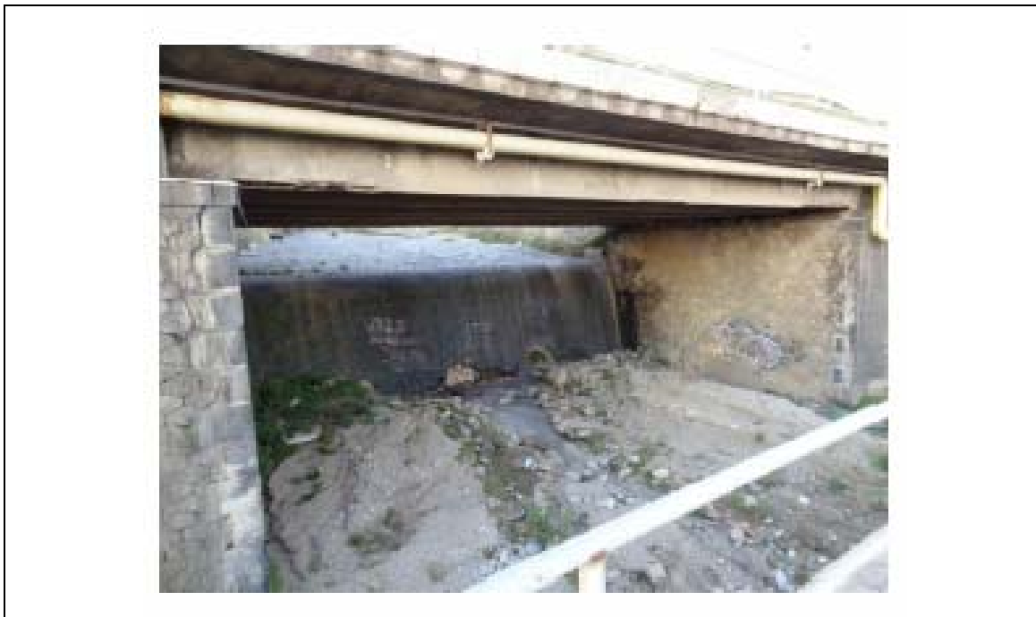
Foto n° 3: Torrente Pace: manufatto P2_P e salto di fondo S1_P: vista da valle
