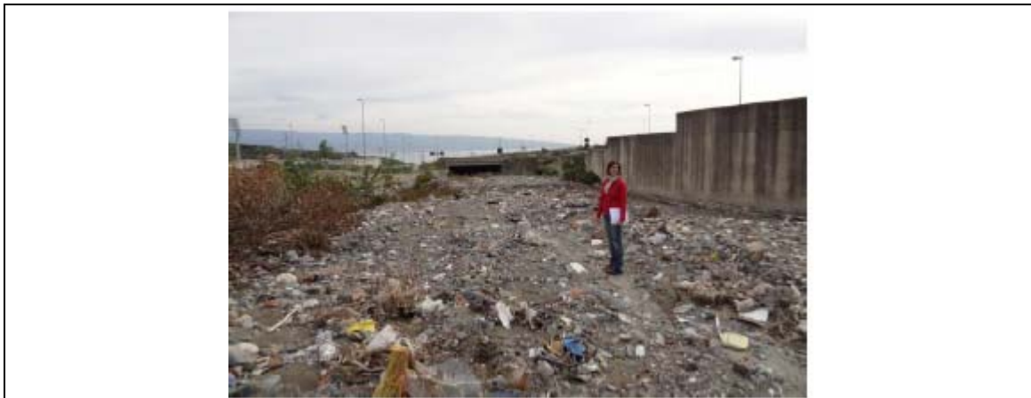
Foto n° 20: Torrente San Filippo: Tratto a monte del manufatto T1_SF
