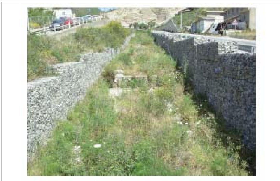
Foto n° 12: Torrente Pace: Tratto canalizzato tra pareti in gabbioni
