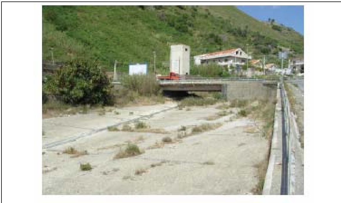
Foto n° 11: Torrente Pace: Attraversamento M5_P: vista da valle
