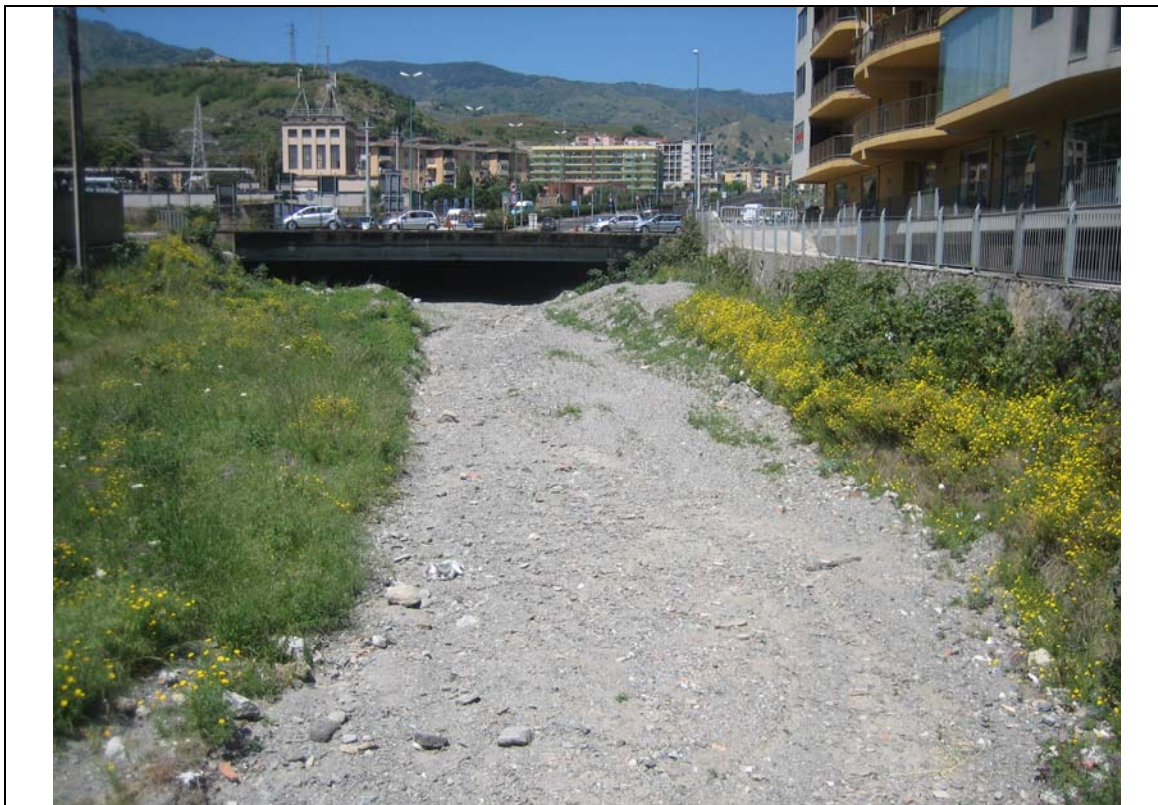
Foto n° 11: Torrente San Filippo: Manufatto T2_SF sulla SS114: vista da valle
