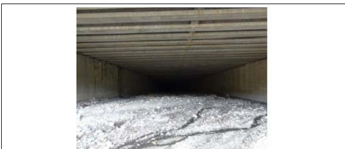
Foto n° 19: Torrente San Filippo: interno interrato del manufatto T1_SF
