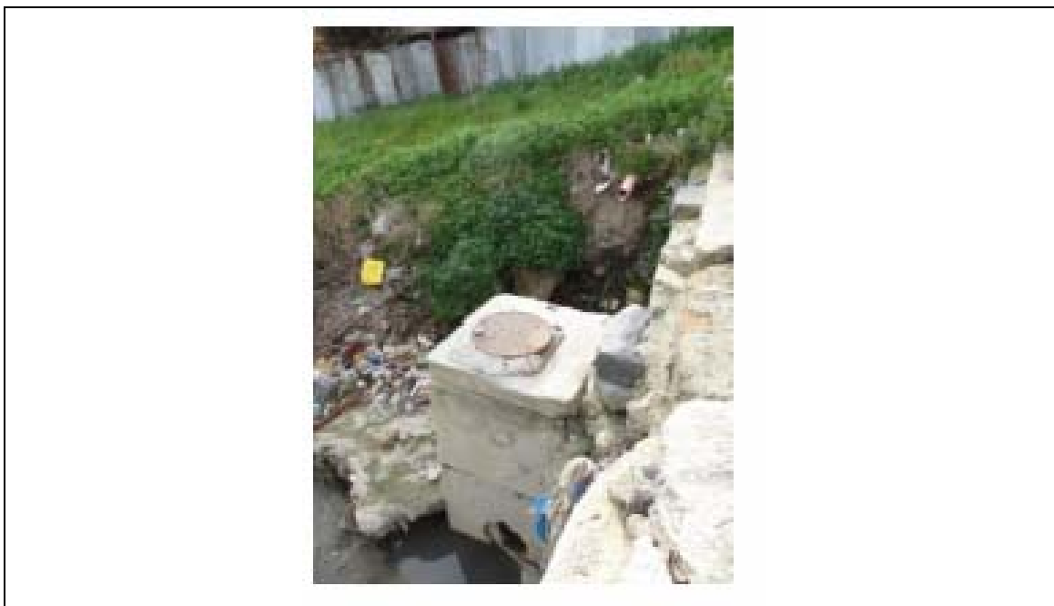
Foto n° 8: Torrente San Filippo: Pozzetto di scarico in prossimità del manufatto P6_SF
