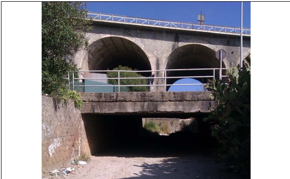
Foto n° 9: Vista da valle del ponte a soletta piana (manufatto M1_G) con sezione utile pari a 6.00m x 2.00m a monte del manufatto M0_G.
