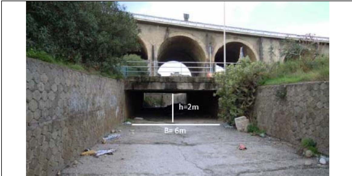
Foto n° 8: Vista da valle del ponte a soletta piana (manufatto M1_G)
