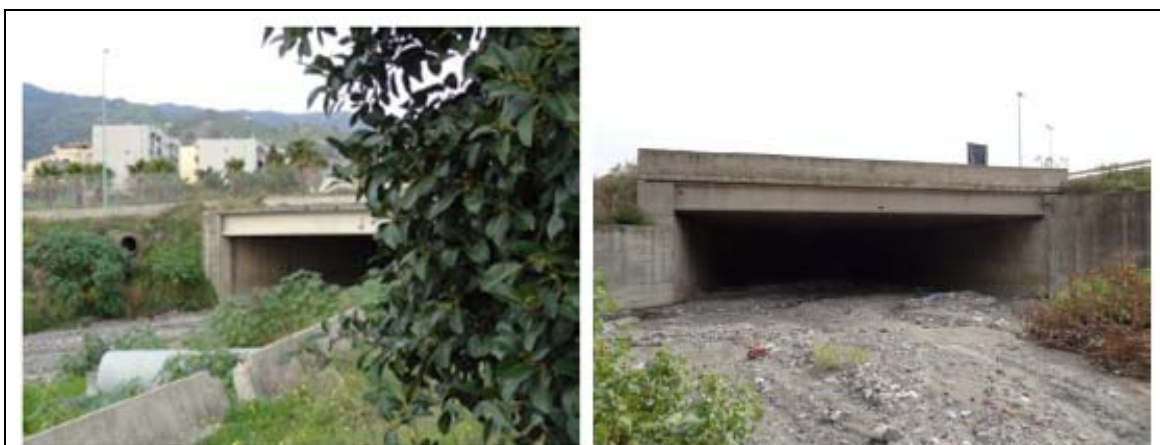
Foto n° 18: Torrente San Filippo: Manufatto T1_SF, sezione di valle e di monte
