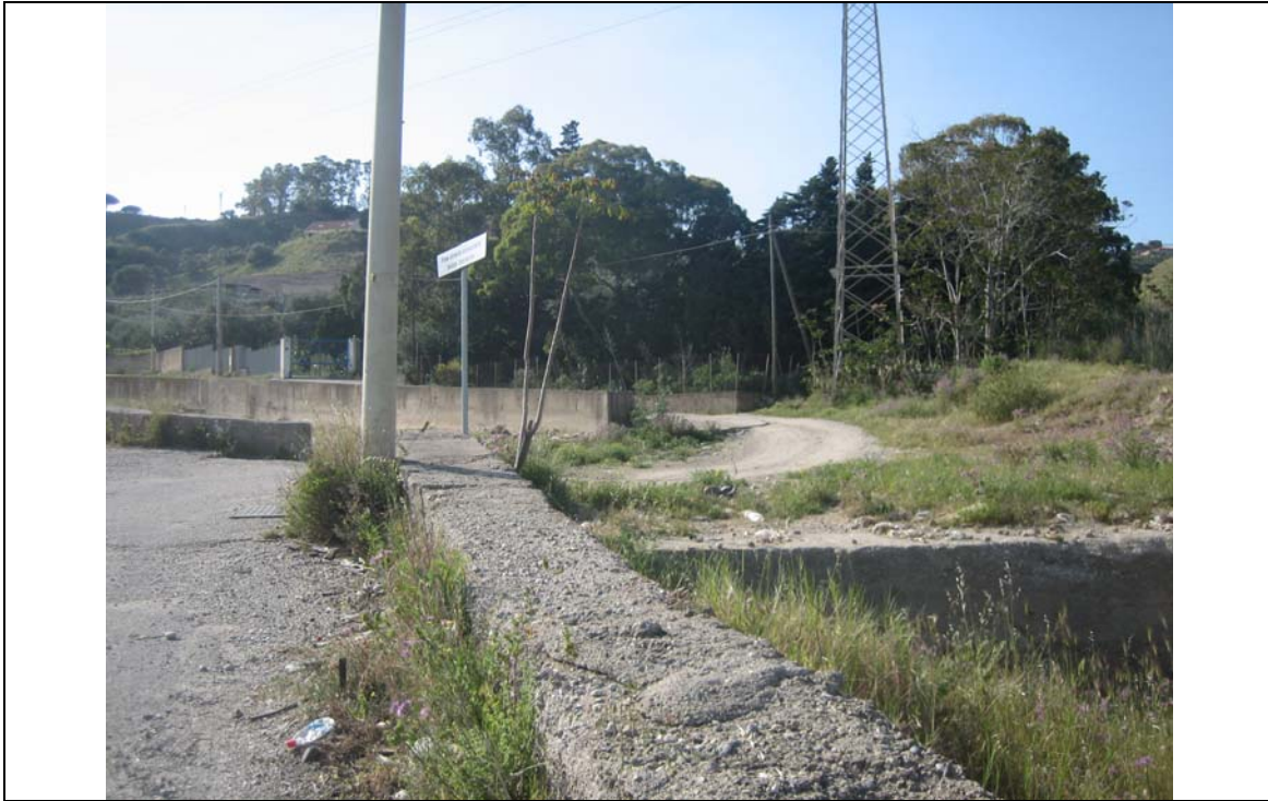
Foto n° 3: Torrente Curcuraci: attraversamento a raso in corrispondenza della confluenza con il T. Guardia senza arginatura, vista da valle
