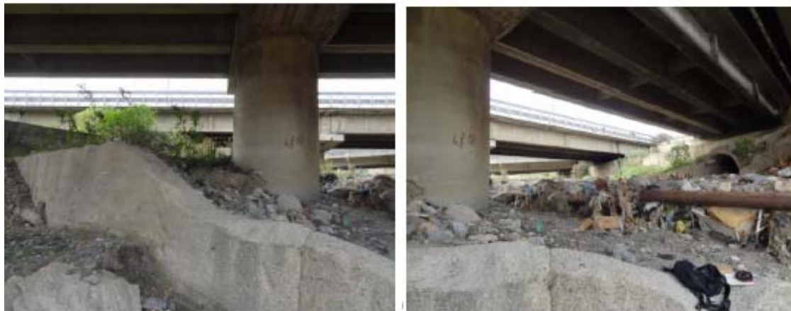
Foto n° 22: Torrente San Filippo: Manufatto P4_SF, viste da valle
