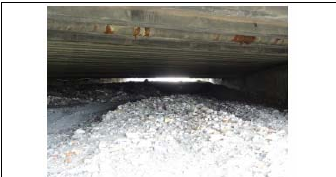
Foto n° 12: Torrente San Filippo: Manufatto T2_SF, vista interrimento interno
