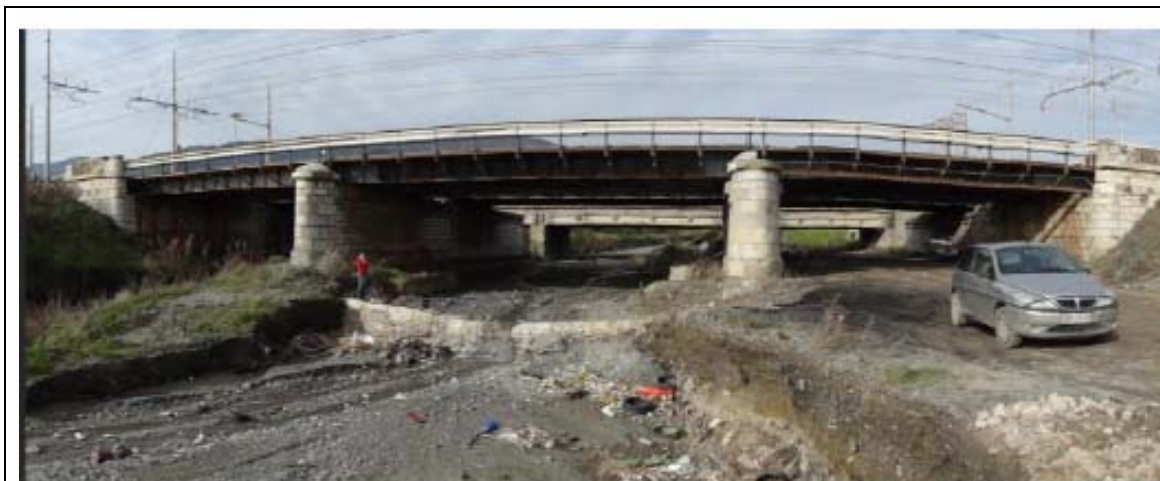
Foto n° 4: Torrente San Filippo: Attraversamenti ferroviari P9_SF e P8_SF: vista da valle
