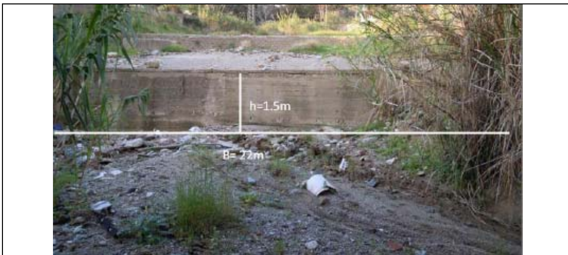
Foto n° 17: Vista da valle del salto di fondo (manufatto M2'_G) a monte del ponte a soletta piana M2_G
