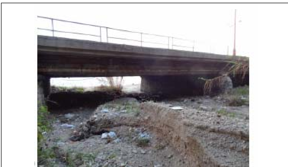
Foto n° 2: Torrente Pace: manufatto P3_P: vista da monte
