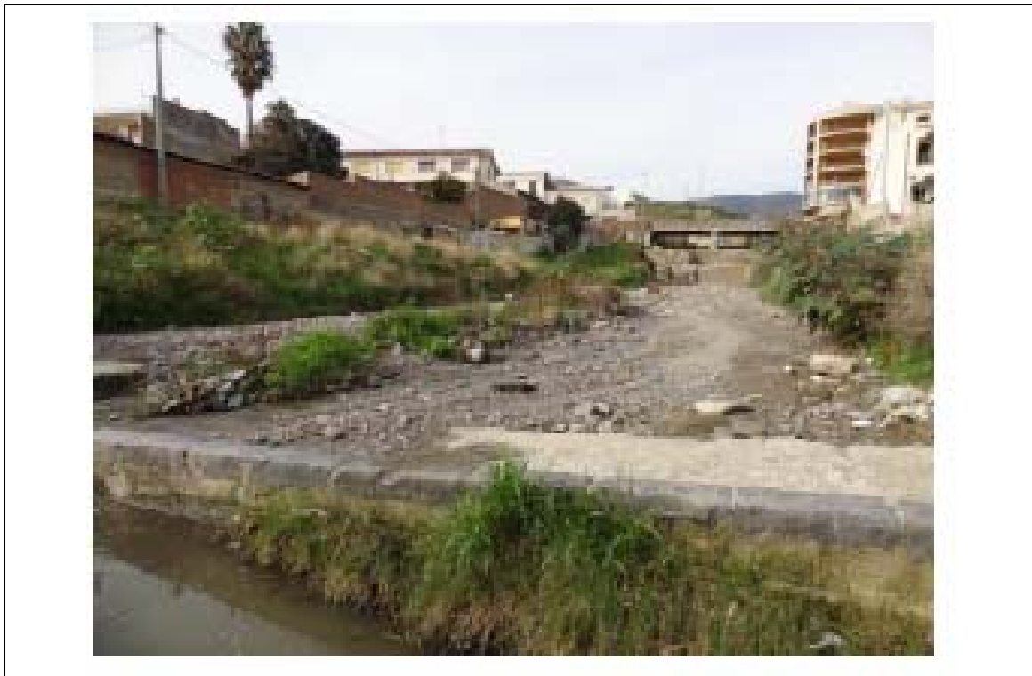
Foto n° 3: Torrente San Filippo: Tratto tra la SS114 e la foce, vista verso monte
