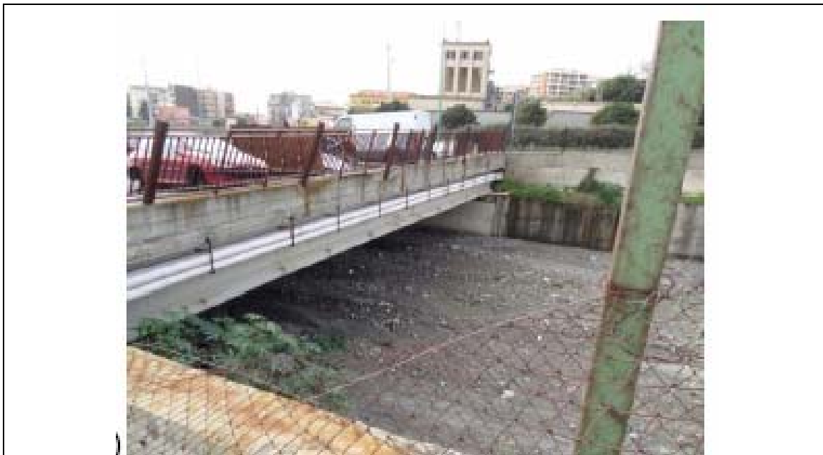
Foto n° 13: Torrente San Filippo: Manufatto T2_SF, vista imbocco di monte
