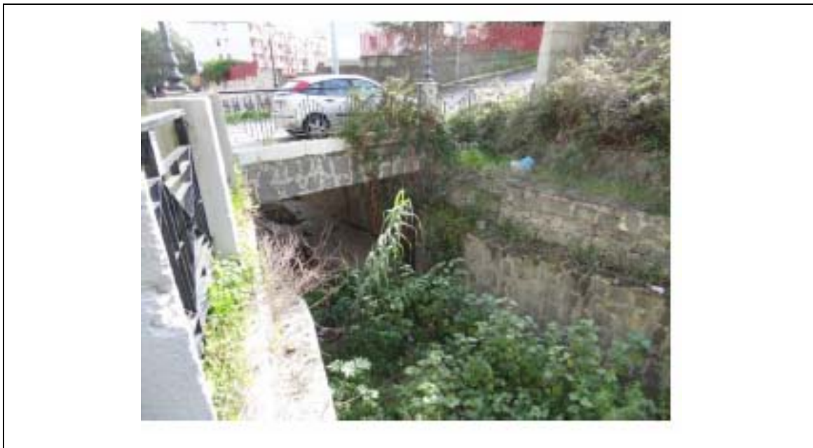
Foto n° 19: Torrente Ciaramita: ponte a soletta piana M14_A
