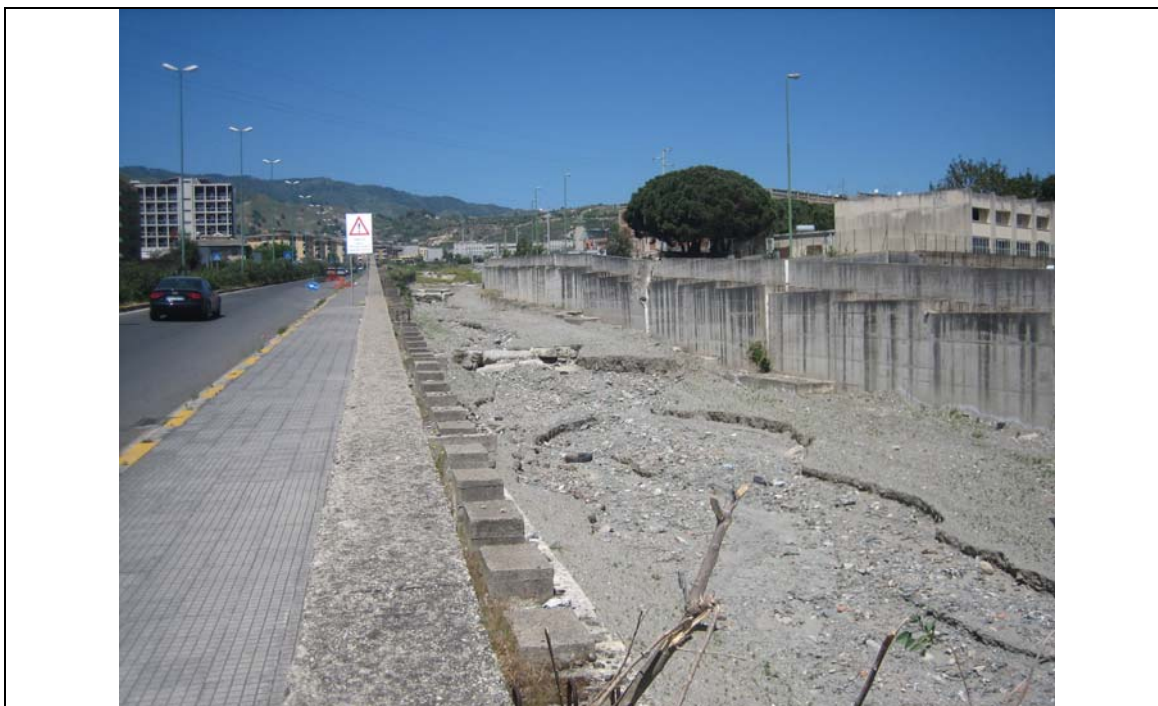
Foto n° 14: Torrente San Filippo: Tratto a monte del manufatto T2_SF fra muri d'argine in c.a.
