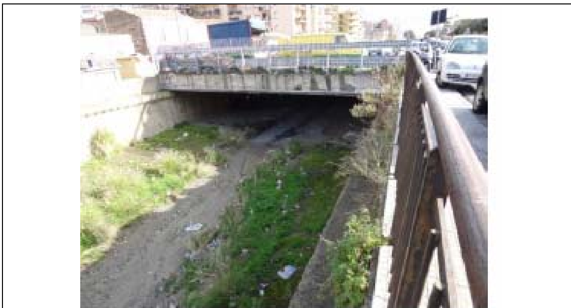
Foto n° 4: Torrente Annunziata: Vista da monte dell'imbocco del manufatto M10_A
