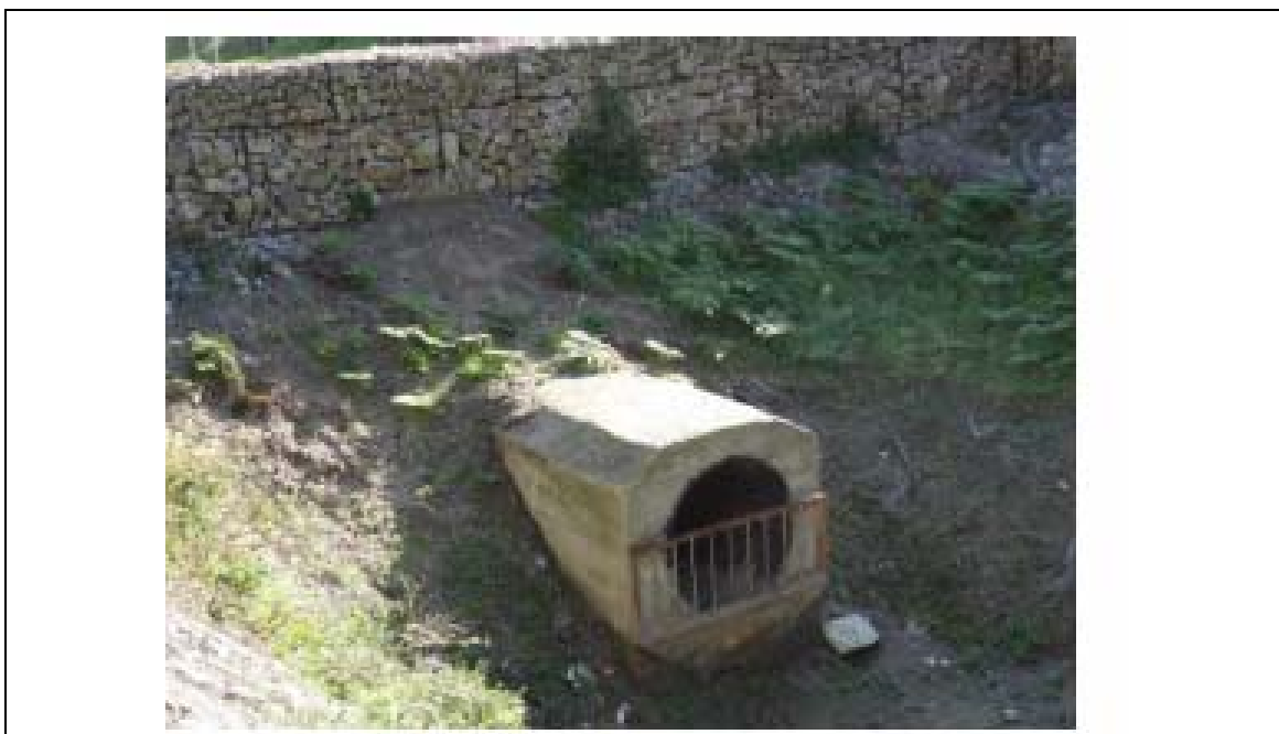
Foto n° 26: Torrente Ciccia: Manufatto T1_A: imbocco del tombino diam 1 m
