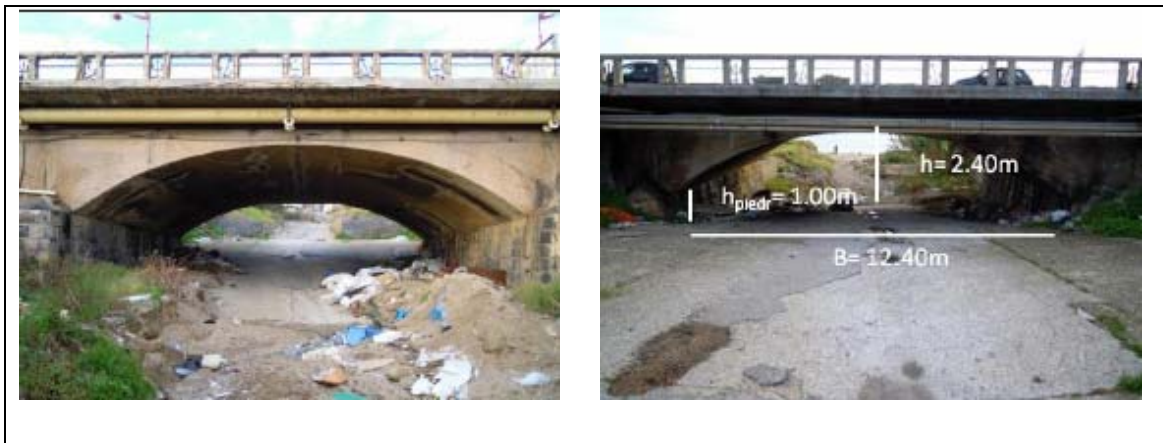
Foto n° 1 – Ponte ad arco (M0_G) - Vista da valle verso monte Foto n° 2 – Ponte ad arco (M0_G) - Vista da monte verso valle
